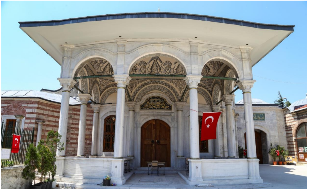
Türbe Giriş Revağının Günümüzdeki Vaziyeti
