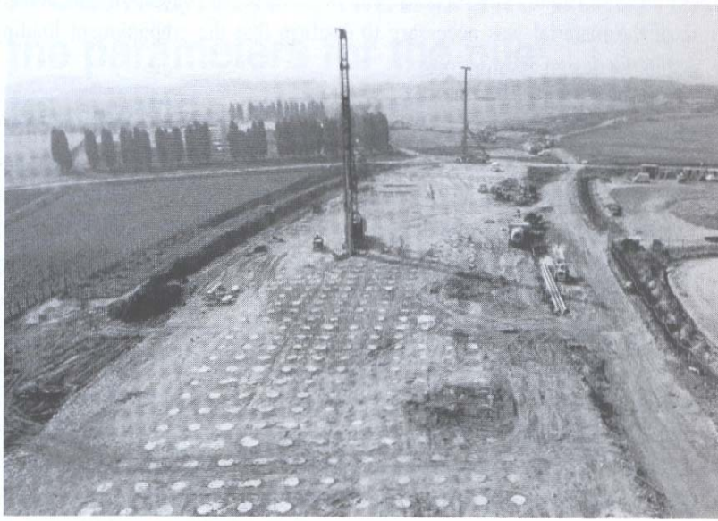
Şekil 4.15. Kazık destekli dolgunun kazık çakma işleri
