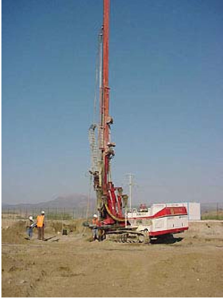
Şekil 5.18 Jet enjeksiyon makinesi
