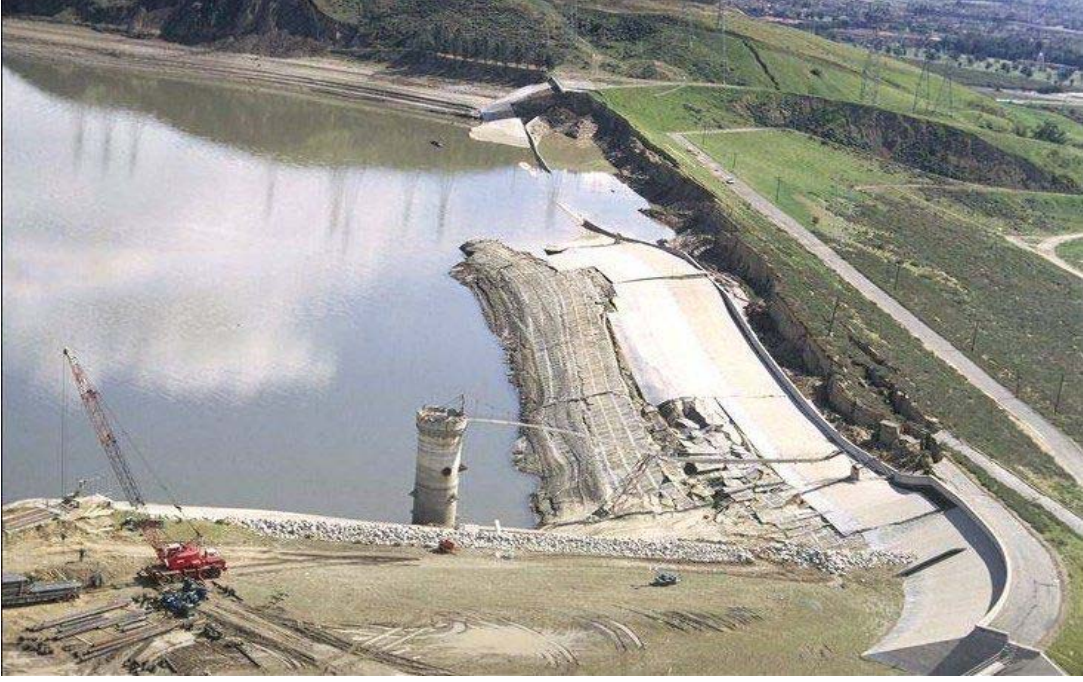
Şekil 2.1 San Fernando barajında sıvılaşma etkisi [1]
