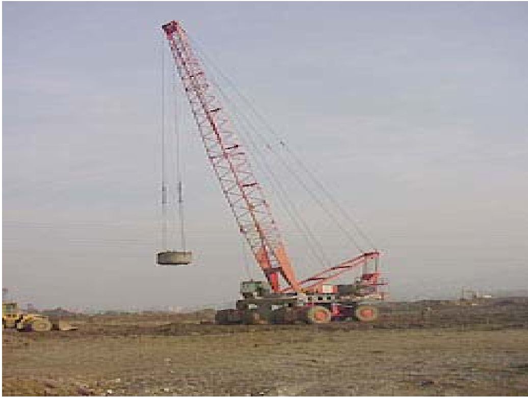
Şekil 5.27 Tipik bir dinamik kompaksiyon düzeneği
