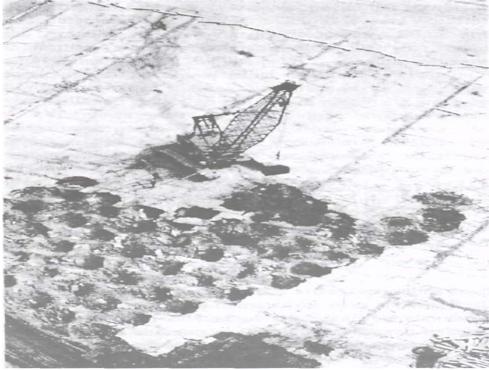
Şekil 5.26 Dinamik kompaksiyonla zemin sıkıştırma işlemi [1]
