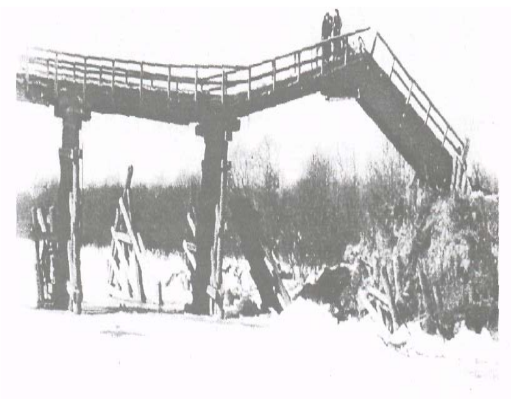
Şekil 2.2 Alaska'da 1964 Good Friday depreminde meydana gelen bir yanal yayılmanın küçük bir köprüye etkisi [1]
