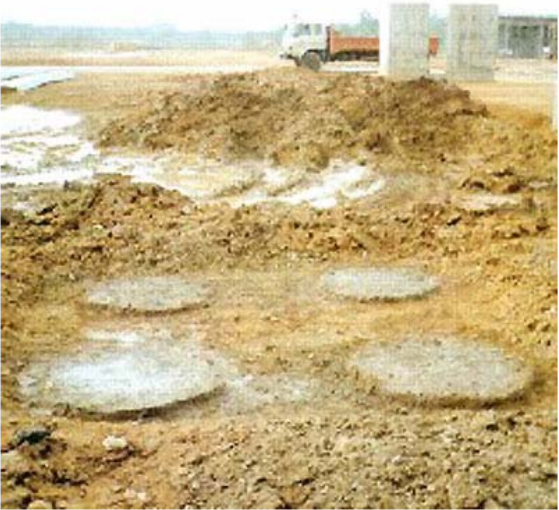
Şekil 5.10 Derin karıştırma tekniği ile oluşturulmuş çimento-zemin kolonları
