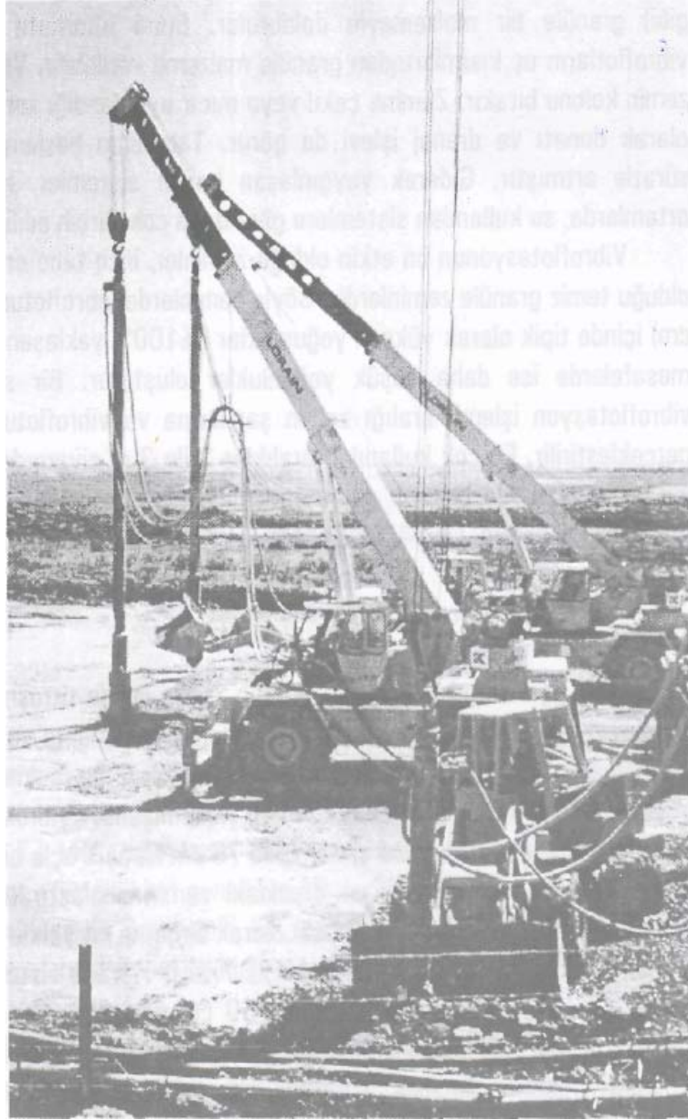
Şekil 5.21 California'da bir atık su arıtma tesisinde sıvılaştırılabilir zeminleri sıkıştıran vibroflotlar.[1]
