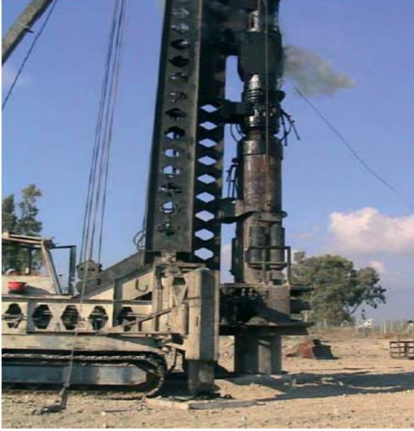
Şekil 5.40 Taş kolon uygulaması[24]
