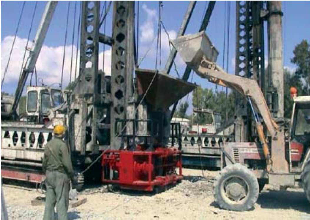
Şekil 5.41 Taş kolon da kullanılan ekipman[24]
