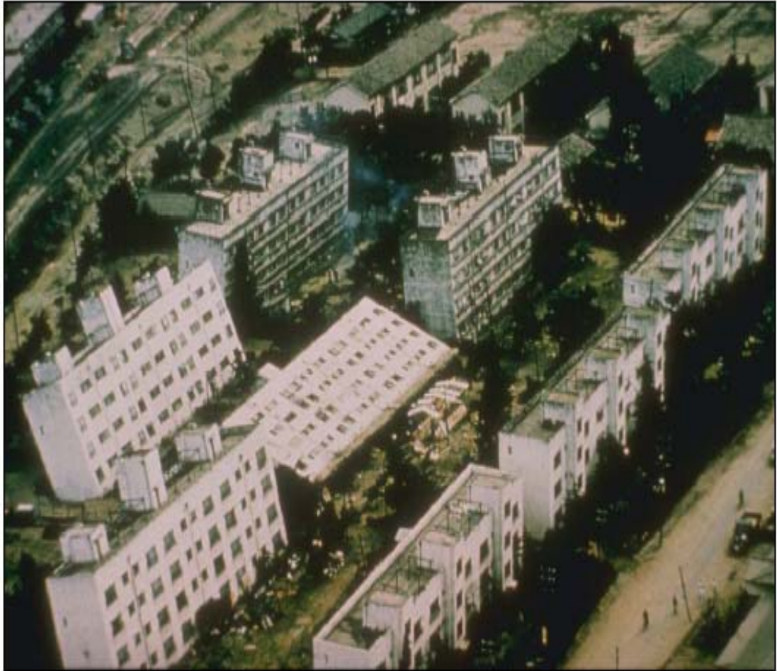
Şekil 2.3 Japonya Niigata depreminde sıvılaşma sonucu devrilen binalar [1]
