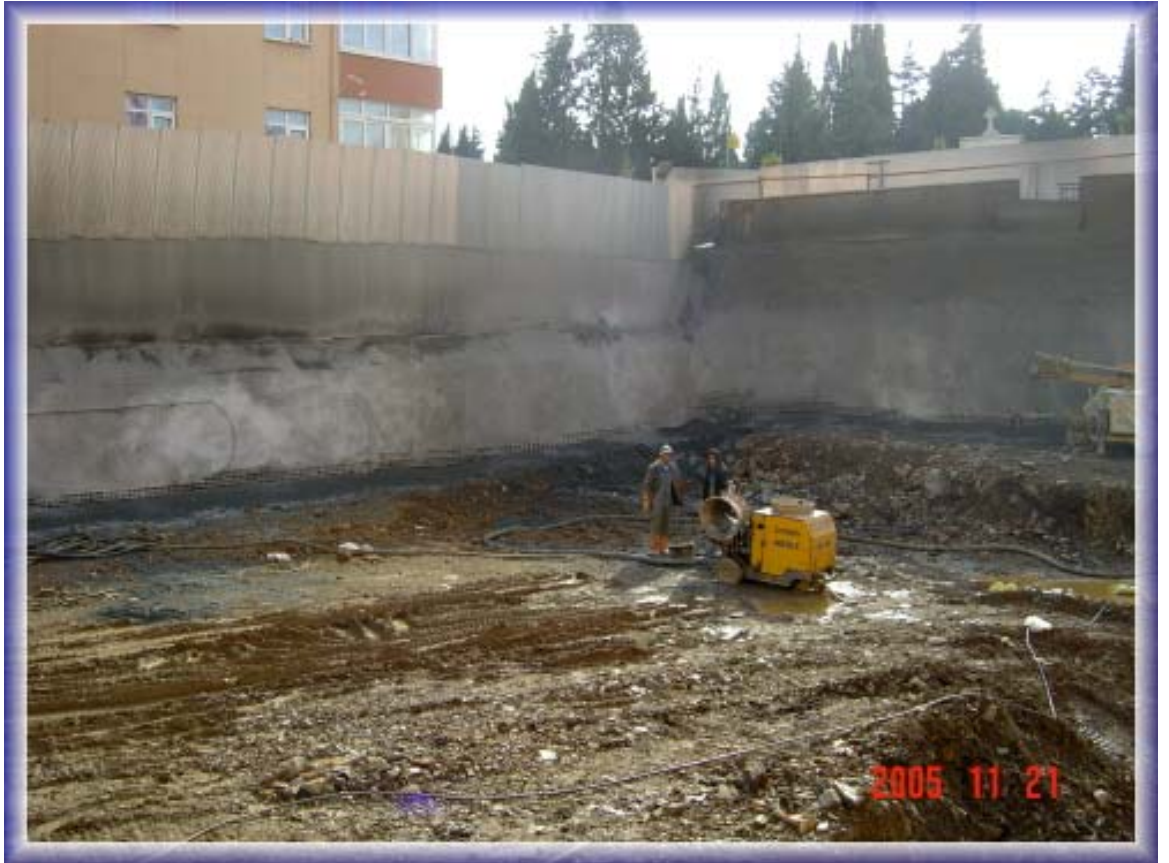
Resim 2 Püskürtme beton ve zemin çivili İksa sistemi
