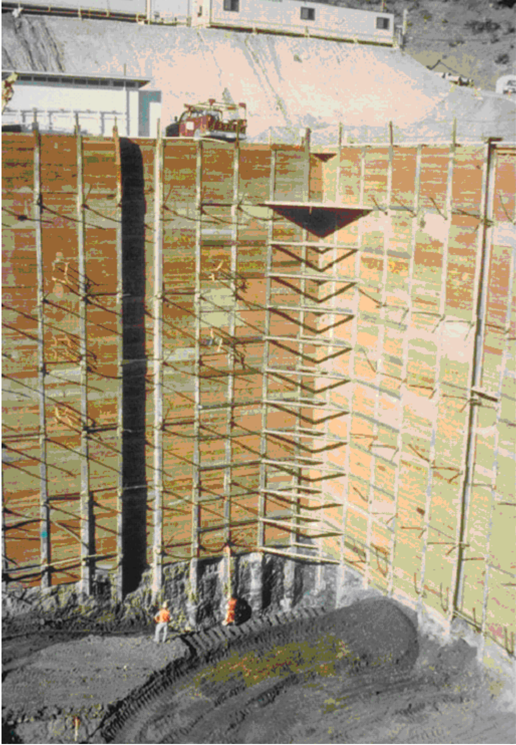
Resim 4 Asker kazıklı ahşap kaplamalı iksa sistemi
