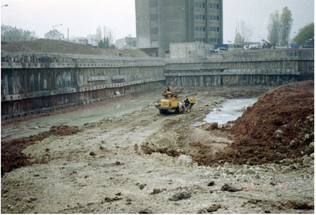
Resim 1 Kesişen Kazık ve ankraj uygulamalı iksa sistemi
