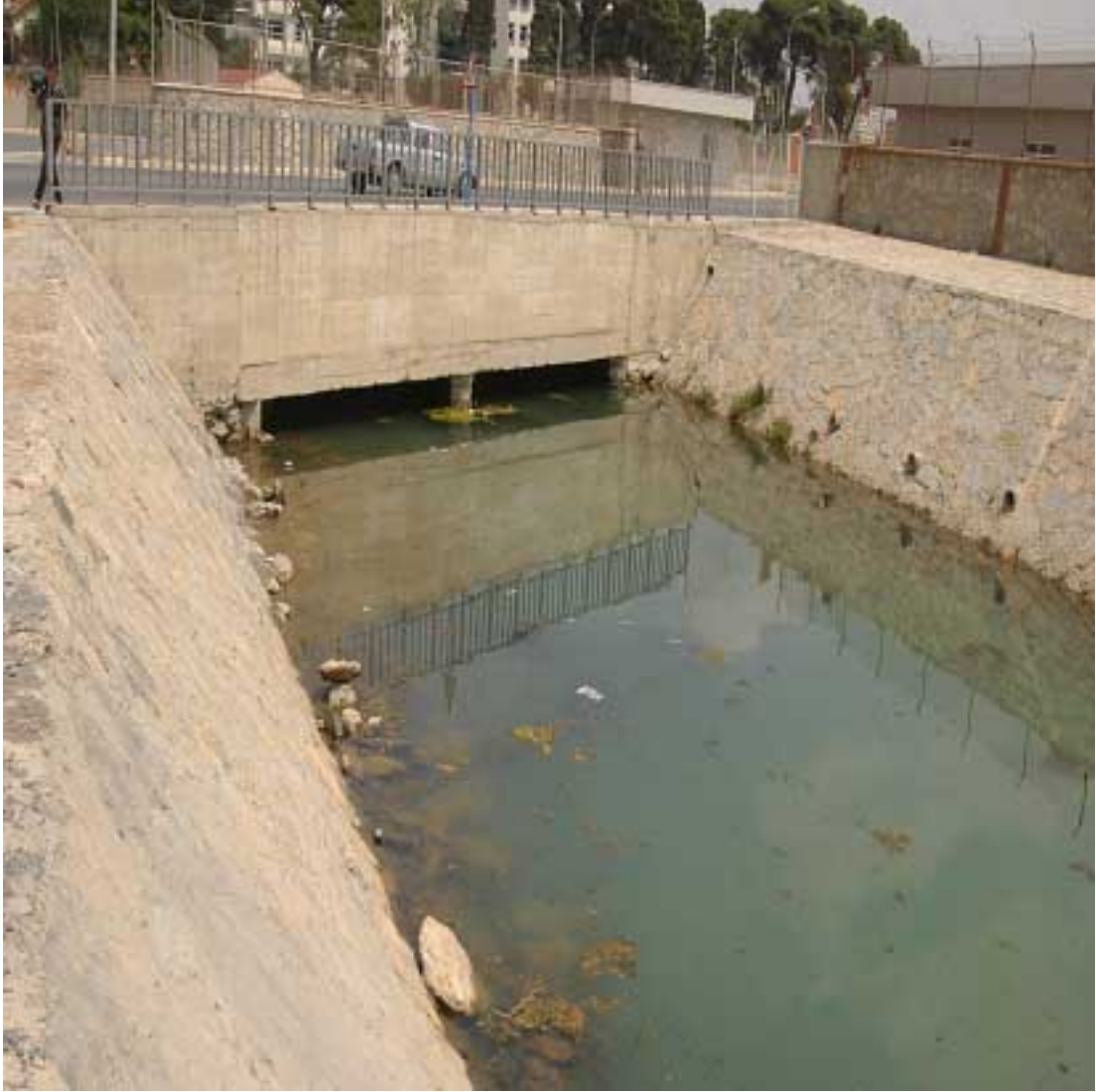
Şekil 2.3. Kapalı kesit uygulaması kurbağalıdere
