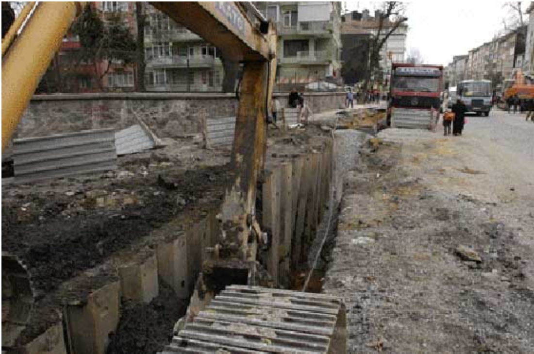
Şekil 2.11. Kapalı Kesit Dere Islahı Sarıyer Deresi
