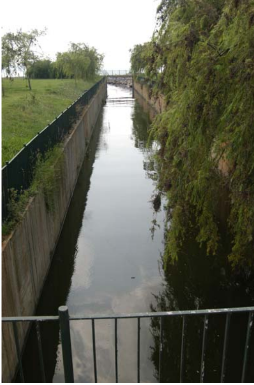
Şekil 2.8. Esenyurt deresi açık kesit şekil
