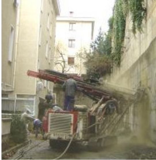
Şekil 2.9 Zemin çivisinin uygulama örneği
