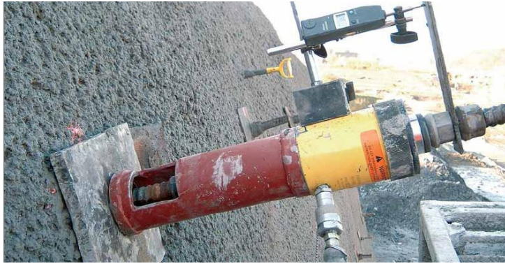
Şekil 2.8 Zemin çivisinin uygulanması
