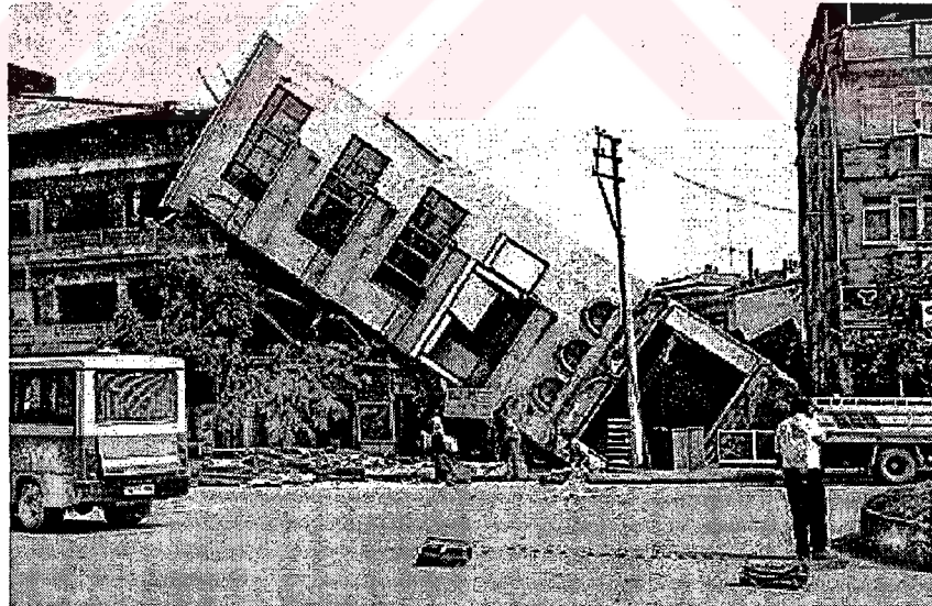
Şekil 2.15 Marmara (1999) Depreminde Sıvılaşma Nedeni ile Oluşan Yapı Hasarları
