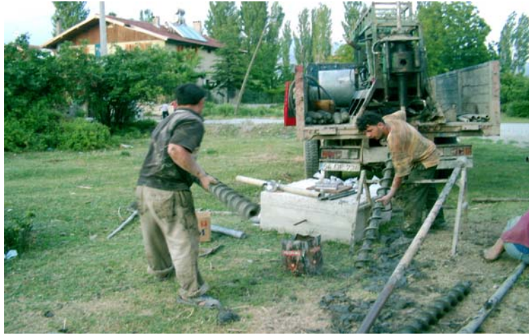
Şekil 5.13. Sondaj işleminde kullanılan numune alıcılarının değiştirilmesi
