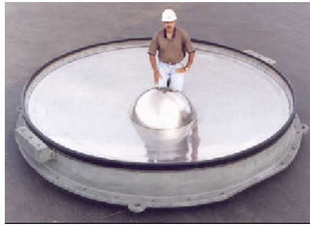
Şekil 4.6. Sürtülmeli sarkaç mesnetinin açık hali [50].
