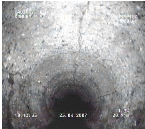
Beton Boru Kırılması
