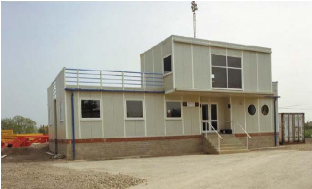
Şekil 3.21 Ctp sistemle yapılan konut [52]
