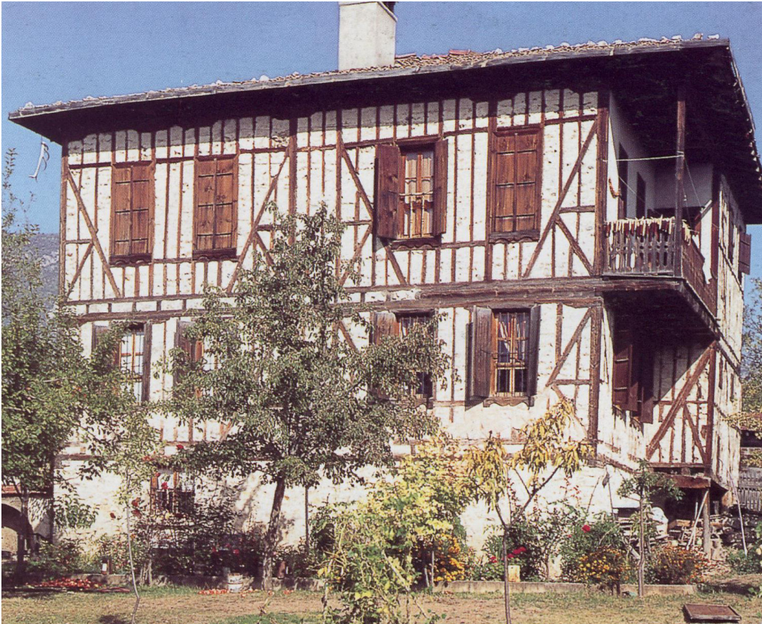
Resim 3.2 Eski döneme ait bir çatkđ örneđi. Dikmeler sık ve ince, yatay bađlantılar fazladır [1]
