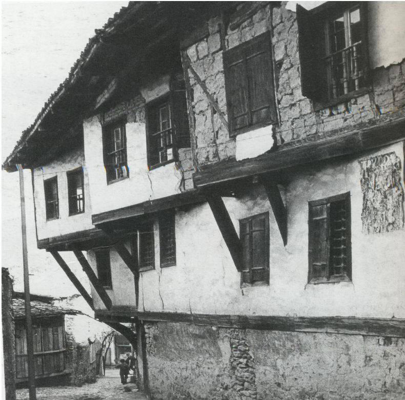
Resim Ek A4. Arazinin engebeli , parsellerin düzgün olmadığı şehir kesiminde zemin katı sokağa uyar. Orta kat bir geçiş katı olarak üst katı hazırlar. Üst katta ise dik kenarlı düzen kurulur. Saçak çatıyı yalınlaştırmak için çıkmaları tek çizgi içinde toparlar
