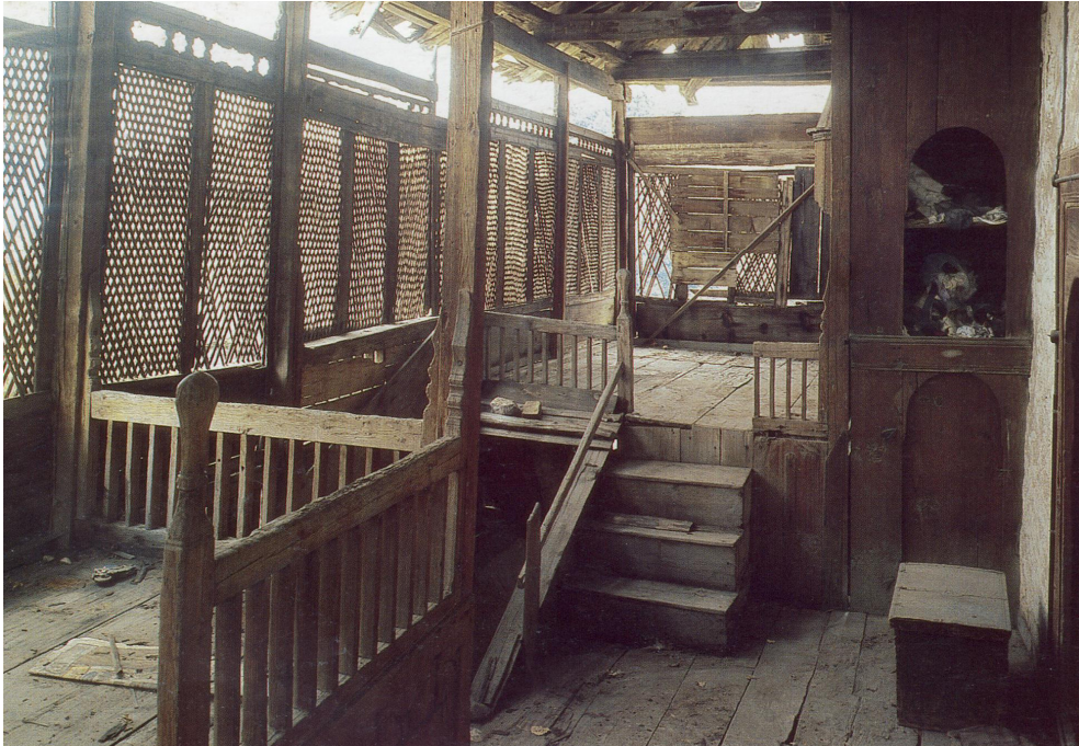
Resim Ek A18. Açık sofalı evlerin son örneklerinden sofası (çardak) muşabaklarla (kafesler iki yönde çakılmışsa) dışa kapatılmıştır. Yerden dört basamak yükseltilmiş yüksek sofa denilen sekilikler vardır
