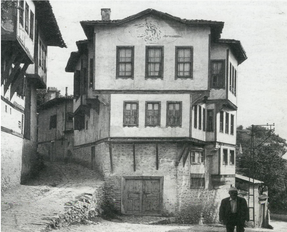
Resim Ek A6. Engabeli arazide, Çuhadar ve Gümüş Sokak'ın bileşiminde Karaosmanlar'ın şehir evi köşe evi olarak çok büyük bir ustalıklarla biçimlendirilmiştir. Taştan zemin katı, destek duvarı görevini de yaparak üst katları taşır. Üst katlar çıkmalarla hem enine hem yüksekliğine büyüyerek sokağa perde perde açılır. Köşedeki kapı, orta ve üst katlarda büyüklük ve aralıkları ustaca düzenlenmiş pencereler orta eksenini güçlendiren üçgen alınlık ve ortasına yerleştirilen tuğra biçiminde Maşallah ile olağanüstü bir cephe kurulmuştur. Ne yazık ki bu cephe şimdi bozulmuş durumdadır.
