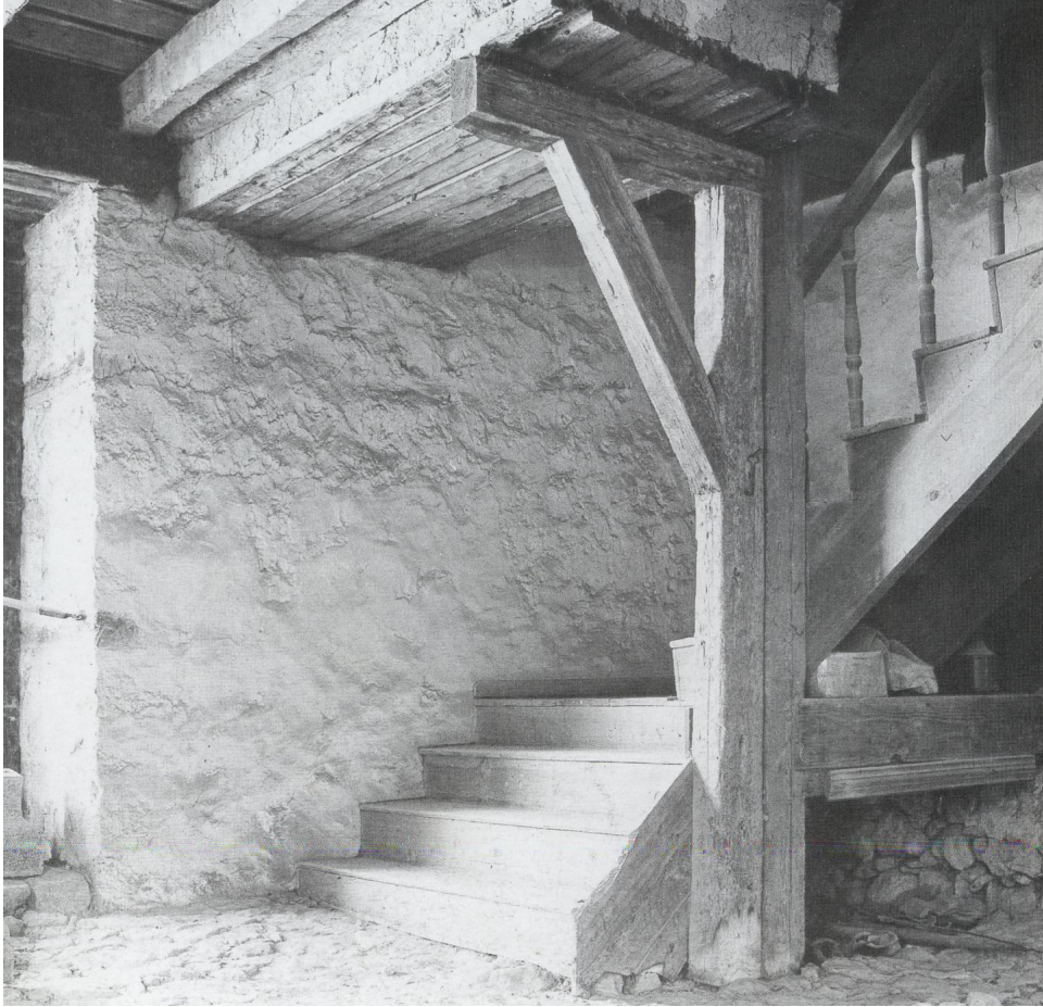
Resim Ek A16. Üst kattaki kış odasının ocak tabanı kerpiçle yalıtılmış ve merdiven yanındaki dikmeye bağlı ayıbaçağı ile takviye edilmiş konsol kirişle taşınmaktadır
