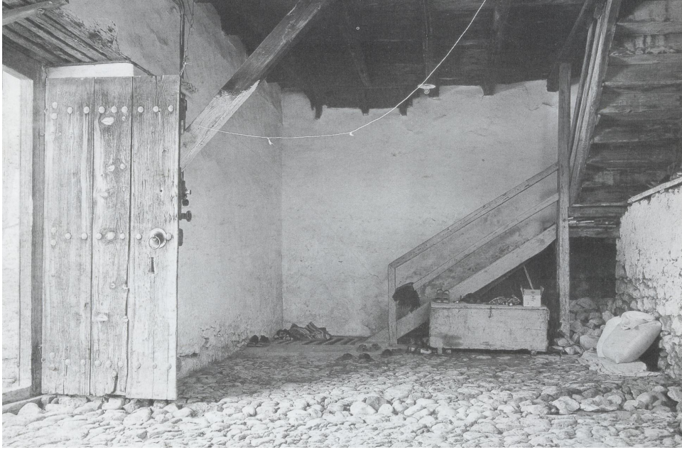
Resim Ek A15. Hayat; bu örnekte taş kaplıdır. Üst kata çıkan merdiven ve kapıyı yukarıdan açmaya yarayan ip görünüyor
