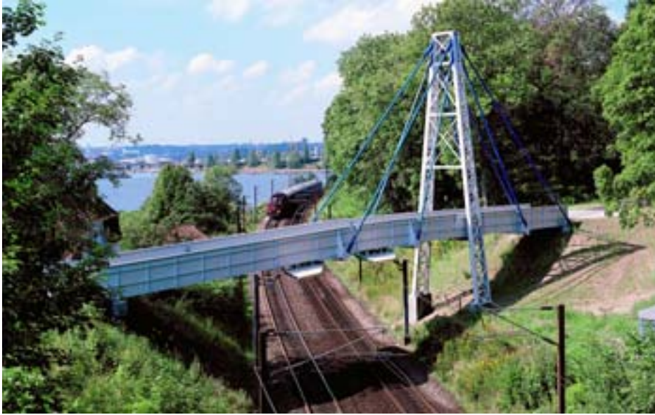
Şekil 2.3. CTP yaya ve hafif araç köprüsü
