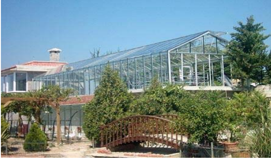
Şekil 1.9. Alüminyumdan profillerden imal polikarbon, cam, pe örtülü seralar [6]
