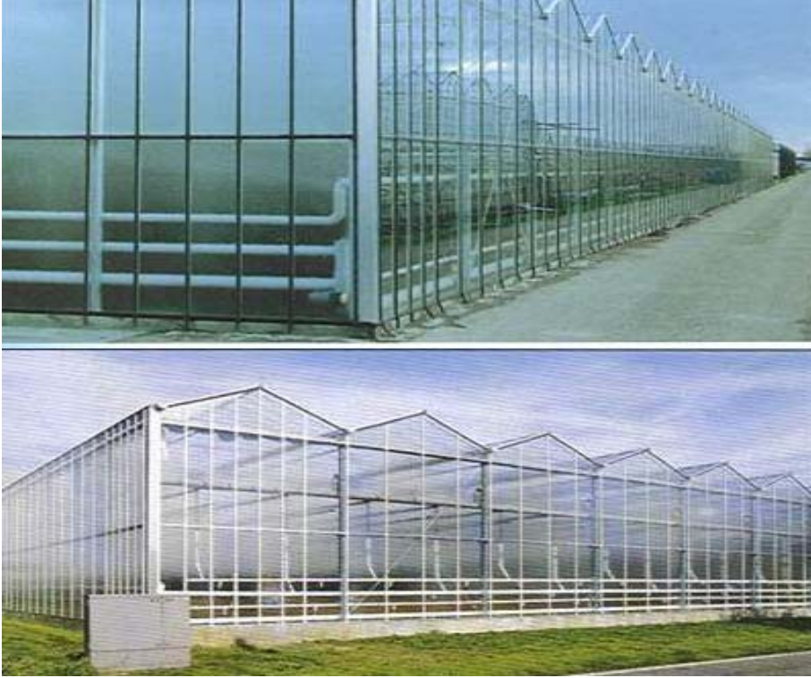
Şekil 1.2. Venlo model cam seraları [2]
