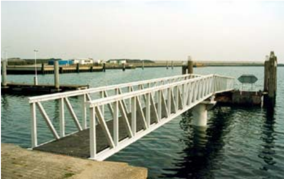
Şekil 2.1. CTP vapur iskelesi [14]
