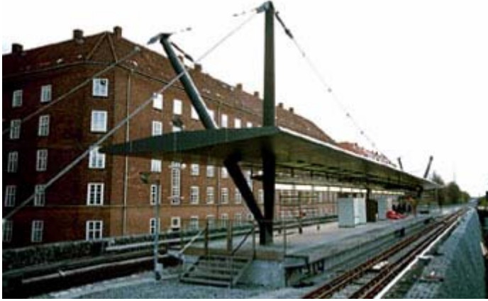
Şekil 2.2. CTP metro istasyonu
