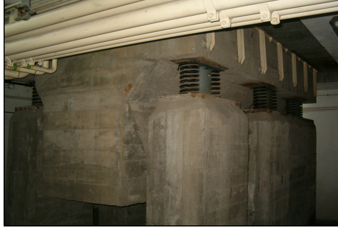
Resim 4.4. Motor -dinamometre titreşim sönümleyici beton kütesi
