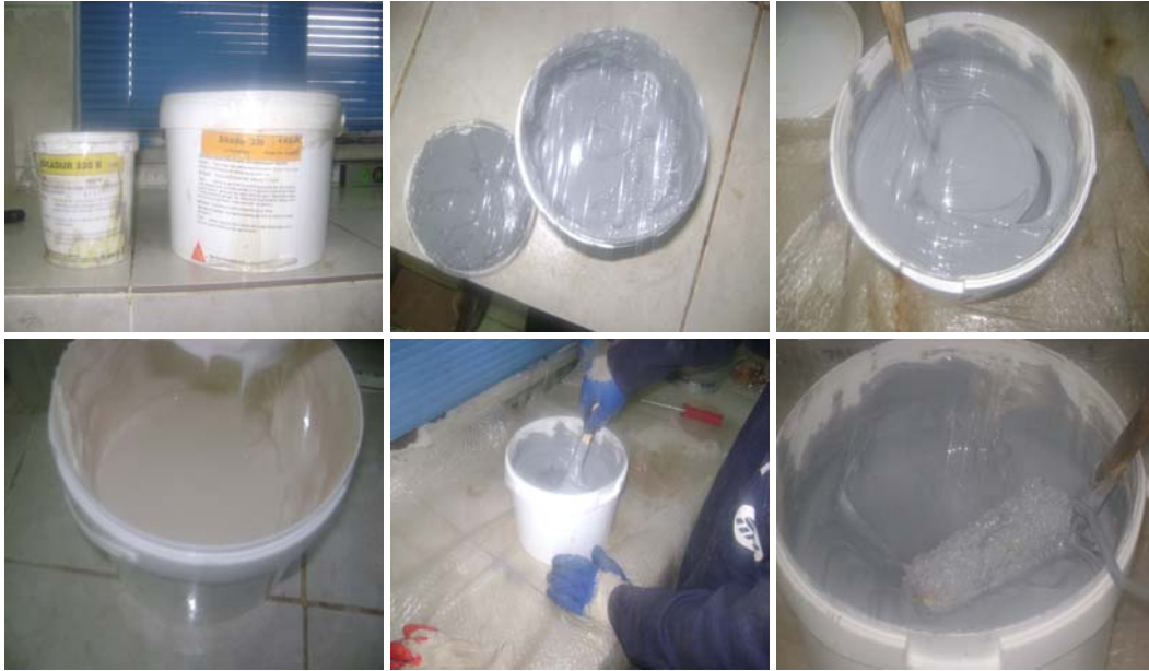
Şekil 3.15. Doyurma reçinesinin hazırlanması
