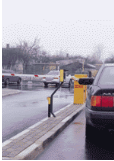
Şekil 3.19. I-button ile otopark otomasyonu[37]
