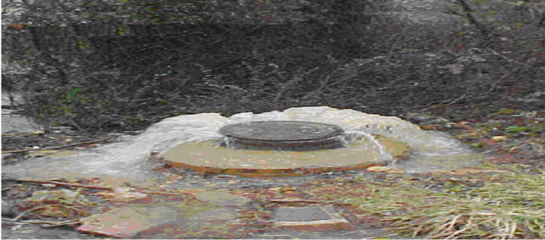
Şekil 3.3. Atık yağlardan dolayı tıkanan kanalizasyon [33].
