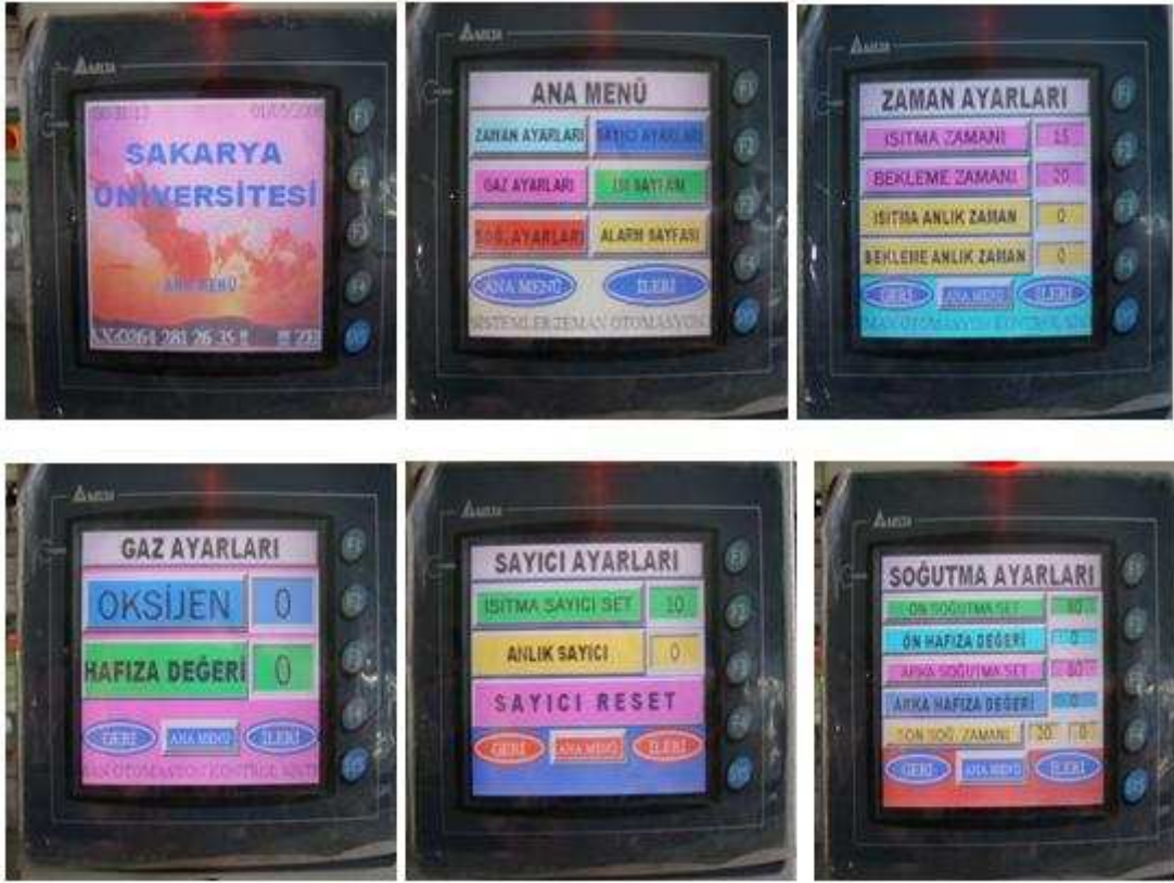
Şekil 4.11. PLC ile kontrol edilen termal şok ünitesinin kontrol paneli
