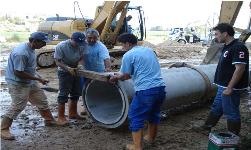
Şekil 3.1. AÇB boru tamiri
