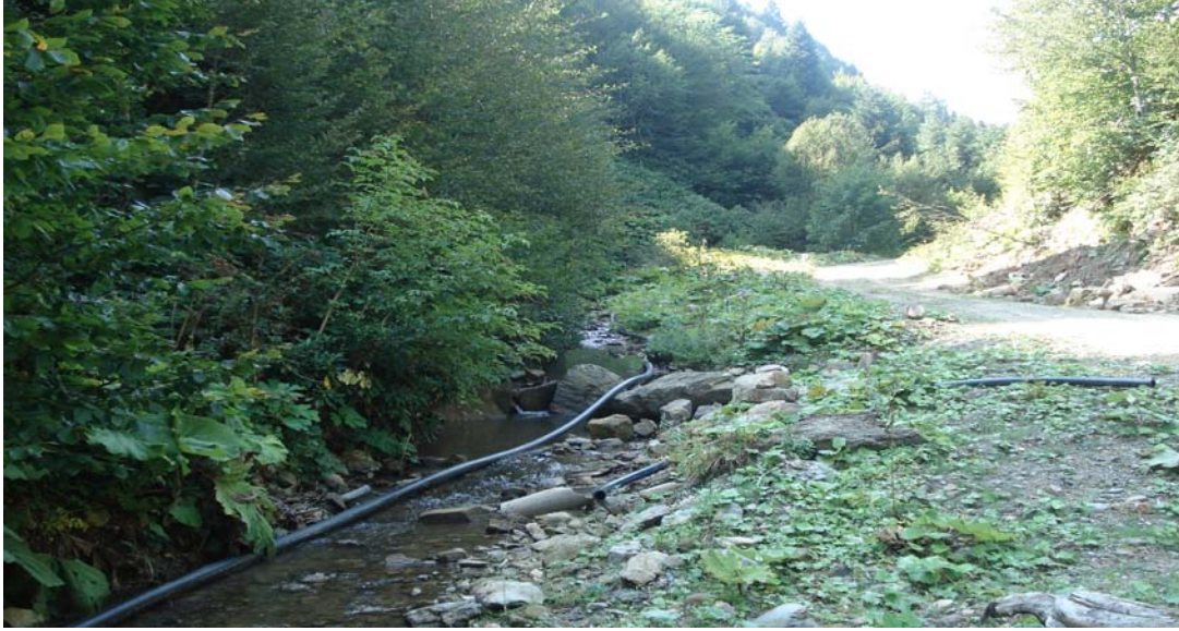
Şekil 3.3. PE boru döşenmesi
