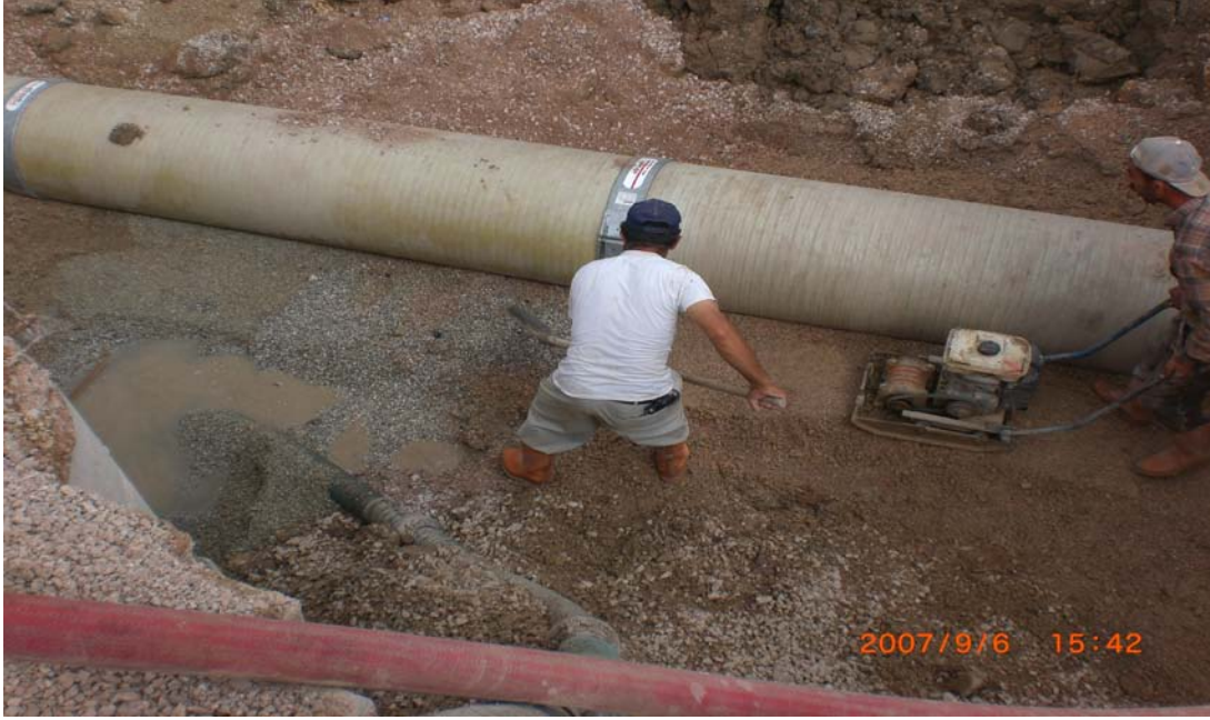
Şekil 3.4. CTP boru tamiri
