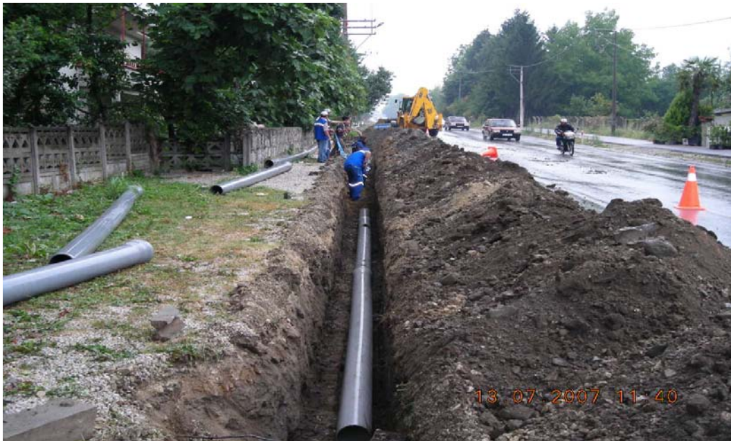
Şekil 3.2. PVC boru döşenmesi
