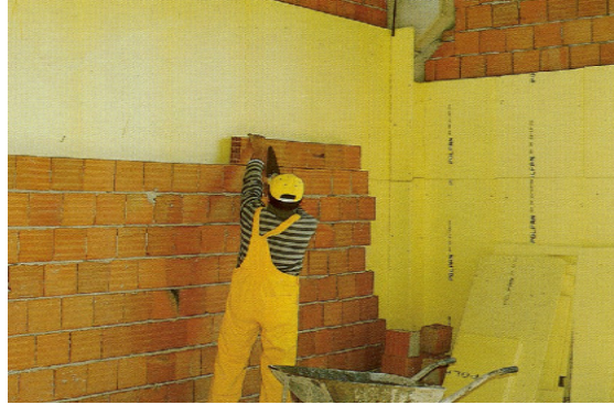
Şekil 4.41 Duvarlarda Ortadan Isı Yalıtımı Uygulaması ve Detayları
