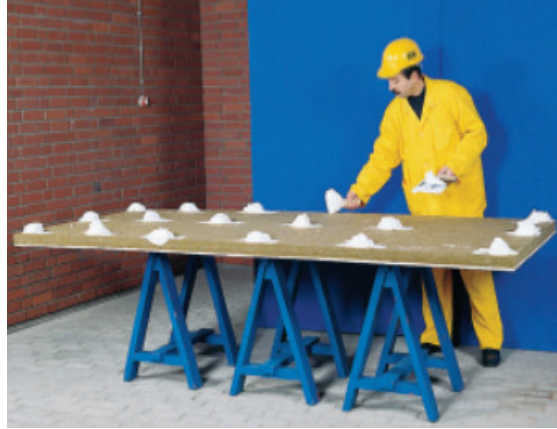
Şekil 4.12. Yapıştırıcı Harcın Yalıtım Levhasına Noktasal Olarak Uygulanması
