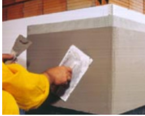
řekil 4.29. İkinci Kat Sıva Uygulaması
