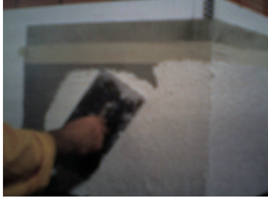
Şekil 4.30. İkinci Kat Yalıtım Sıvası Uygulanması
