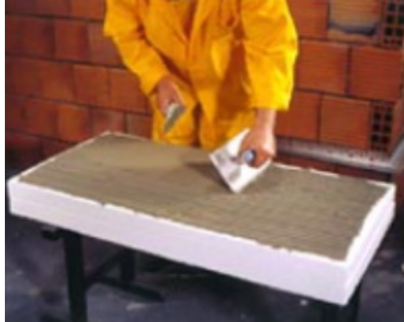
Şekil 4.13. Düzgün Yüzeyle Levha Yüzeyine Tırtıklı Mala İle Yapıştırıcı Uygulanması
