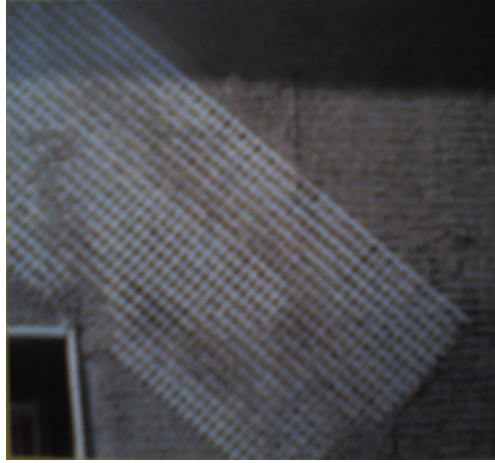
Şekil 4.23. Donatı Filesinin Pencere Köşesine Yatayla 45^{\circ} 'lık Açı Yapar Konumunda Uygulanması
