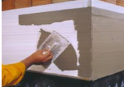
Şekil 4.27. Isı Yalıtım Levhasının Yüzeyine İlk Kat Sıva Uygulaması
