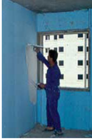
Şekil 4.39. Isı Yalıtım Levhasına İlk Kat Sıva Uygulaması
