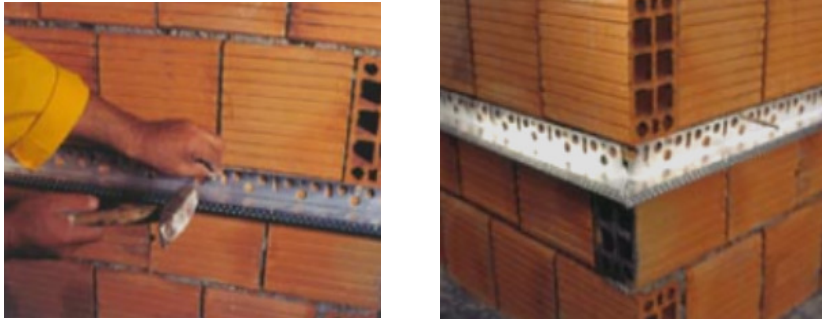
Şekil 4.10. Başlangıç Profilinin Duvara Uygulanması
