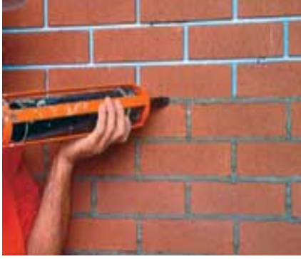
Şekil 4.33. Tuğlaların Arasına Özel Yapıştırıcıların Uygulanması
