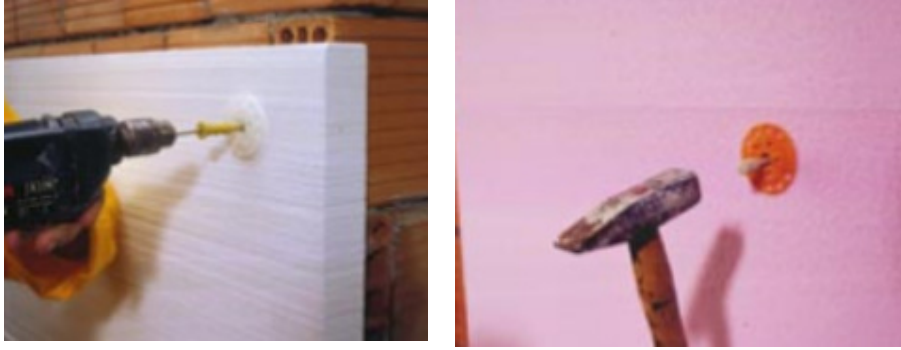
Şekil 4.17. Delik Delme ve Dübelleme İşlemi
