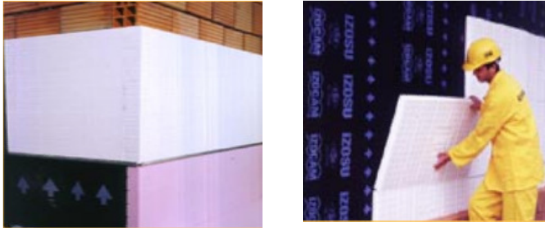
Şekil 4.44. Toprak Altı Dış Duvar ve Subasmanı Yalıtımı
