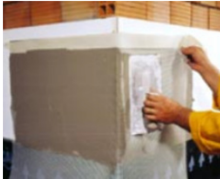
Şekil 4.28. Donatı Filesinin İlk Sıva Katmanı Üzerine Uygulanması
