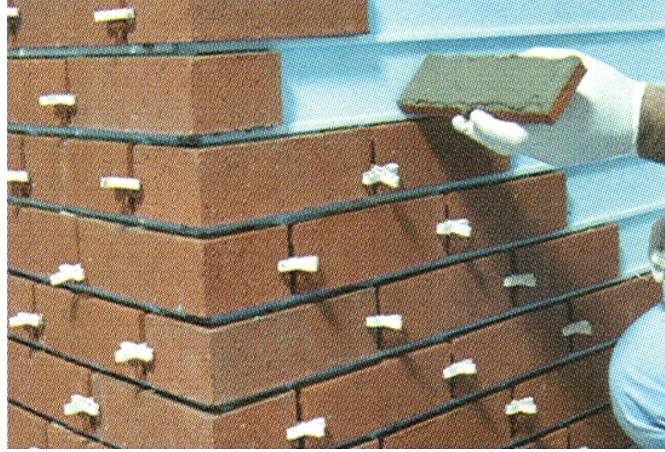
Şekil 4.32. Tuğla Bitişli Son Dekoratif Kaplama
