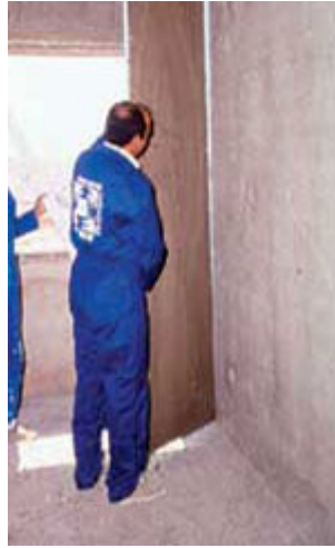
Şekil 4.38. Isı Yalıtım Levhalarının Duvar İç Yüzeyine Uygulanması
