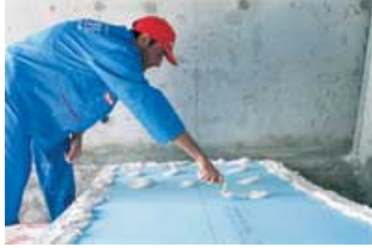
Şekil 4.37. Levhalara Yapıştırma Harcının Uygulanması
