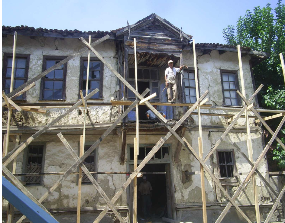
Şekil 6.15. Ön cephenin askıya alınması
