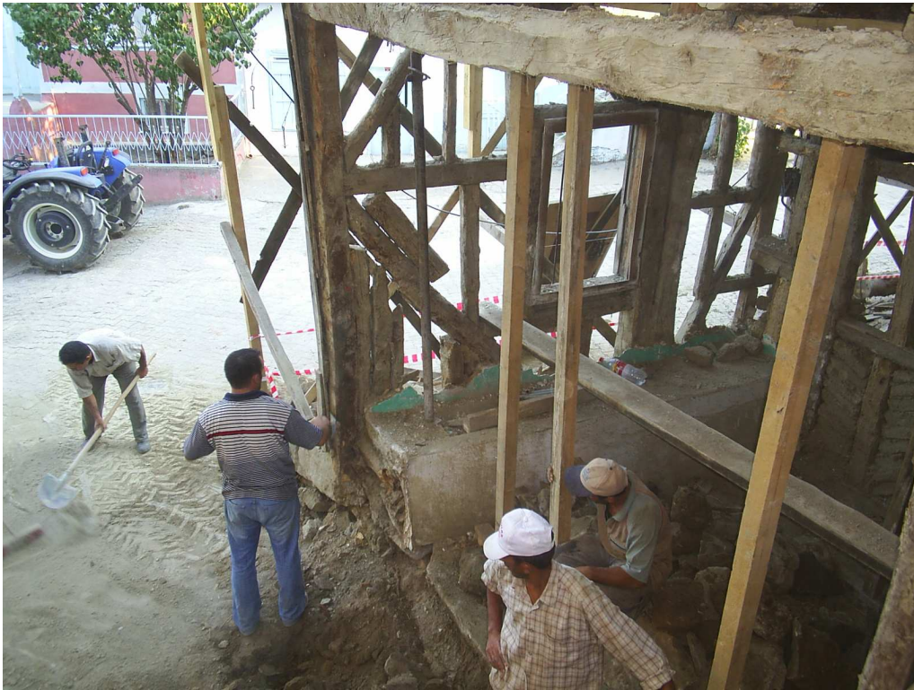
Şekil 6.21. Duvarlarda söküm işlemleri
