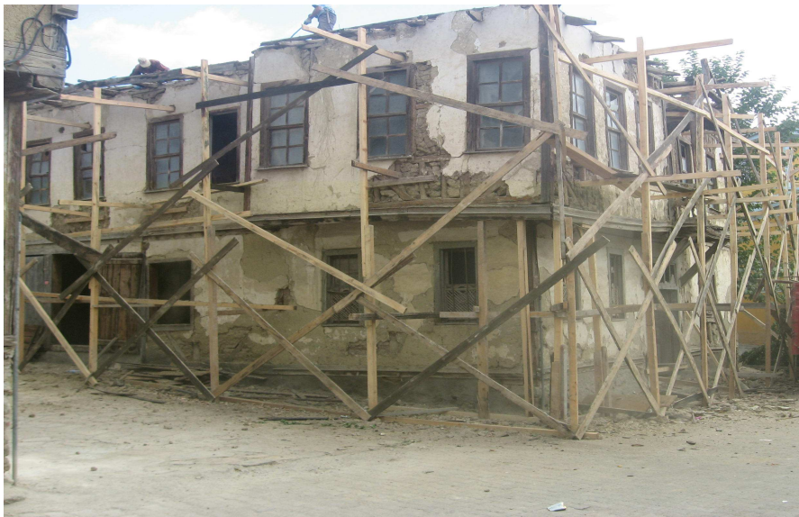
Şekil 6.17. Çatının restorasyon sırasındaki görünüşü
