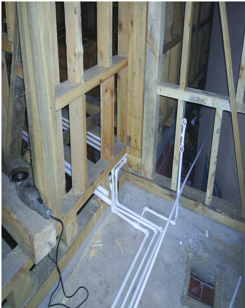
Şekil 6.30. Isıtma tesisat borularının görünüşleri
