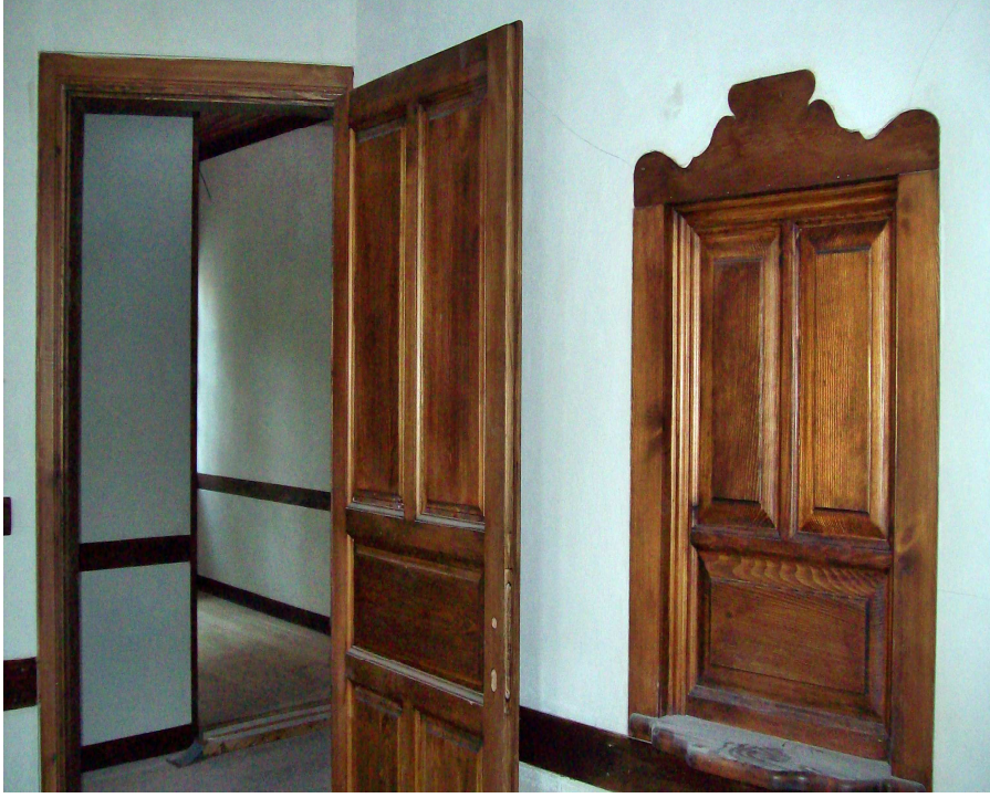
Şekil 6.50. Restorasyon sonrası ahşap kapı ve niş görüntüleri
