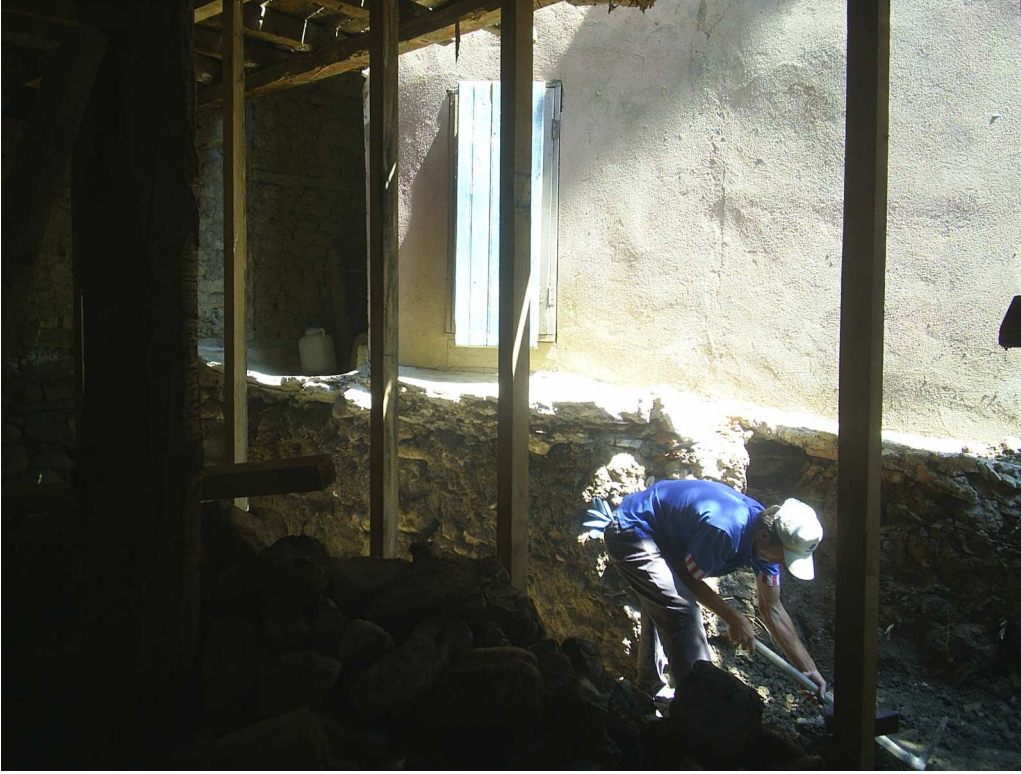
Şekil 6.20. Duvarlarda söküm işlemleri
