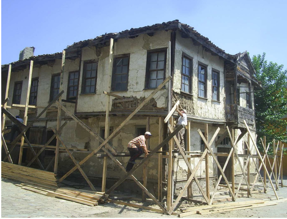
Şekil 6.14. Ön ve Sol yan cephenin askıya alınma sırasındaki görünüşü
