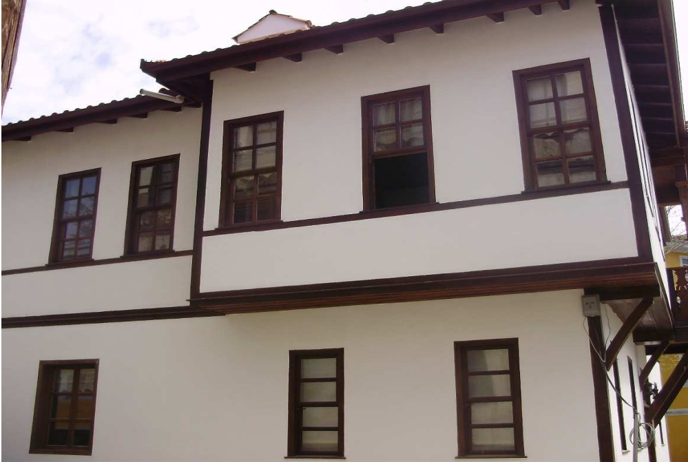
Şekil 6.43. Restorasyon sonrası sol yan cephenin görünüşü
