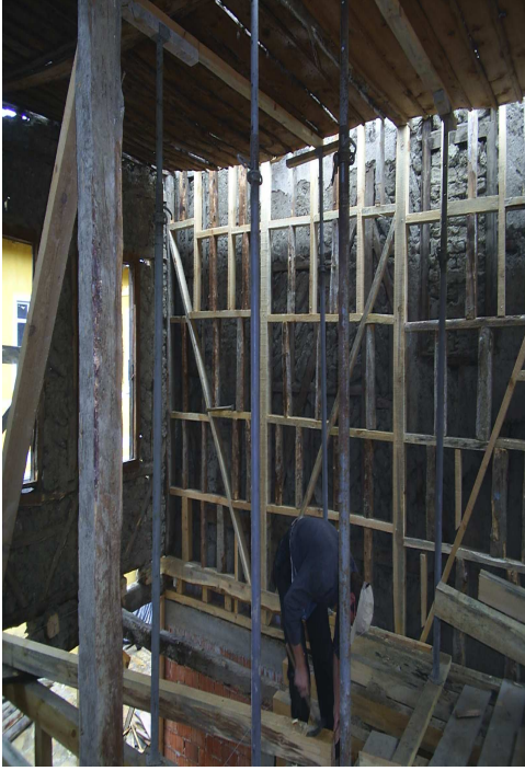
Şekil 6.25. Yapının ahşap dikme ve demir direklerle askıya alındıktan sonraki görünüşü
