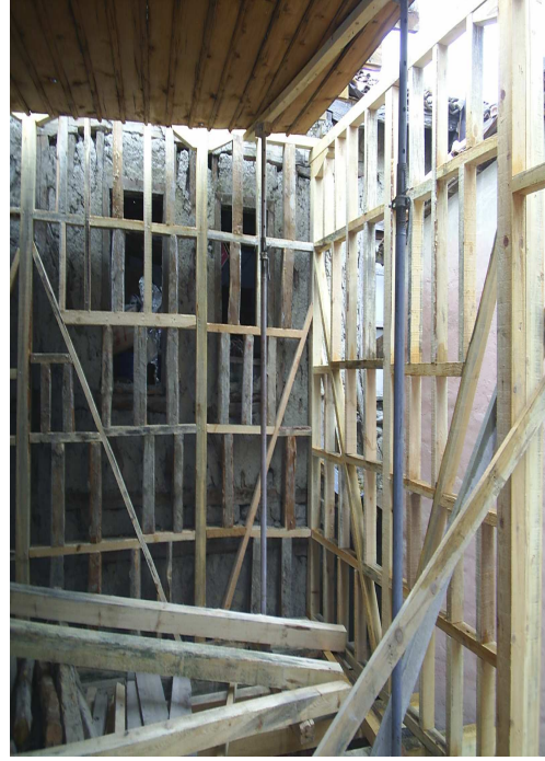
Şekil 6.25. Yapının ahşap dikme ve demir direklerle askıya alındıktan sonraki görünüşü
