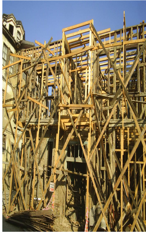
Şekil 6.25. Yapının ahşap dikme ve demir direklerle askıya alındıktan sonraki görünüşü
