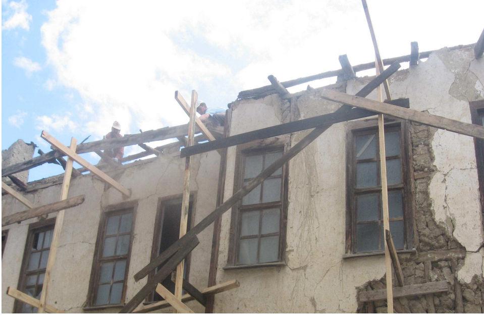
Şekil 6.18. Çatının restorasyon sırasındaki görünüşü
