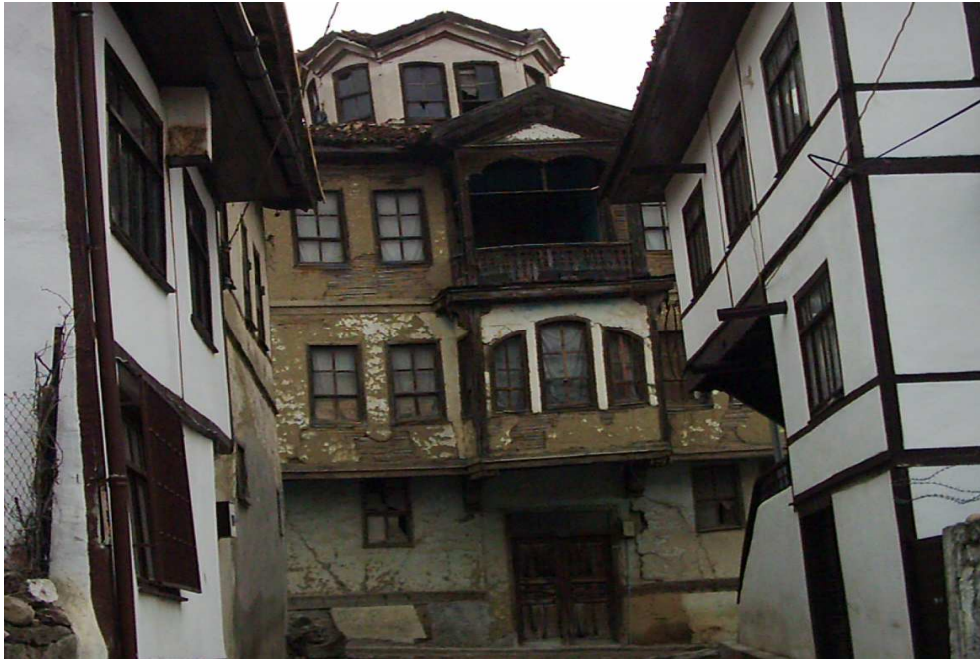
Şekil 3.16. Fenerli Evi'nin ön cephe görünüşü
