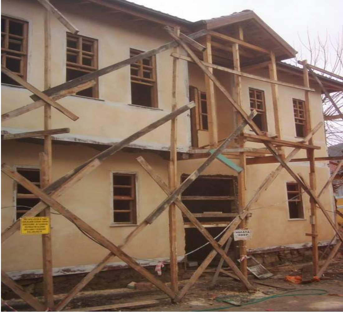
Şekil 6.36. Restorasyon sırasında giriş cephesinin görünüşü
