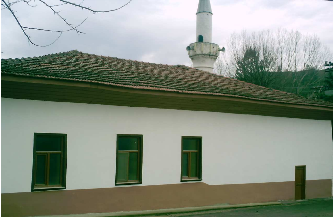
Şekil 3.40. Yusuf Bey Camisine ait görünüş
