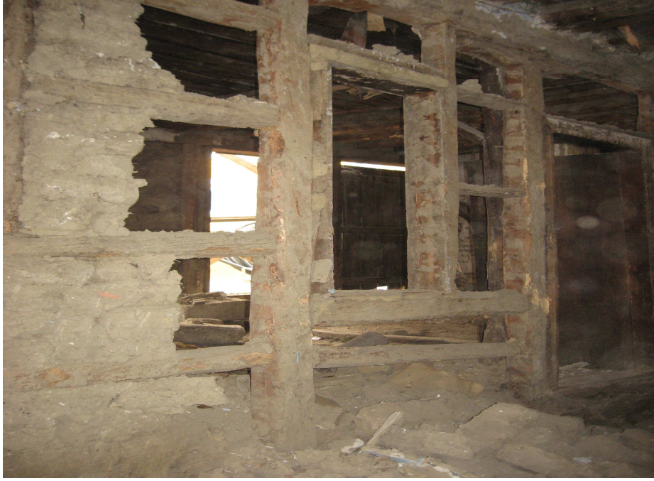
Şekil 6.22. Duvarların boşaltıldıktan sonraki mevcut taşıyıcı sistemi
