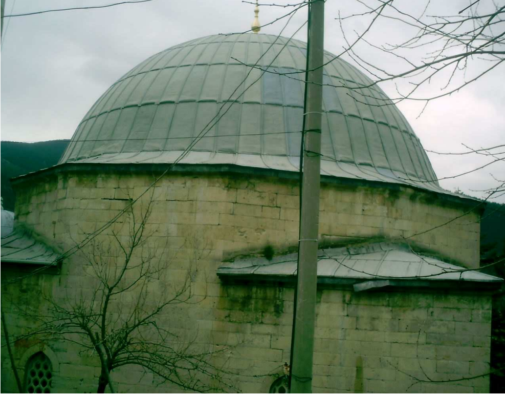
Şekil 3.5. Yunus Paşa Camisinin arka cephe görünüşü
