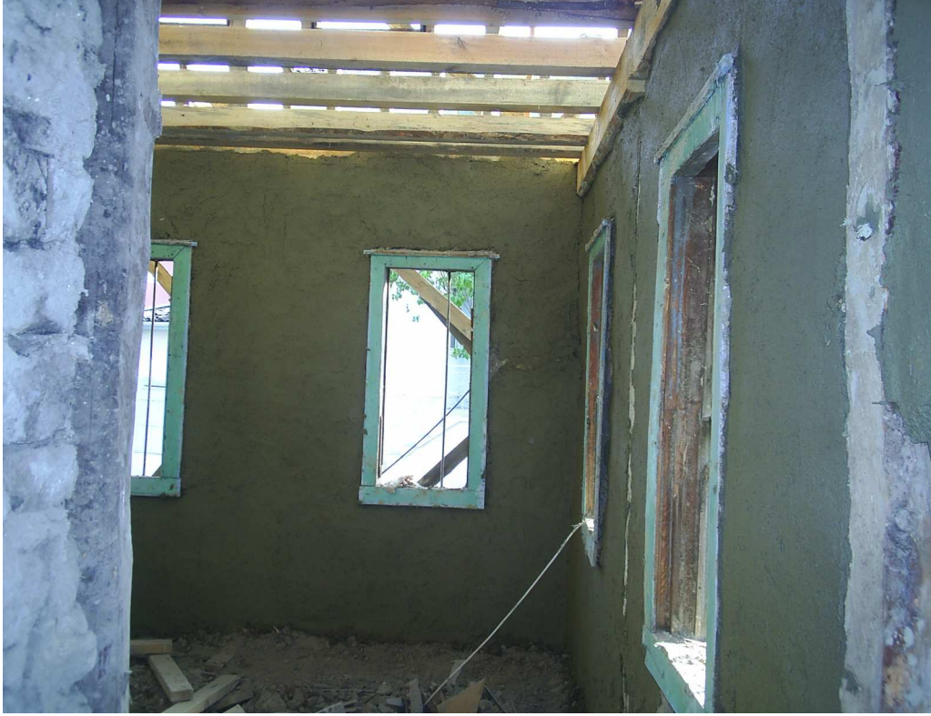
Şekil 6.33. Duvara uygulanan sıvanın tamamlanmış hali
