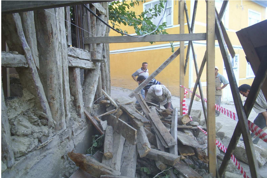
Şekil 6.19. Duvarlarda söküm işlemleri
