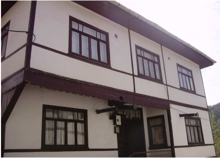
Şekil 4.7. Çıkma cephe özelliği gösteren sivil yapının görünüşü
