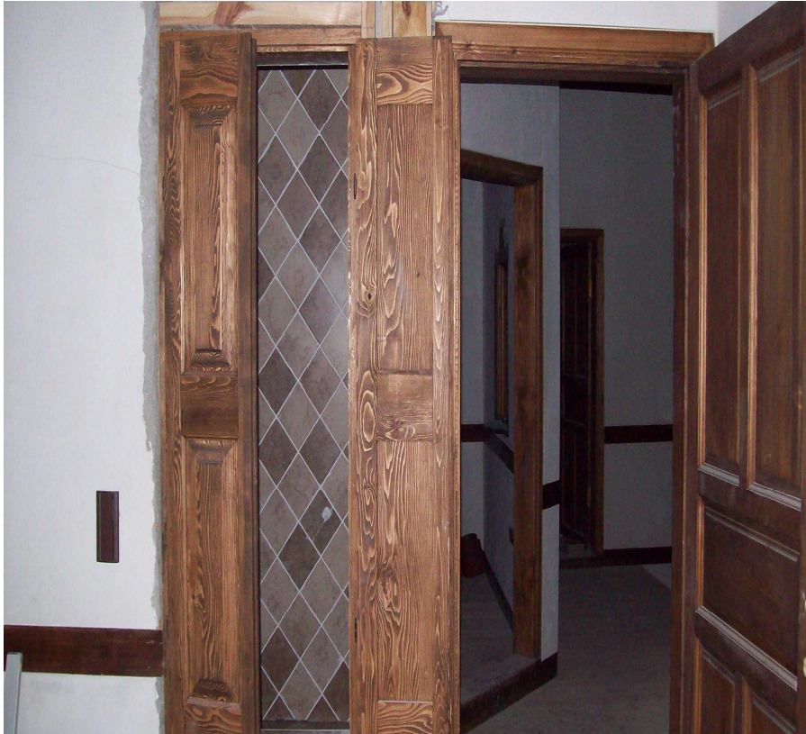
Şekil 6.51. Restorasyon sonrası ahşap kapı görüntüleri
