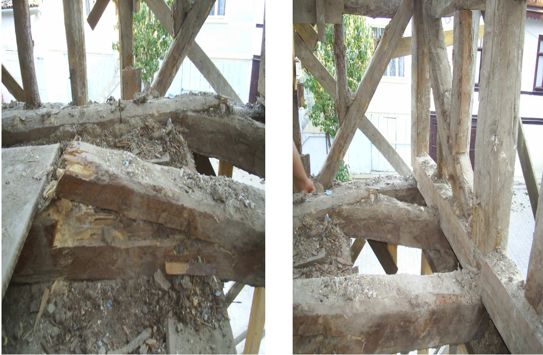
Şekil 6.24. Eskimiş konstrüksiyon elemanları
