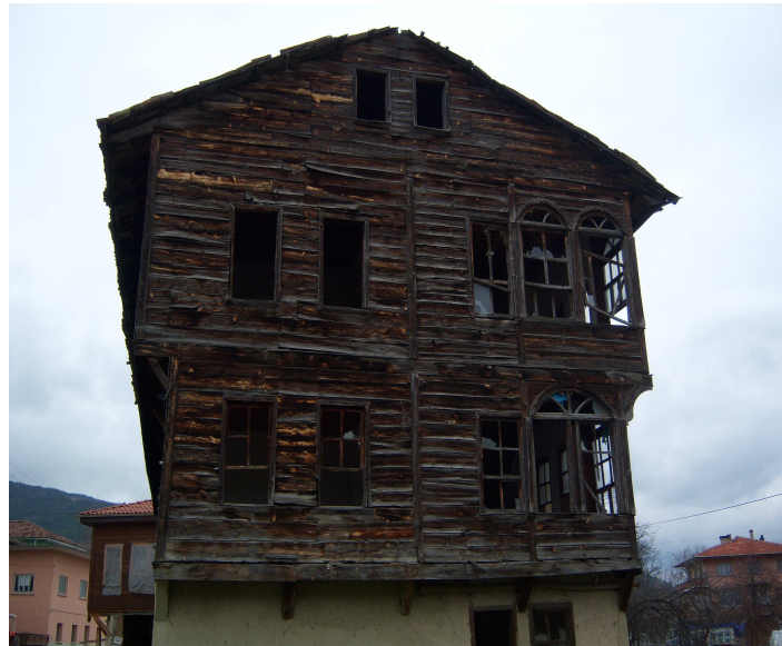
Şekil 4.21. Orta durumda olan yapı örneği
