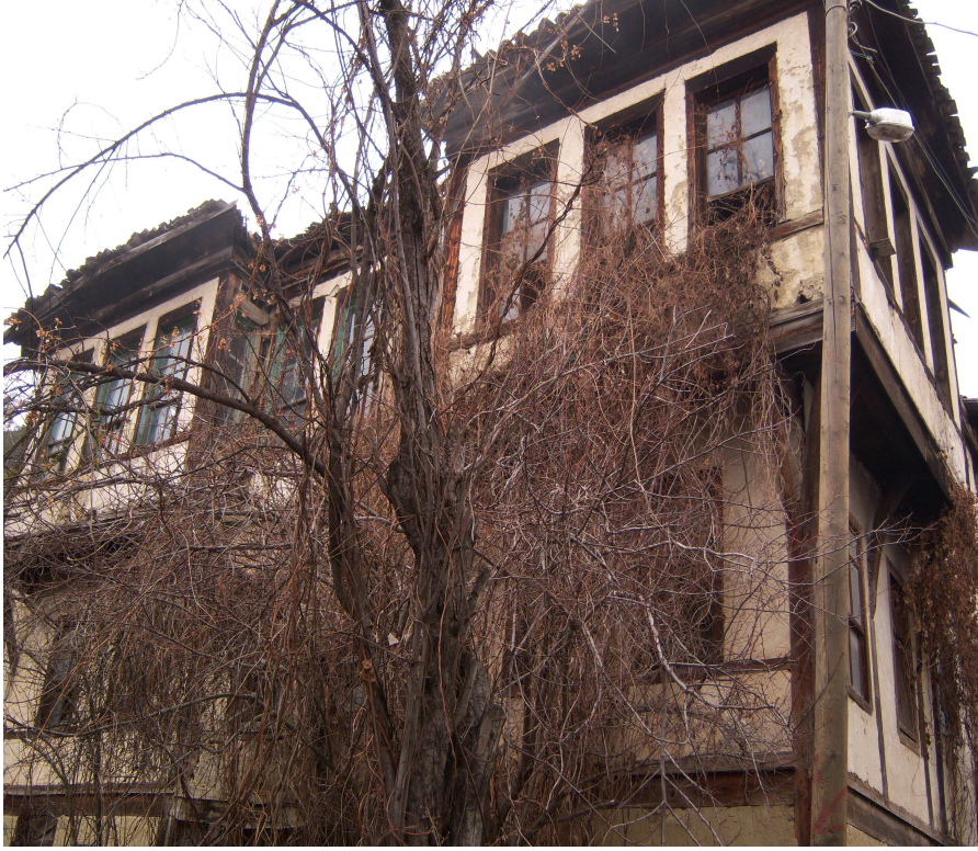
Şekil 4.19. İyi durumda olan yapı örneği
