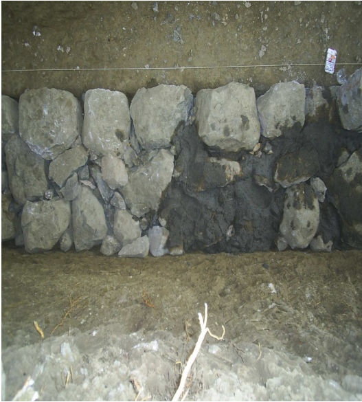
Şekil 6.23. Temel duvarların örülme aşaması ve örüldükten sonraki hali
