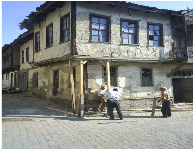
Şekil 6.13. Ön cephenin askıya alınmaya başlanması sırasındaki görünüşü
