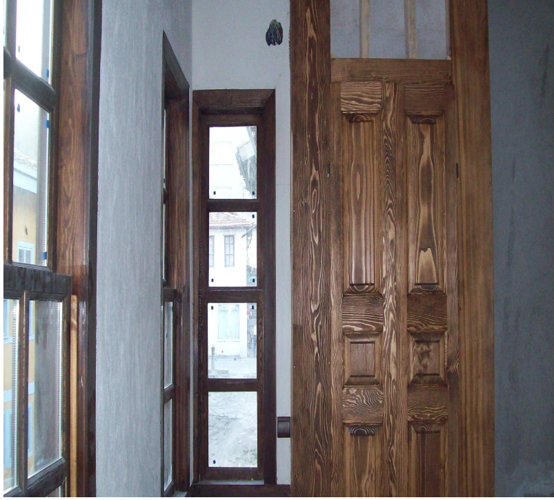
Şekil 6.52. Restorasyon sonrası ahşap kapı ve pencere görünüşleri
