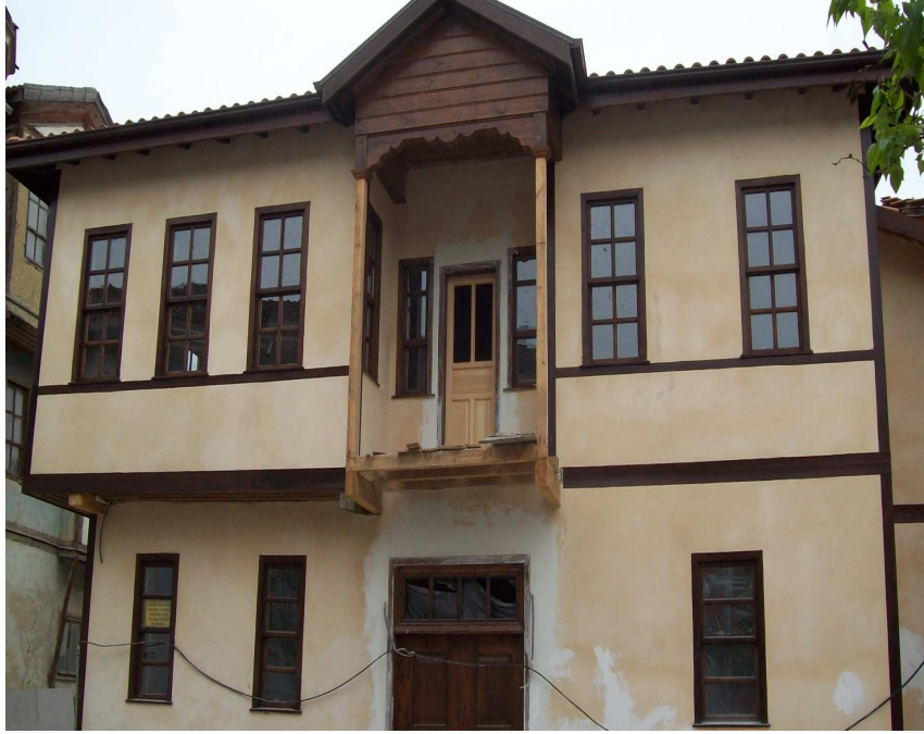
Şekil 6.37. Giriş cephesinin sıvası bittikten sonraki görünüşü
