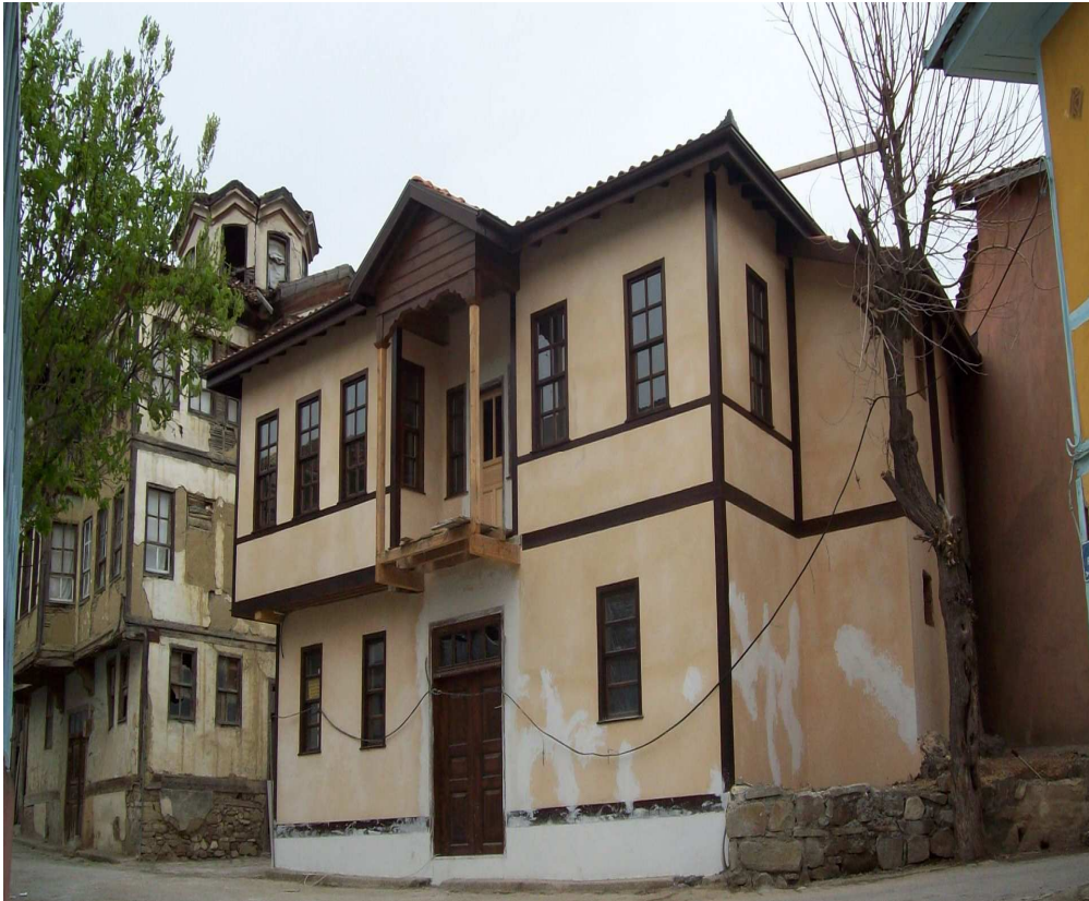
Şekil 6.46. Sağ yan cephenin sıvası bittikten sonraki görünüşü
