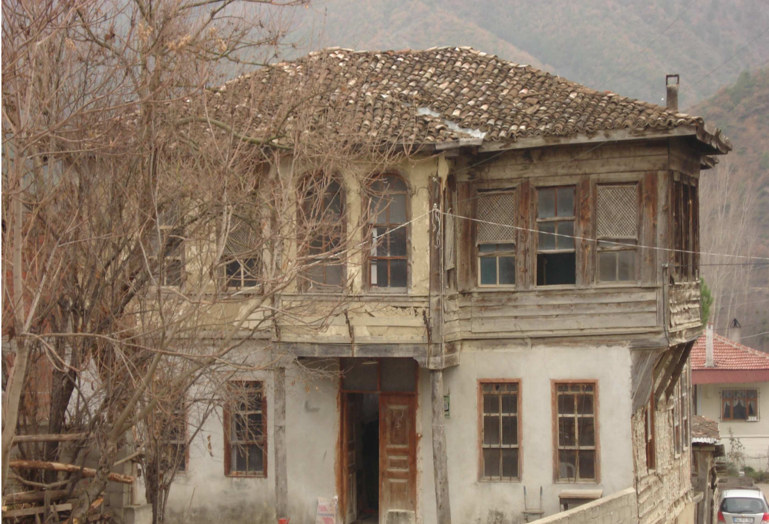
Şekil 4.9. Kapalı balkon çıkma özelliğine sahip sivil yapının görünüşü
