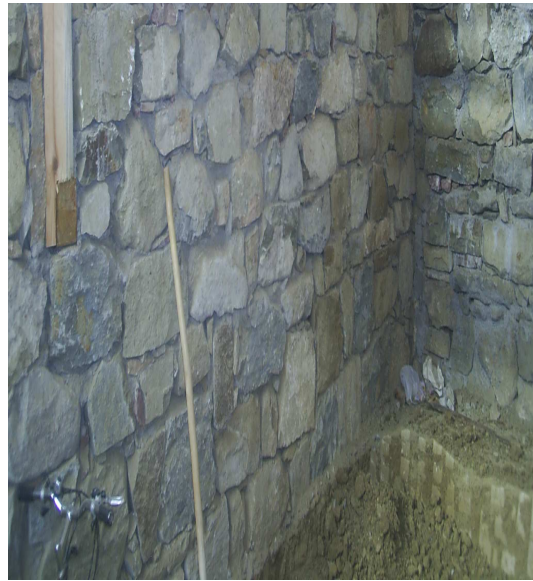
Şekil 6.23. Temel duvarların örülme aşaması ve örüldükten sonraki hali
