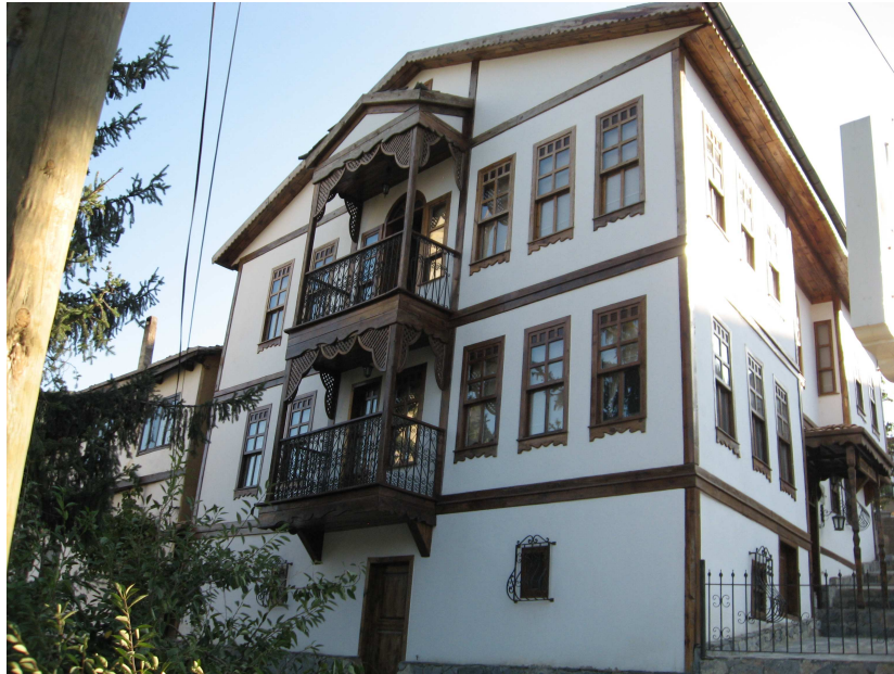
Şekil 1.8. Sivil mimarlık örneklerinden 2. Çakırlar Konağı
