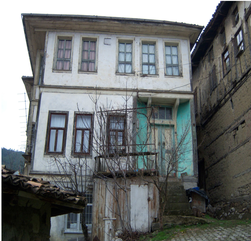
Şekil 4.18. İyi durumda olan yapı örneği
