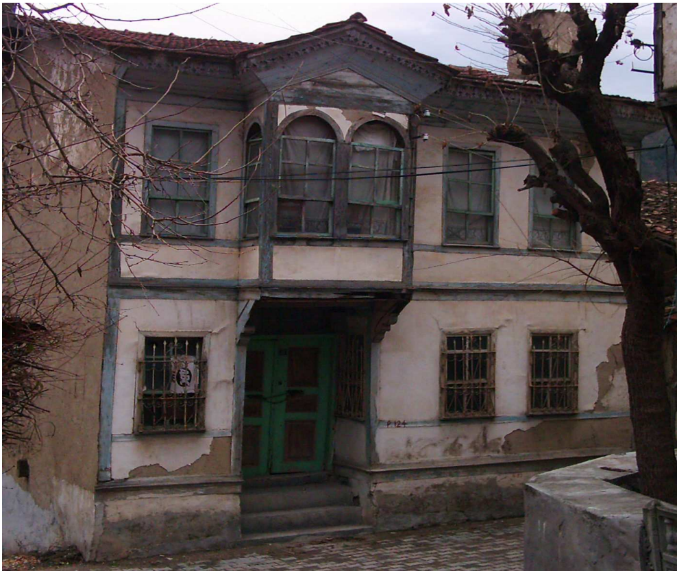
Şekil 3.29. İbrahim Pilavcı Evi'nin ön cephe görünüşü
