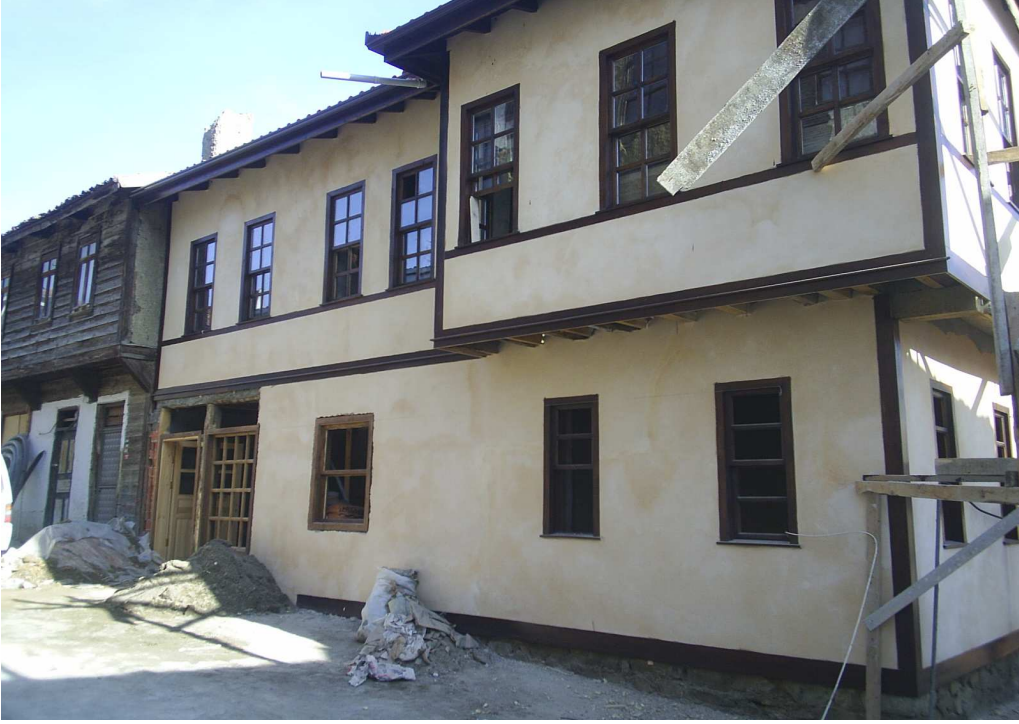
Şekil 6.42. Sol yan cephenin sıvası bittikten sonraki görünüşü
