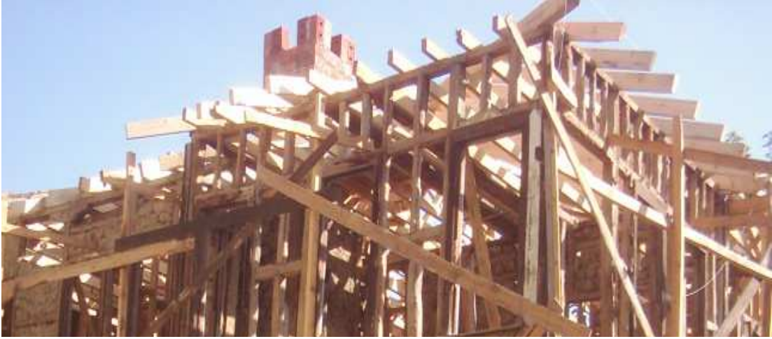
Şekil 6.11. Restorasyon aşamasında çatı görünüşü
