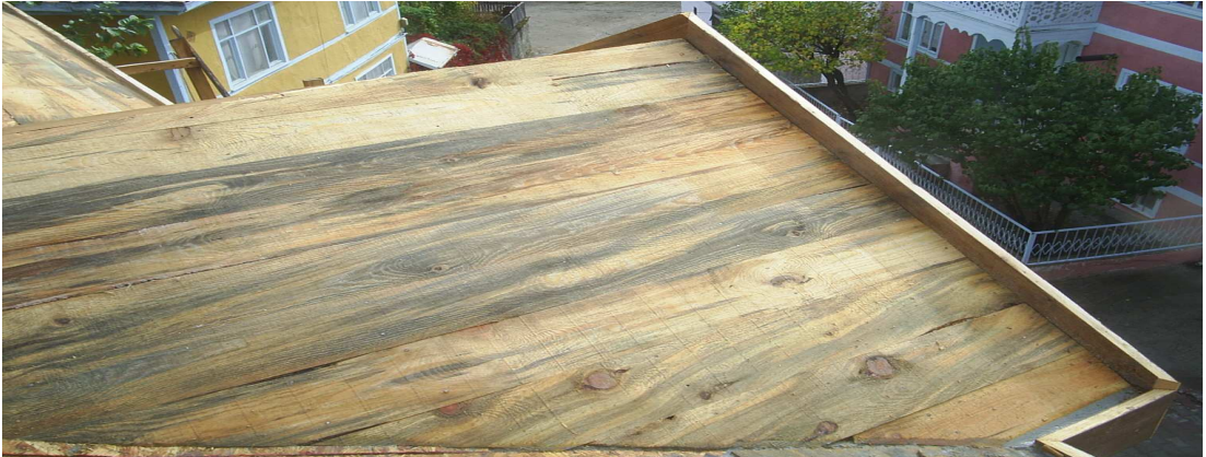
Şekil 6.12. Restorasyon aşamasında çatı görünüşü
