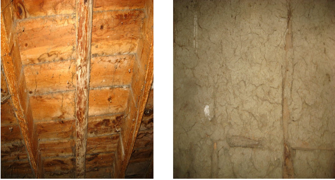
Şekil 5.11. Depo duvar ve ahşap tavan görünüşleri
