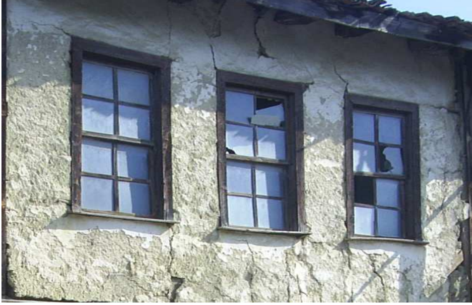
Ŗekil 6.7. Restorasyon öncesi pencere görünüŖleri
