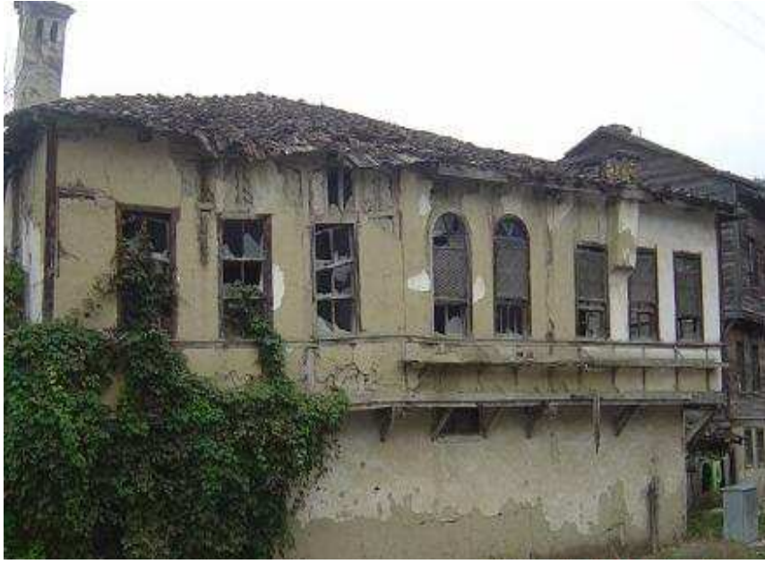
Şekil 3.12. Hacı Rıfatlar Konağı'nın arka cephe görünüşü [1]
