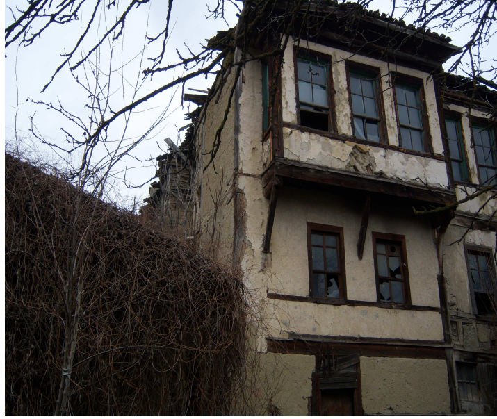
Şekil 4.20. Orta durumda olan yapı örneği
