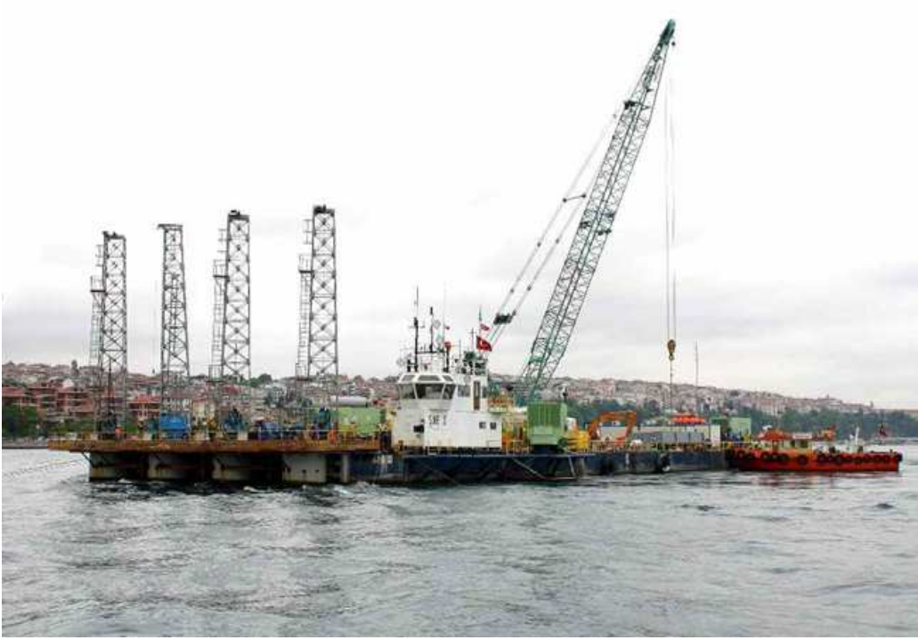
Şekil 4.18. Zemin iyileştirme çalışmalarını yapan Gemi (SARIII)
