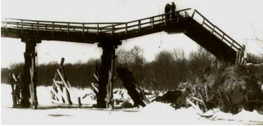
Şekil 3.1. Sıvılaşma sonucu hasar gören köprü (San Lorenzo)
