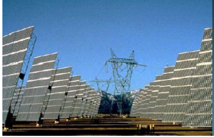
Resim 4.1. Şebekeye Elektrik Veren Güneş Pili (PV) Sistemi (1MW nominal güç)
