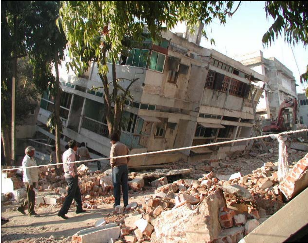
Şekil 2.18. İlk katı yumuşak kat nedeniyle göçmüş bir bina (Goel, 2003)
