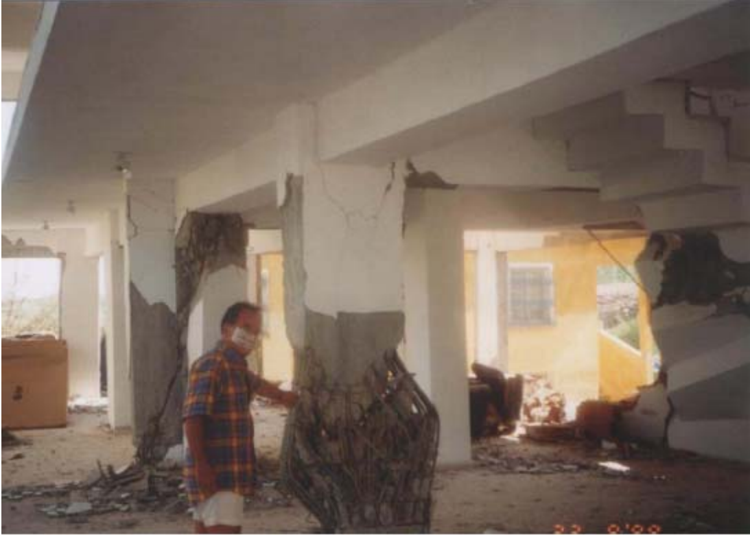
Şekil 3.4. Adapazarı'nda Şekil 2.15'te gösterilen 5-katlı binanın zemin katının içi
