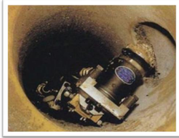
Şekil 4.5. Freze ile kaplama sonrası yanıl bağlantıların açılması
