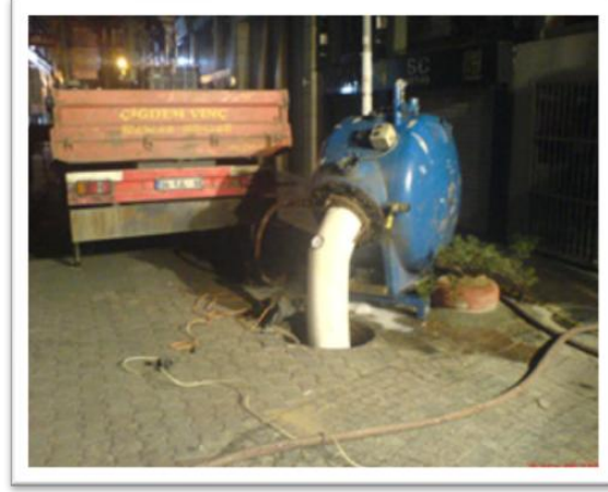
Şekil 4.2. CIPP kaplama buharla kürleme
