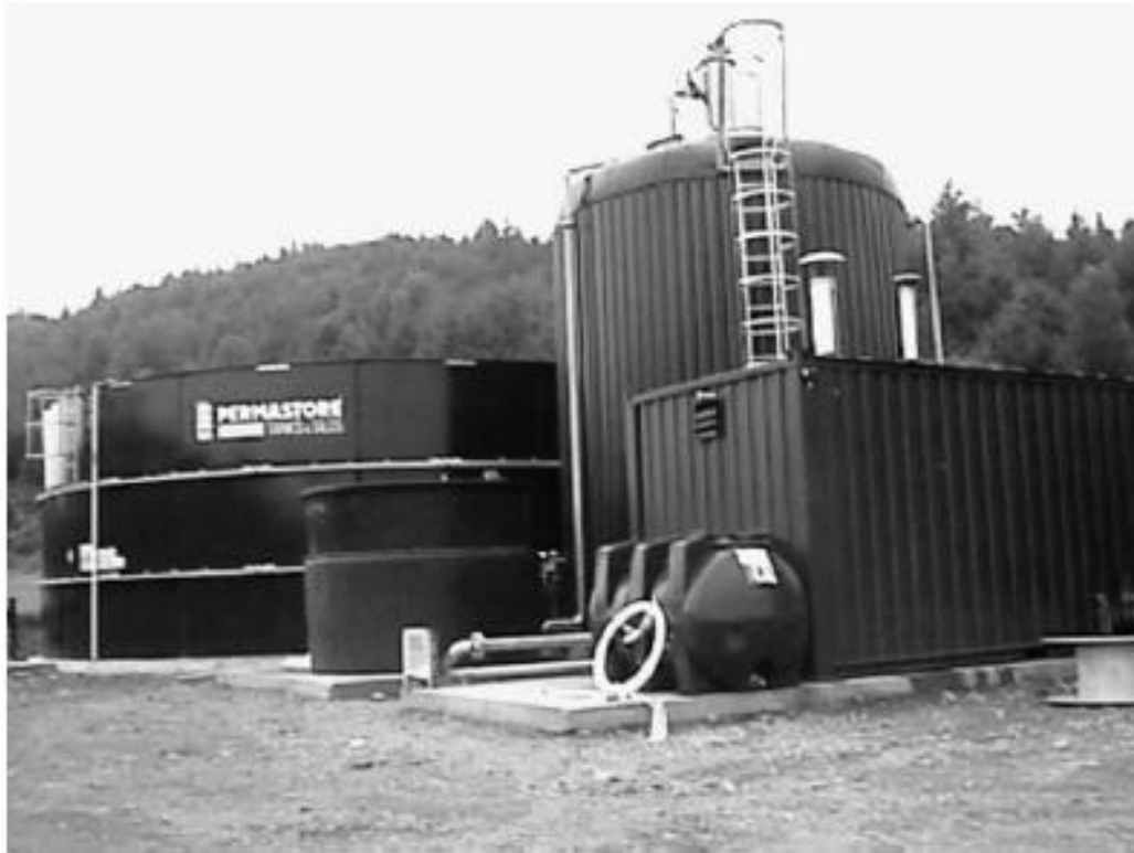
Şekil 7.3 Biyogaz alanı temel yapıları [17]
