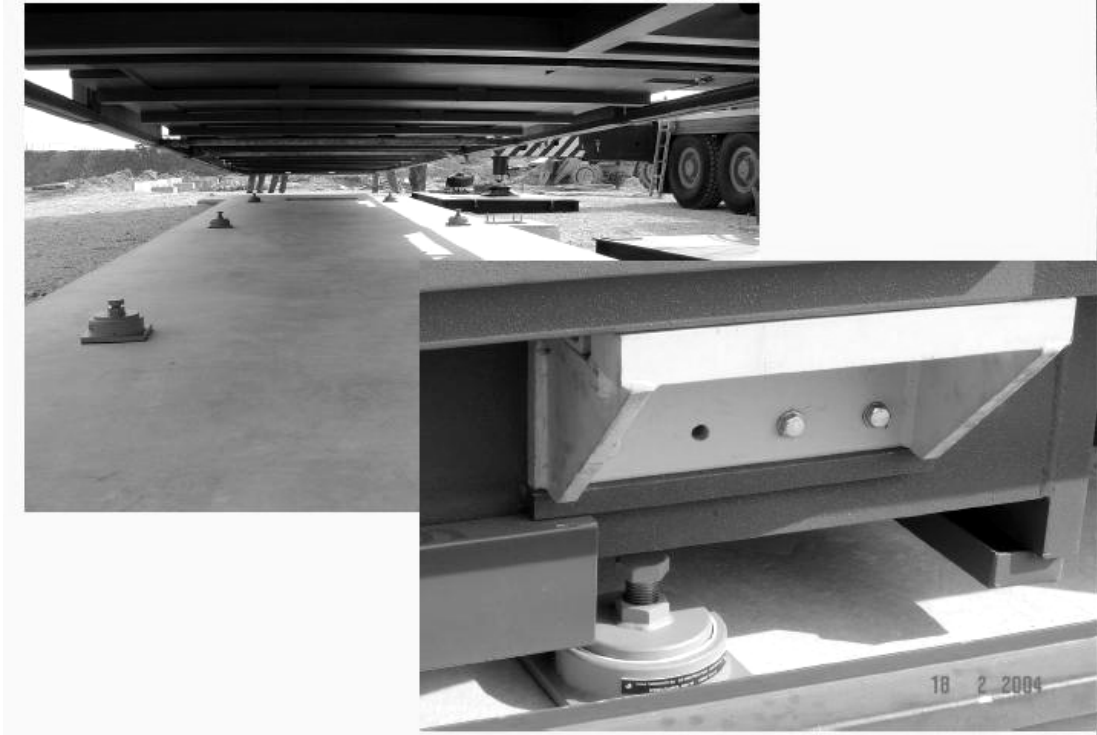
Şekil 8.13 Kojenerasyon sisteminin montajı [26]
