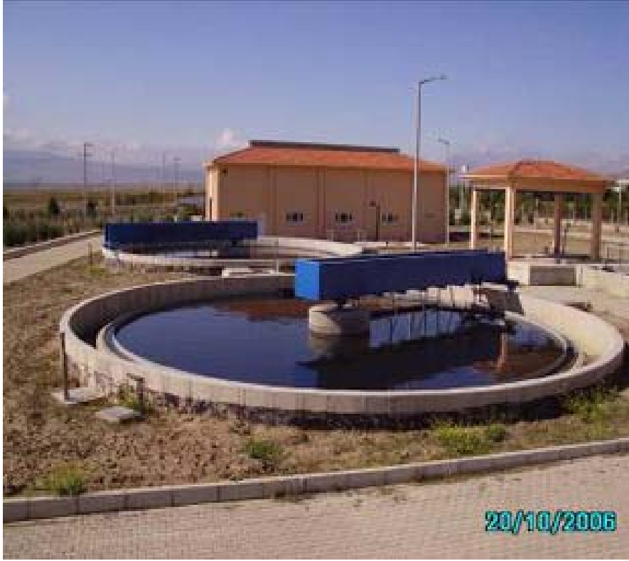
Şekil 1.3 Arıtma sistemlerinde kullanılan çöktürme havuzları [1]
