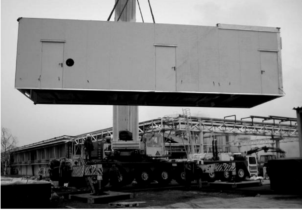
Şekil 8.12 Kojenerasyon sistemin yerleştirilmesi [26]
