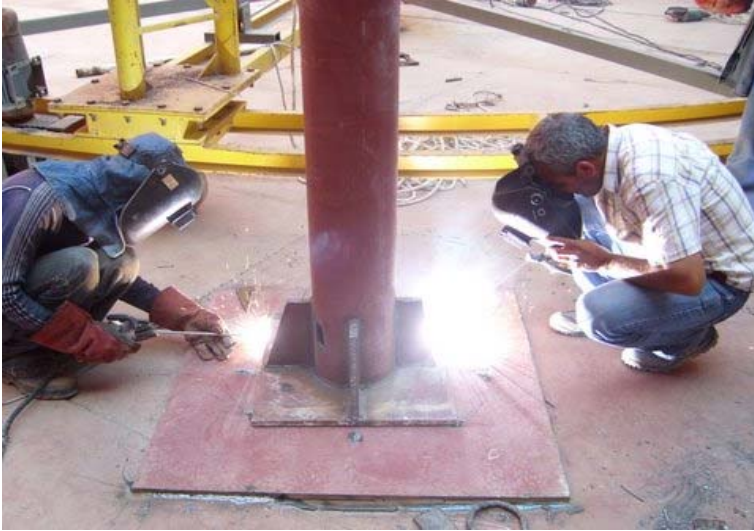
Şekil 4.46. Kolonların montajı
