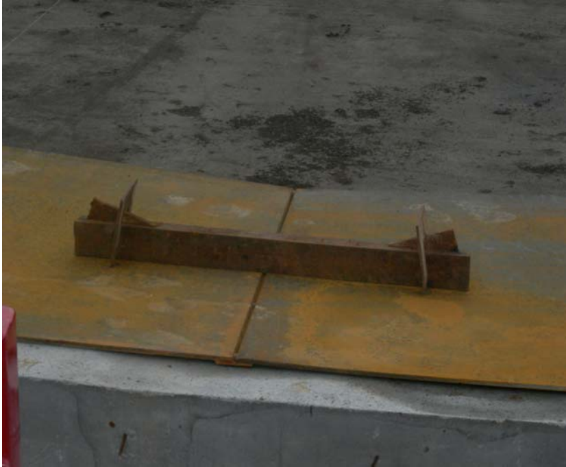
Şekil 4. 34. Kurtağzı ve kamanın kullanılışı
