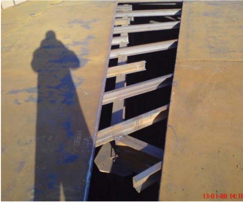
Şekil 4. 42. Çatı taşıyıcılarının görünüşü
