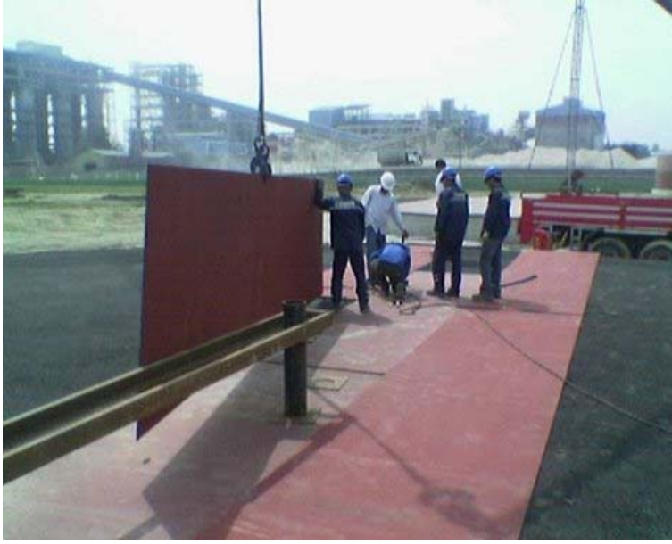
Şekil 4. 28. Tabandaki sacların serilmesi
