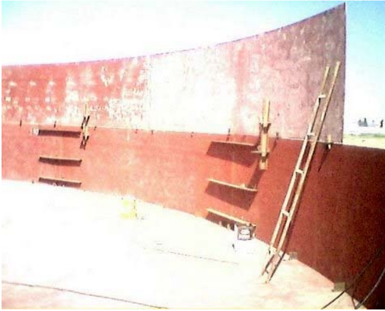
Şekil 4.39. Gvde saclarının montajı
