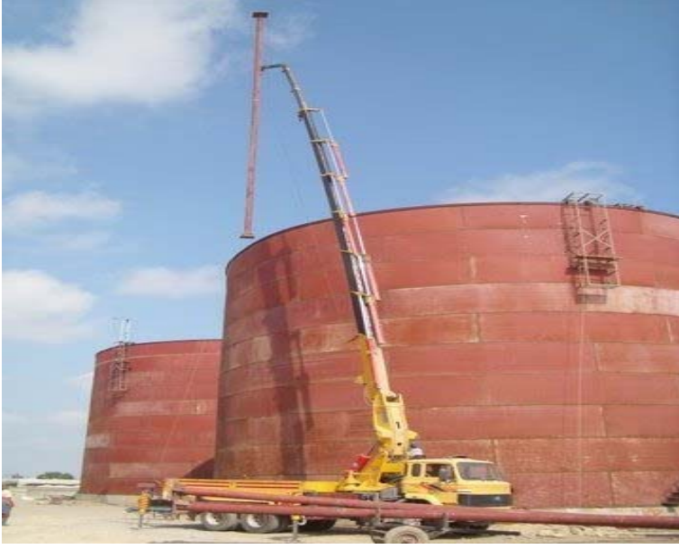
Şekil 4. 43. Tank içine kolonların konulması
