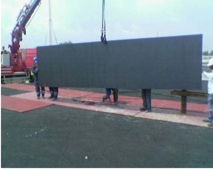
Şekil 4.37. Taban saclarının serilmesi
