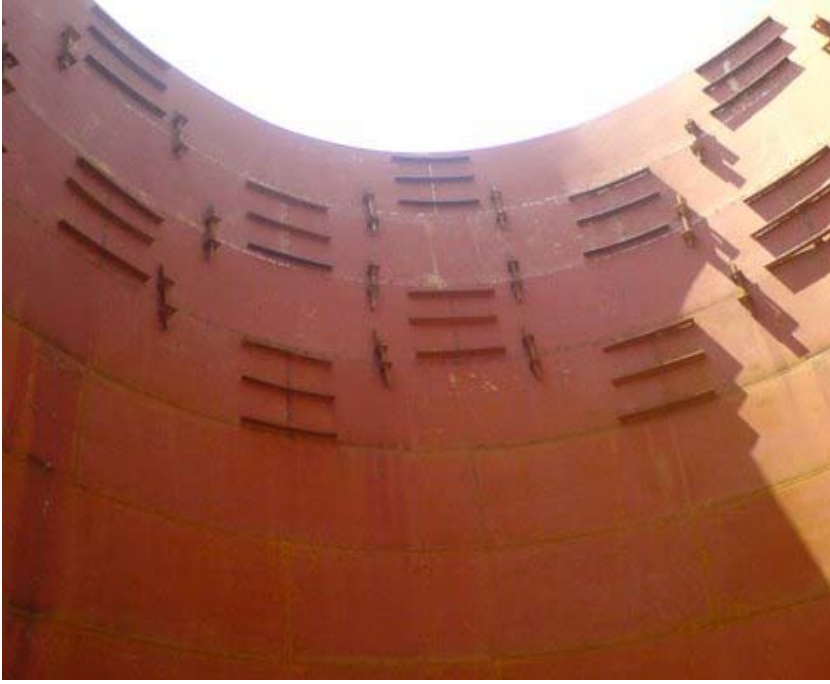
Şekil 4. 40. Gvde saclarının montajı
