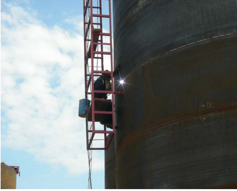
Şekil 4. 48. Tank kaynağının yapılışı.
