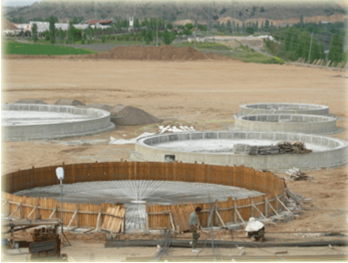
Şekil 4. 35. Temel inşaatından görünüş
