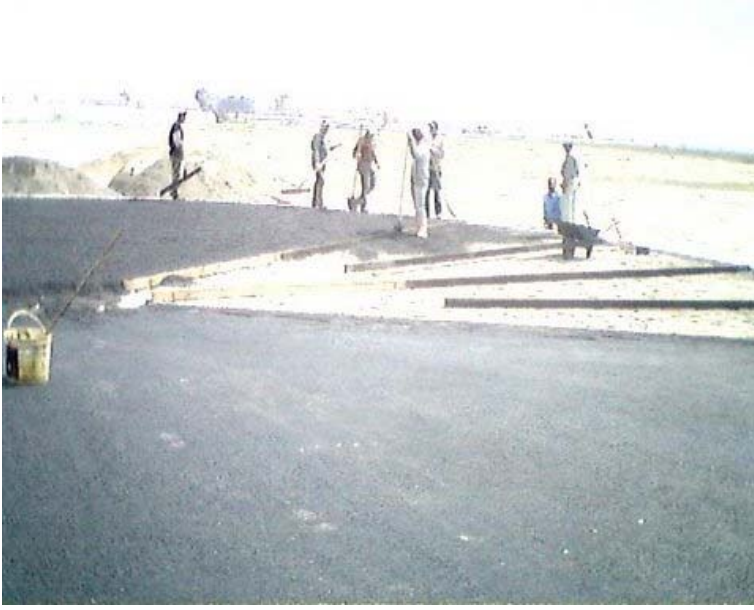
Şekil 4. 36. Temele asfalt serilmesi
