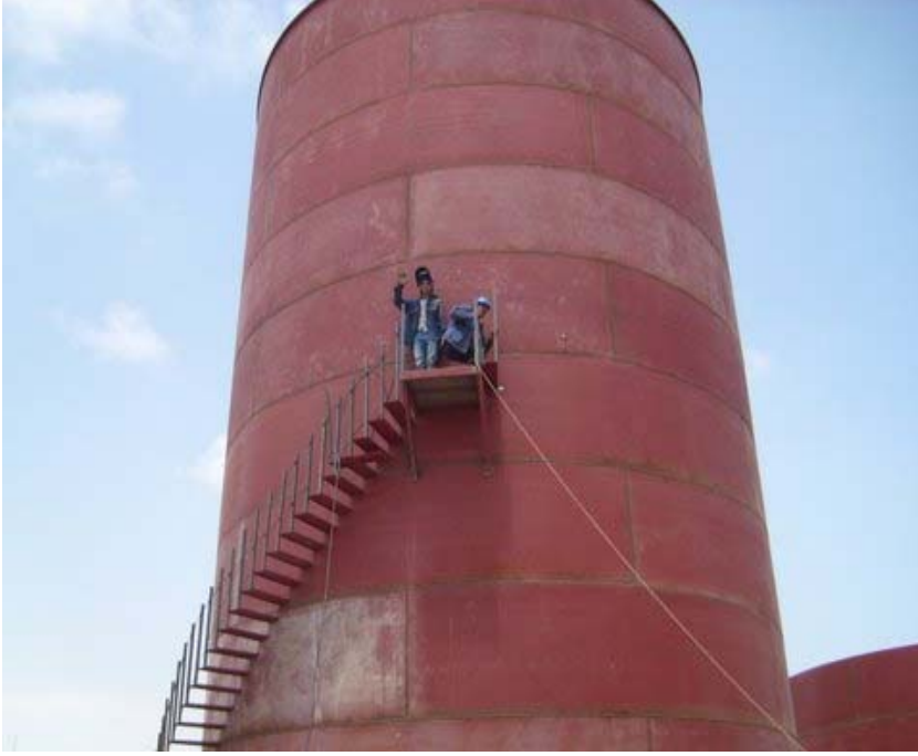
Şekil 4. 49. Tankta merdivenin montajı
