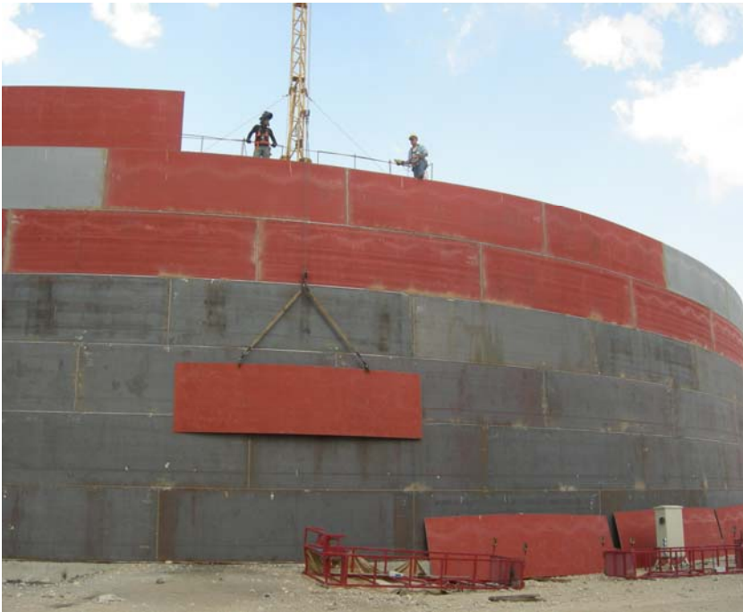
Şekil 4. 41. Gvde saclarının montajı
