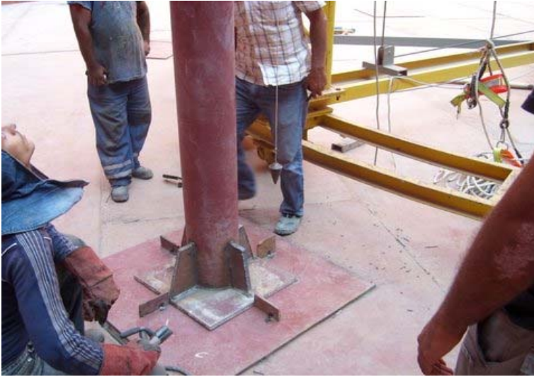
Şekil 4. 44. Kolonların şakülle kontrolü
