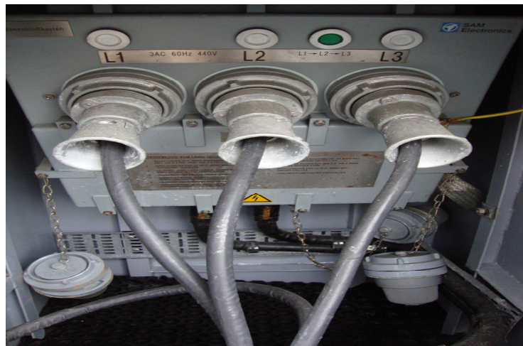
Şekil 5.2. A sınıfı gemiye ait sahil bağlantı panosu ve jak resmi
