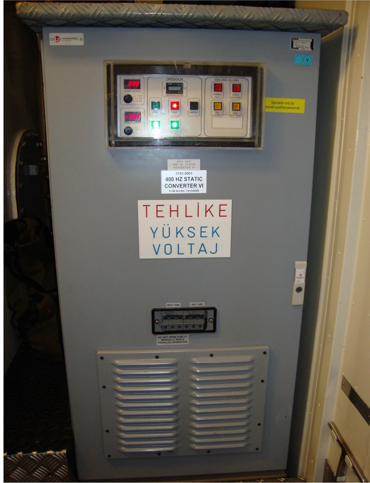
Şekil 3.8. Gemi tipi bir 60/400 Hz statik frekans konvertörü
