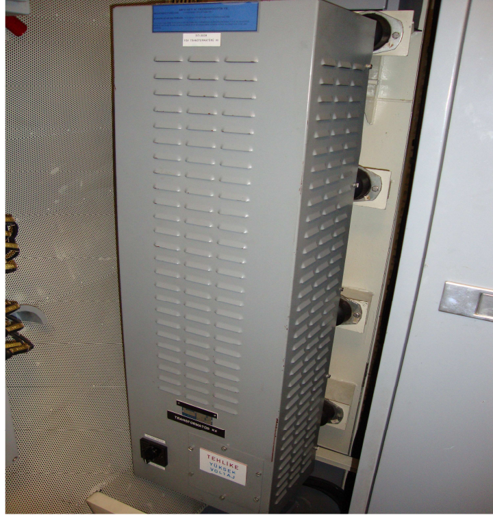
Şekil 3.9. Gemi tipi bir transformatör resmi
