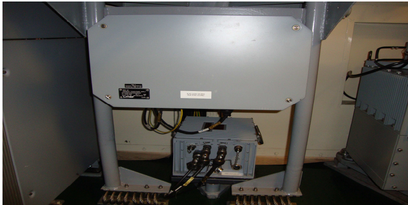
Şekil 3.12. Gemi tipi bir kesintisiz güç kaynağı resmi
