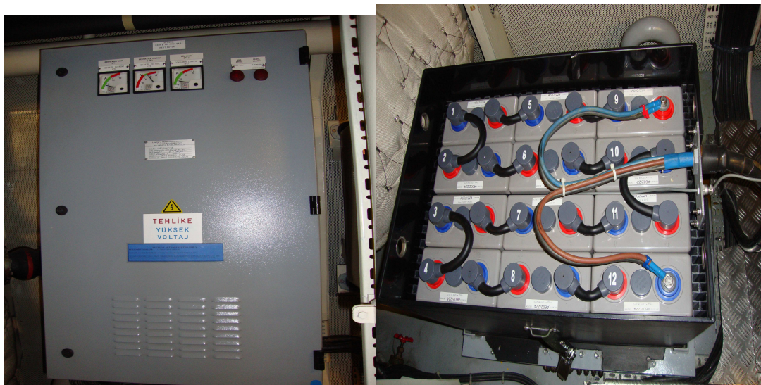
Şekil 3.13. Gemi tipi bir kesintisiz redresör ve akü grubu resmi
