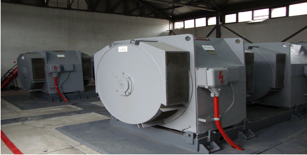
Şekil 6.3. Sahil elektrik santrali frekans konvertörleri
