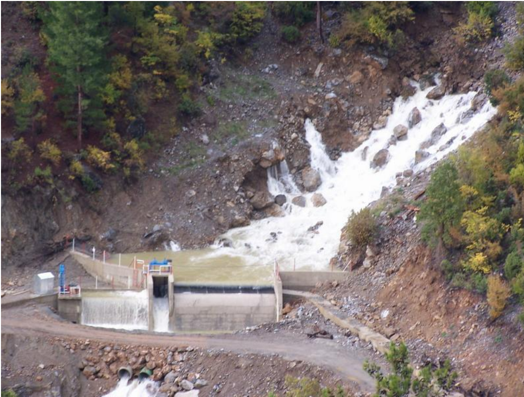
Şekil 1.2. Hidroelektrik Santral Sualma Yapısı ve Cansuyu Bırakılması Görünümü
