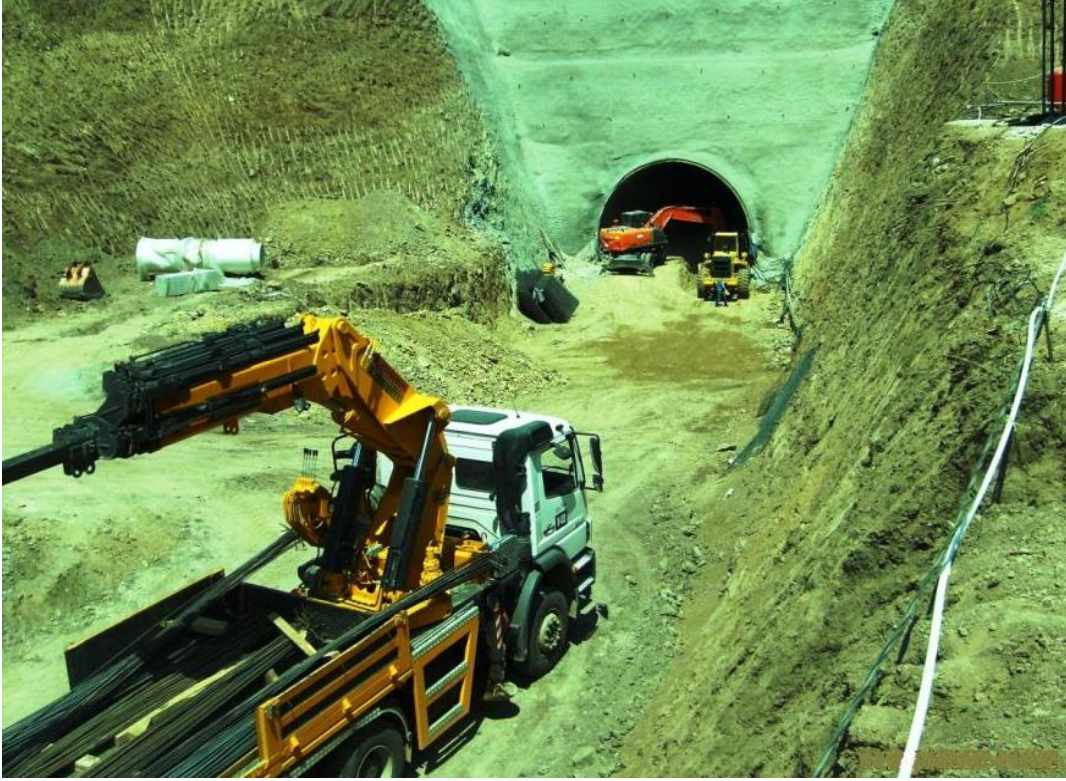
Ek.A.3.Çalışma Sahasında Yapılan Hidroelektrik Santral Tünel İnşaatından Görünüm
