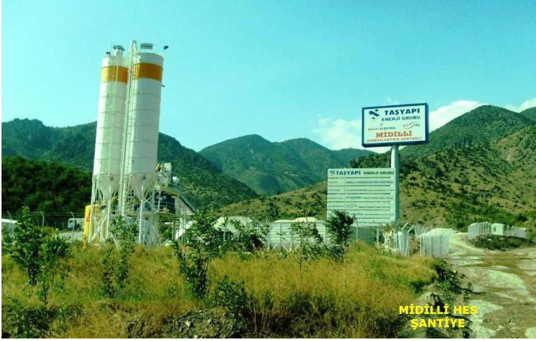
Ek.A.1.Çalışma Sahasında Yapılan Hidroelektrik Santral Şantiye Sahasından Görünüm
