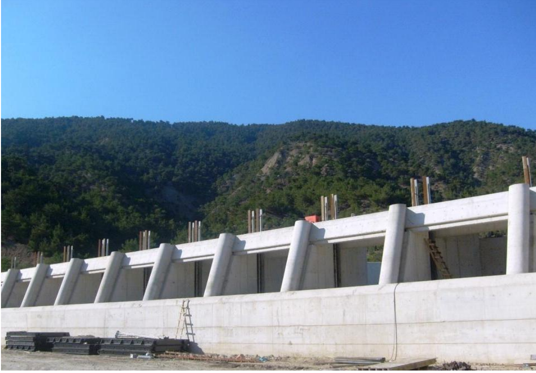
Ek.A.5.Çalışma Sahasında Yapılan Hidroelektrik Santralın Sualma Yapısı İnşaatından Görünümler
