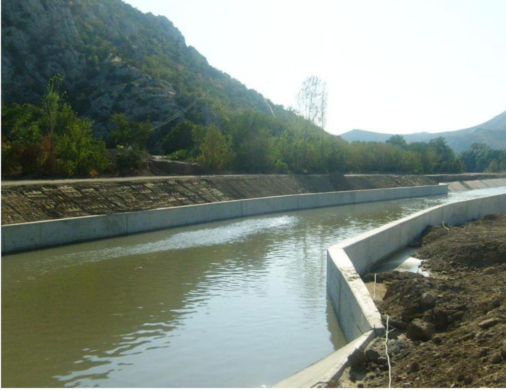
Ek.A.2.Çalışma Sahasında Yapılan Hidroelektrik Santral Derivasyon Kanalı Görünüm
