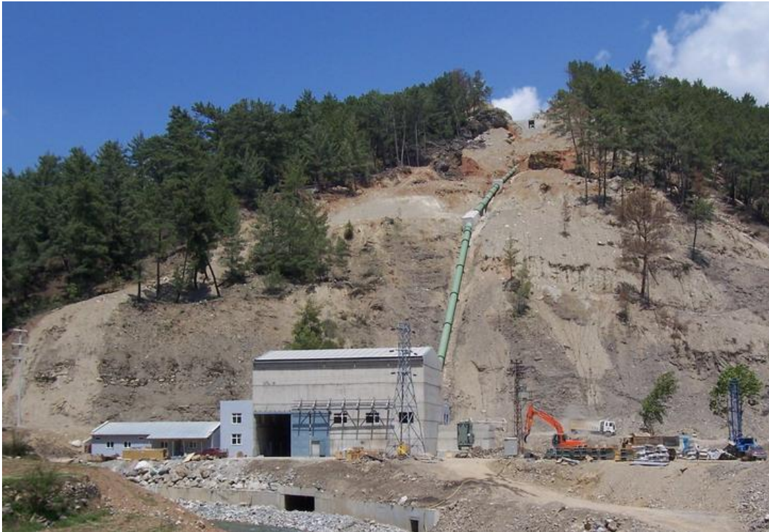
Ek.A.6.Çalışma Sahasında Yapılan Hidroelektrik Santrallerden Şantiye Görünümü
