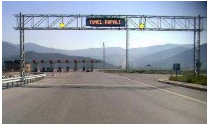
Şekil 2.19. Tünel girişi değişken uyarı levhası (Tünel kapalı)
