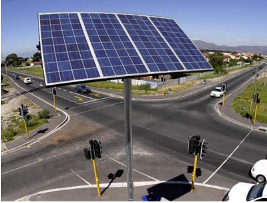
Şekil 2.9. Güneş enerjisi ile çalıştırılan trafik ışıkları
