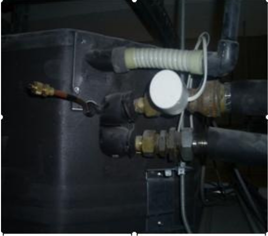
Şekil B.3.a. Termik vana fancoil uygulama şekli
