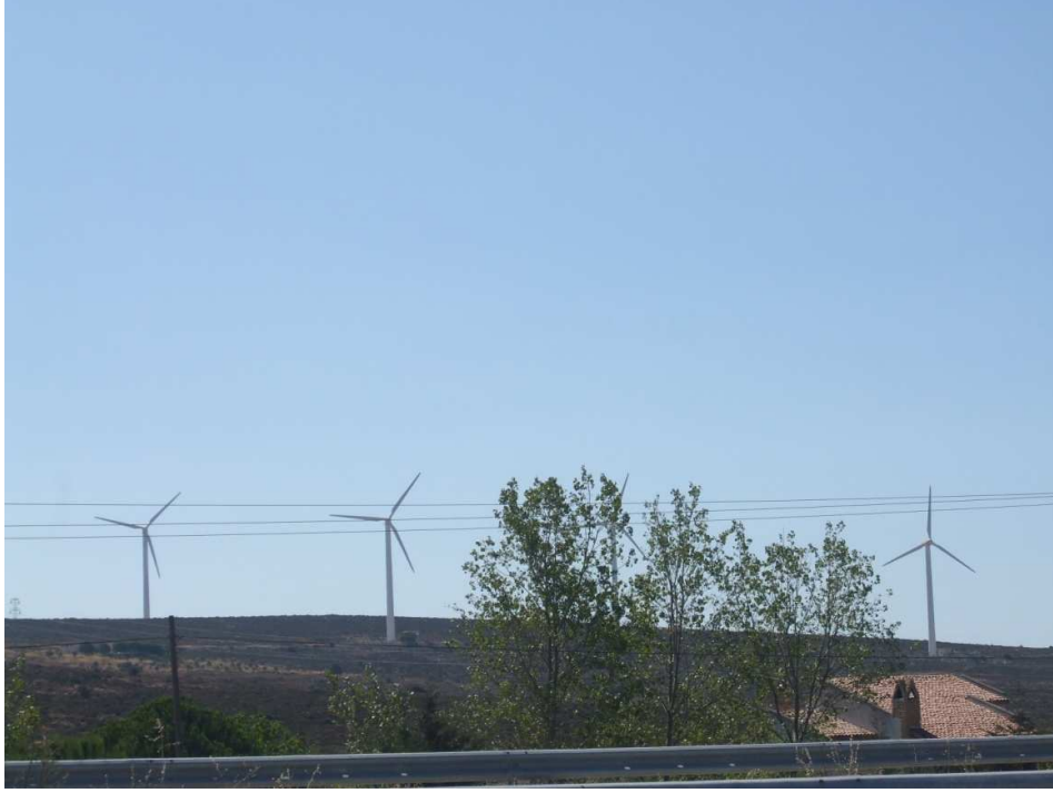
Şekil 3.7. Türkiye’ de kurulan ilk RES - Çeşme Alaçatı rüzgar santrali (12*600kW) görüntüsü
