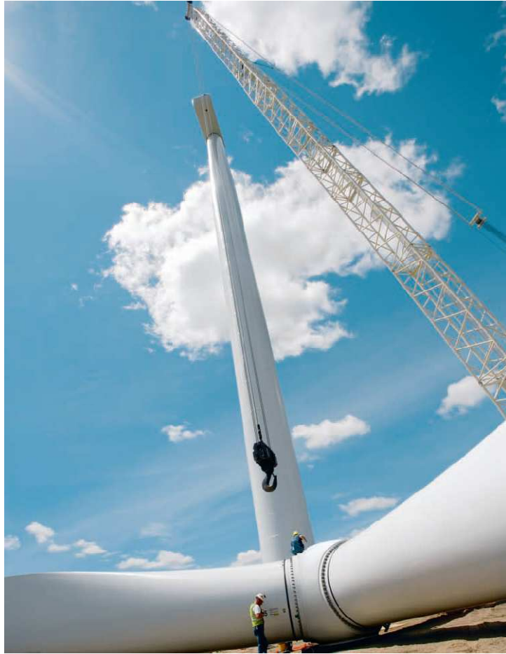
Şekil 6.1. Türbin ( 2,5 MW kapasiteli) montajı ( Kaynak : NORDEX )
