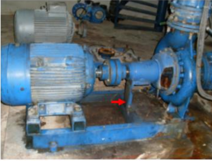
Şekil 4.9. Pompa mili ve şaft bağlantı noktası
