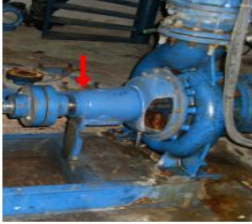
Şekil 4.15. Pompa rulman yatağı
