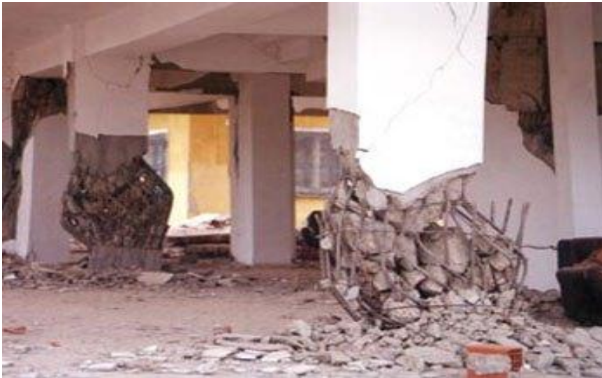
Şekil 3.13 Burulma Kuvveti Tesirinde Kalmış Kolonlar
