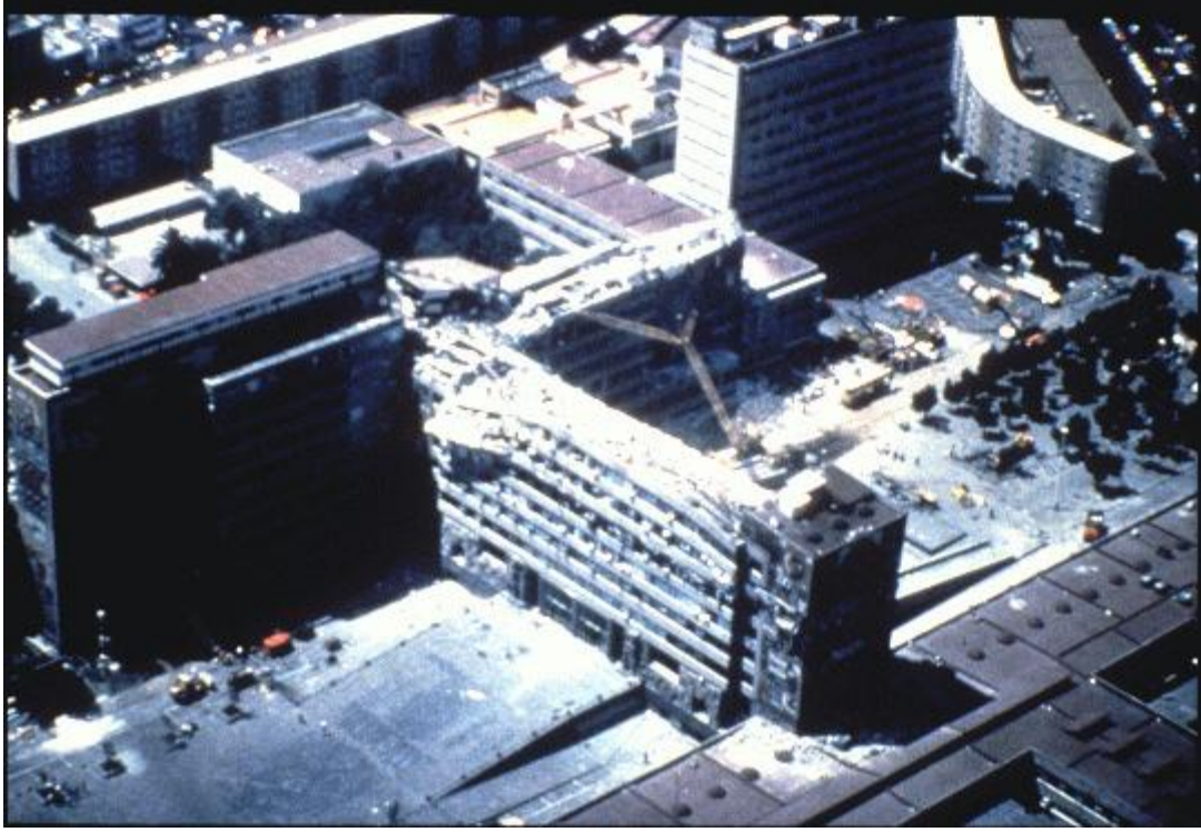
Şekil 3.14 Deprem Derzi Olmayan L Tipi Yapı Hasarı [9].
