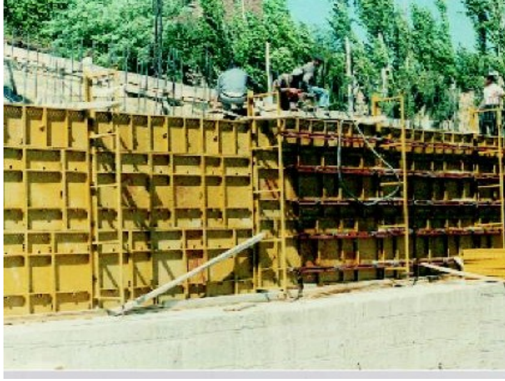
Şekil 2.2. Çelik çerçeveveli çelik yüzeyli kalıplar
