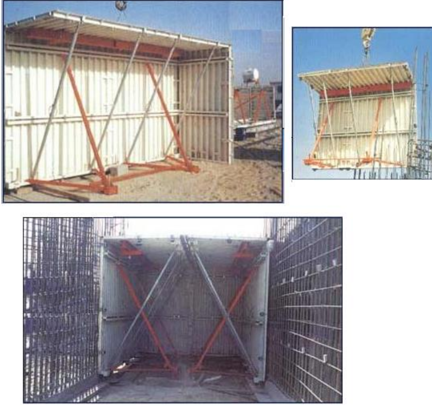
Şekil 2.29. Tam tünel kalıp elemanlarının oluşturduğu kalıp birimleri
