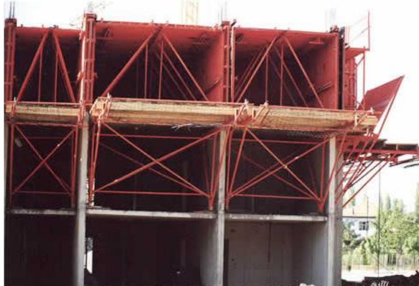
Şekil 2.31. Tünel kalıp sistemi deprem konutları Gölcük
