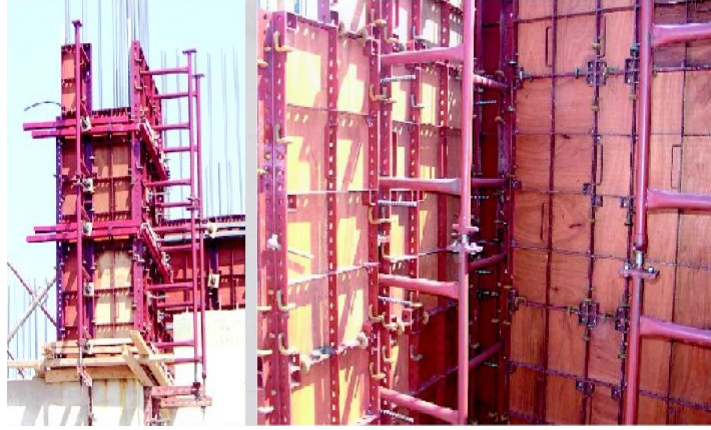
Şekil 2.5. Plywood uyumlu perde kalıbı
