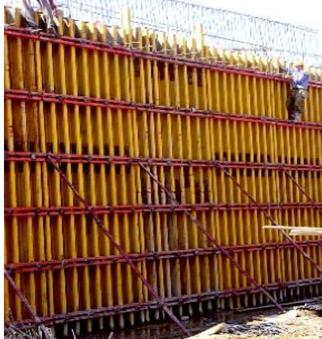
Şekil 2.6. Büyük yüzeyli sık kirişli perde kalıbı
