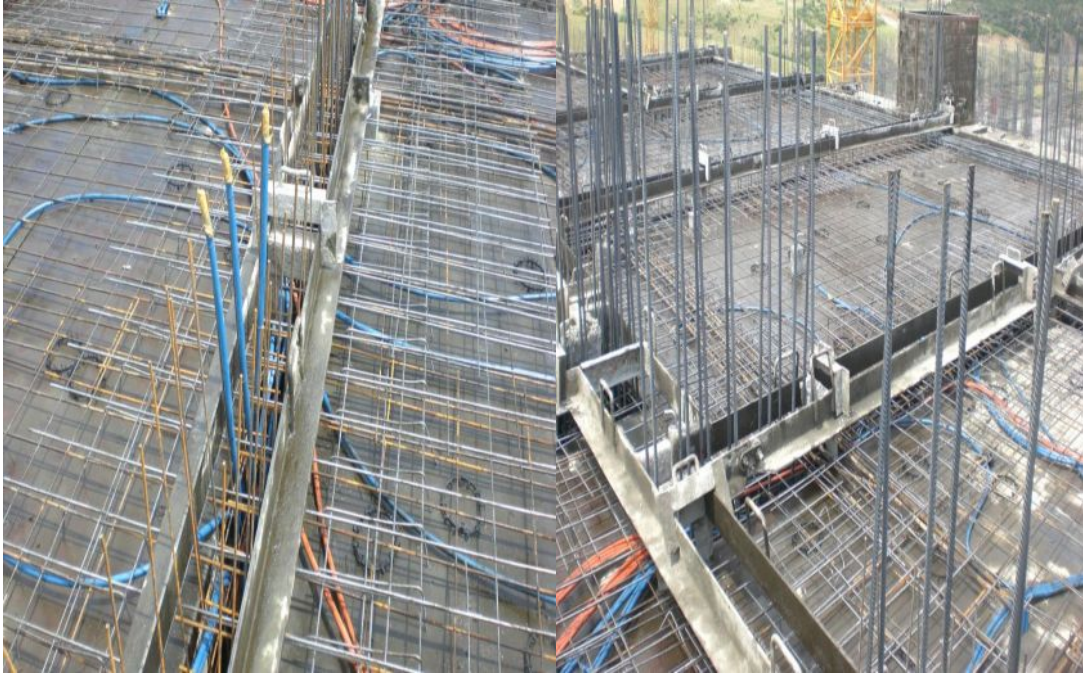
Şekil Ek A.18. Tünel kalıp tesisat yapımı
