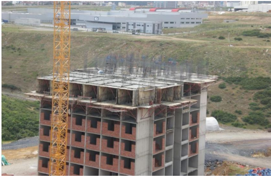
Şekil Ek A.22. Tünel kalıp sistem uygulaması
