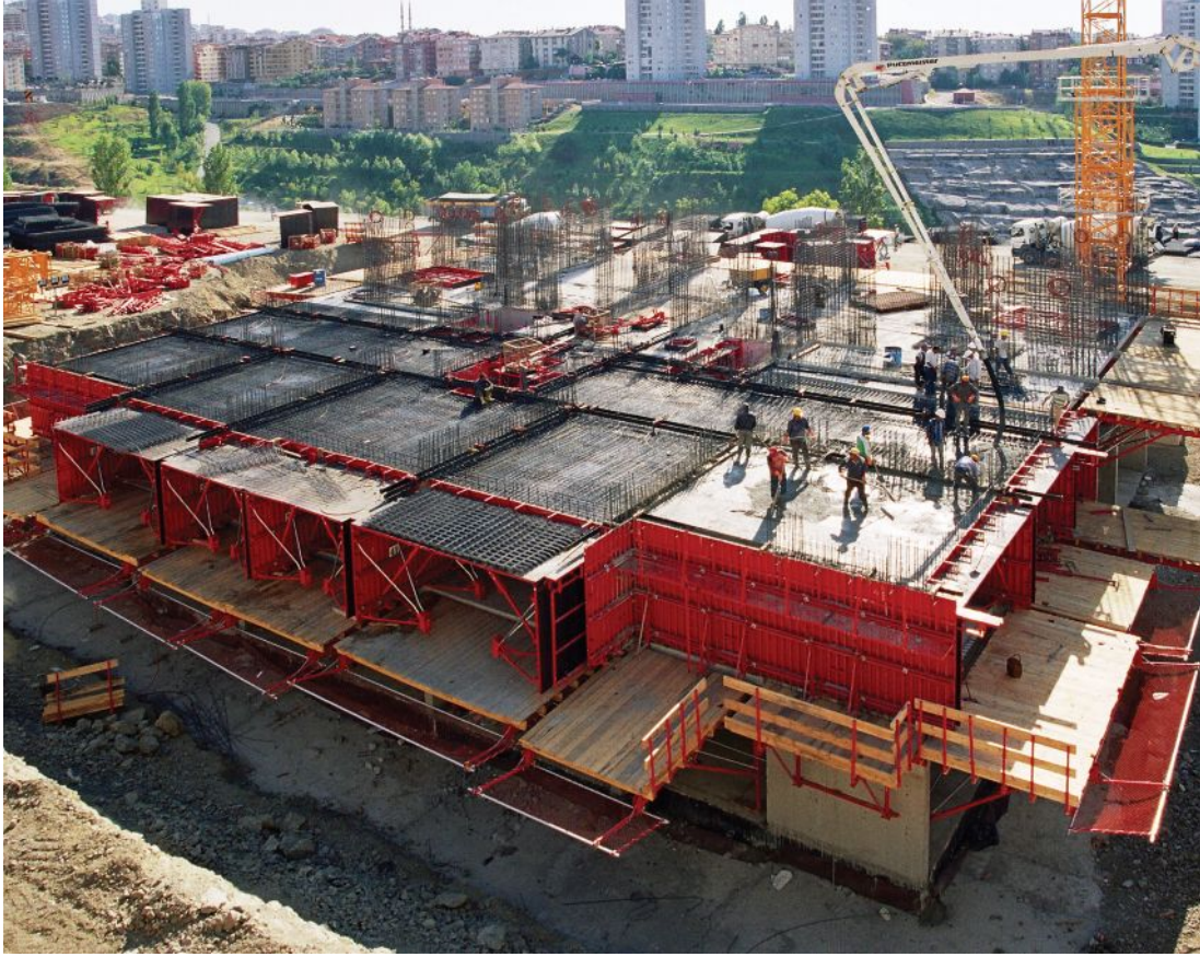
Şekil 2.3. Tünel Kalıp sistemi ile inşa edilen bir bina
