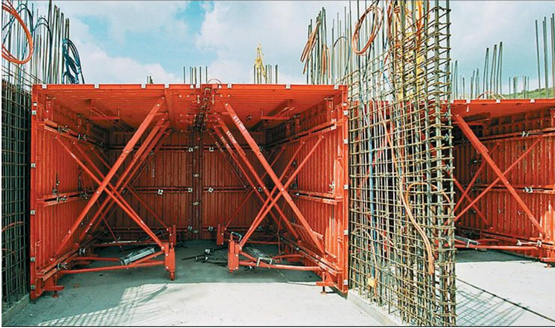
Őekil 2.8. Tam tnel kalıp sistemi
