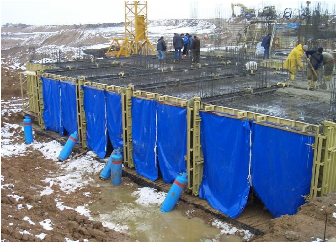
Şekil 2.15. Tünel kalıpta ısıtma sobaları ile kürleme
