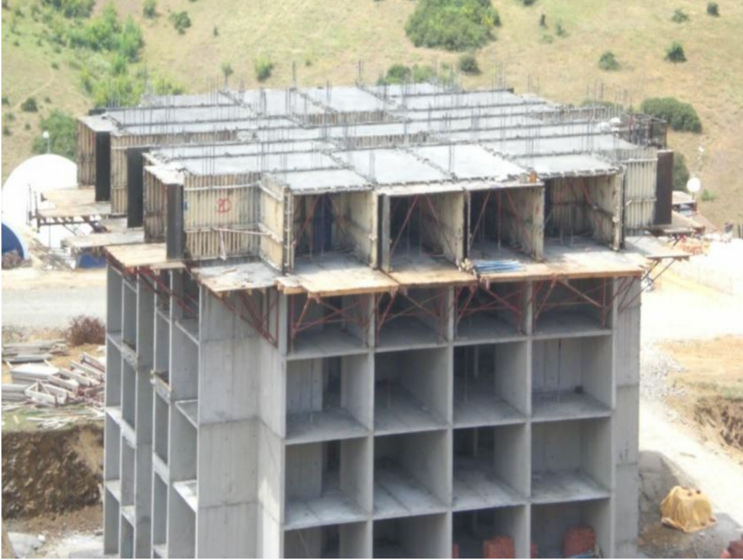
Şekil Ek A.21. Tünel kalıp sistem uygulaması
