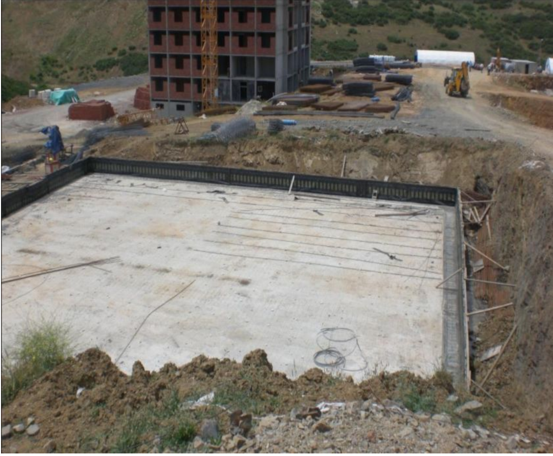
Şekil Ek A.17. Tünel kalıp zemini
