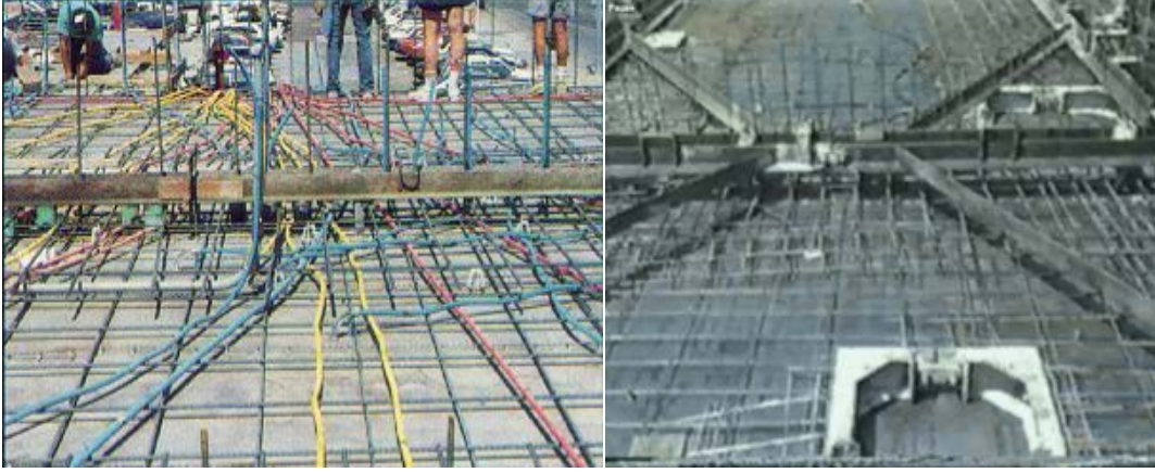
Şekil 2.22. Döşemedeki elektrik tesisatı boşluk rezervasyonları ve aks betonu kalıbı yerleşimi
