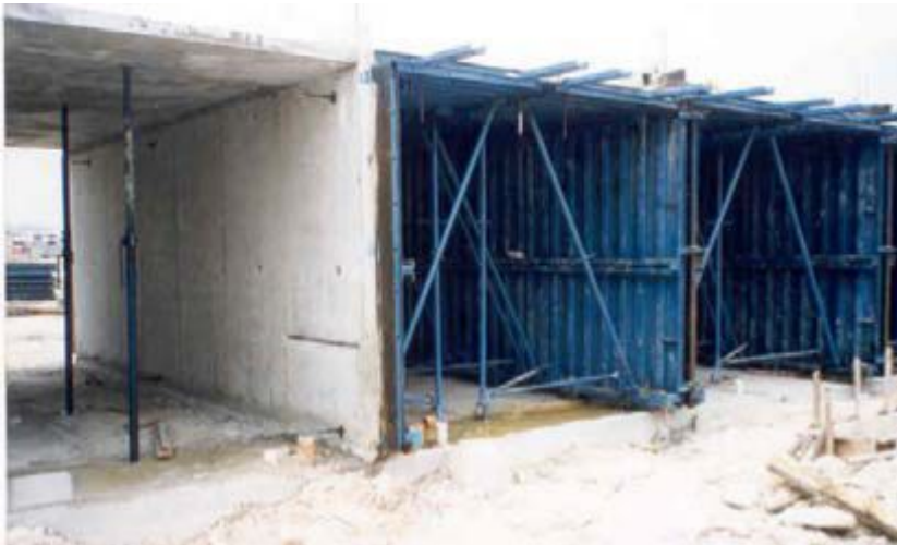
Şekil 2.23. Kalıbı alınan tünelin dikmelerle desteklenmesi (Resmin solunda)
