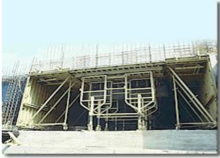
Şekil 2.17. Tünel Kalıplarda Masa Kalıp Uygulaması [3]
