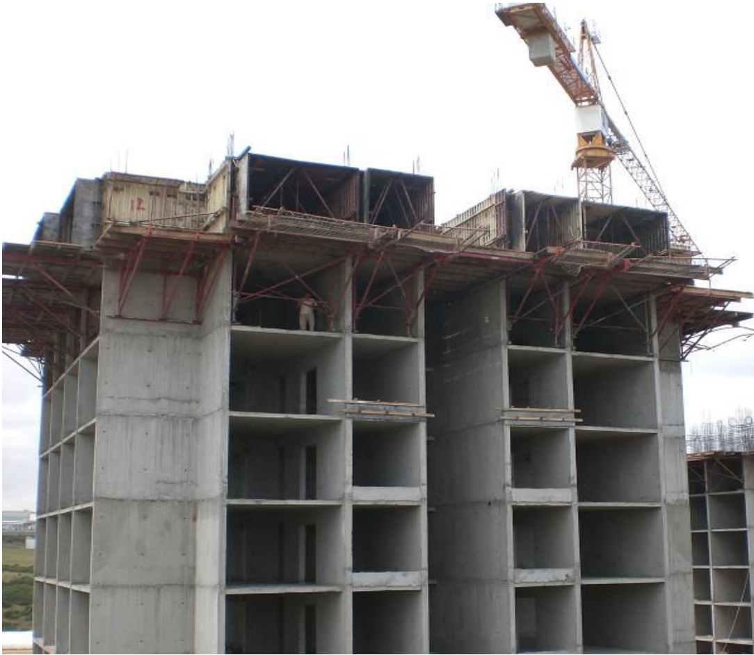
Şekil Ek A.20. Tünel kalıp sistem uygulaması
