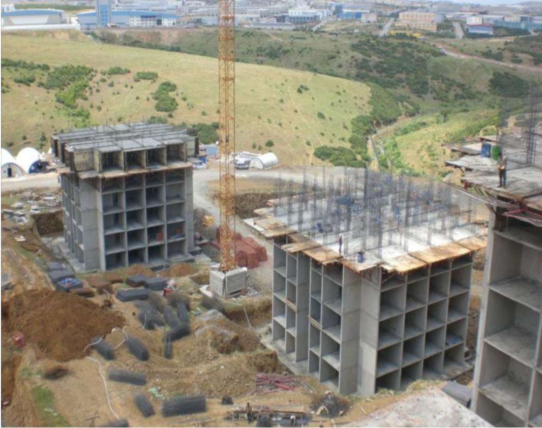
Şekil Ek A.1. Tünel kalıp sistem uygulaması
