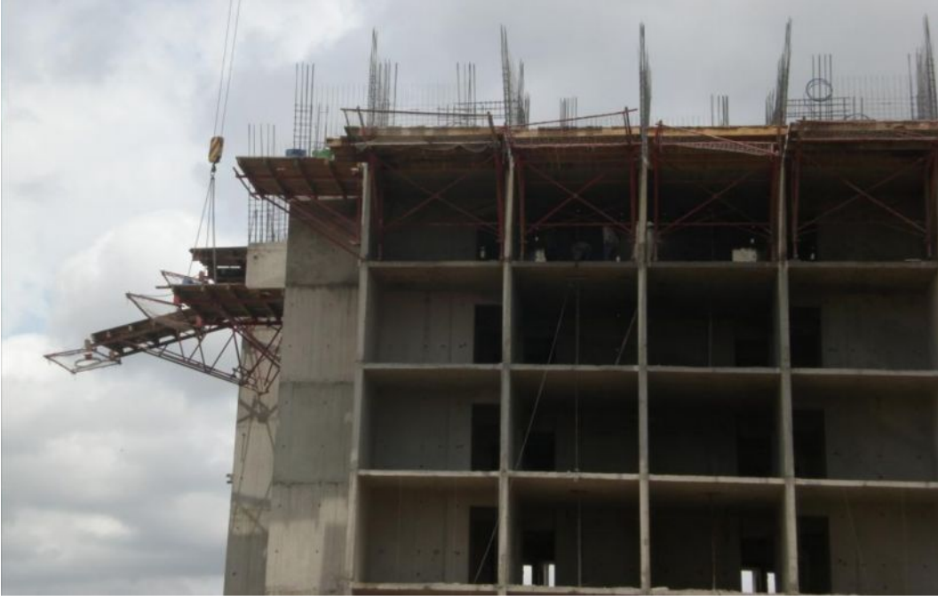
Şekil Ek A.19. Tünel kalıpların üst kata aktarımı
