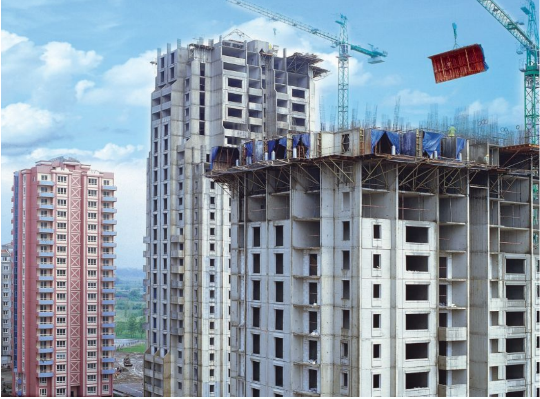
Şekil 2.1. Tünel kalıp sistemiyle inşa edilen bir bina
