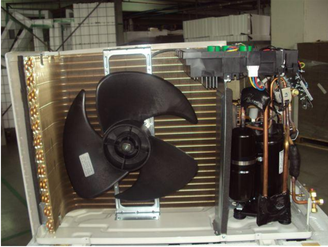
Şekil 6.1. Klima içerisinde kullanılan bakır boruların genel görüntüsü
