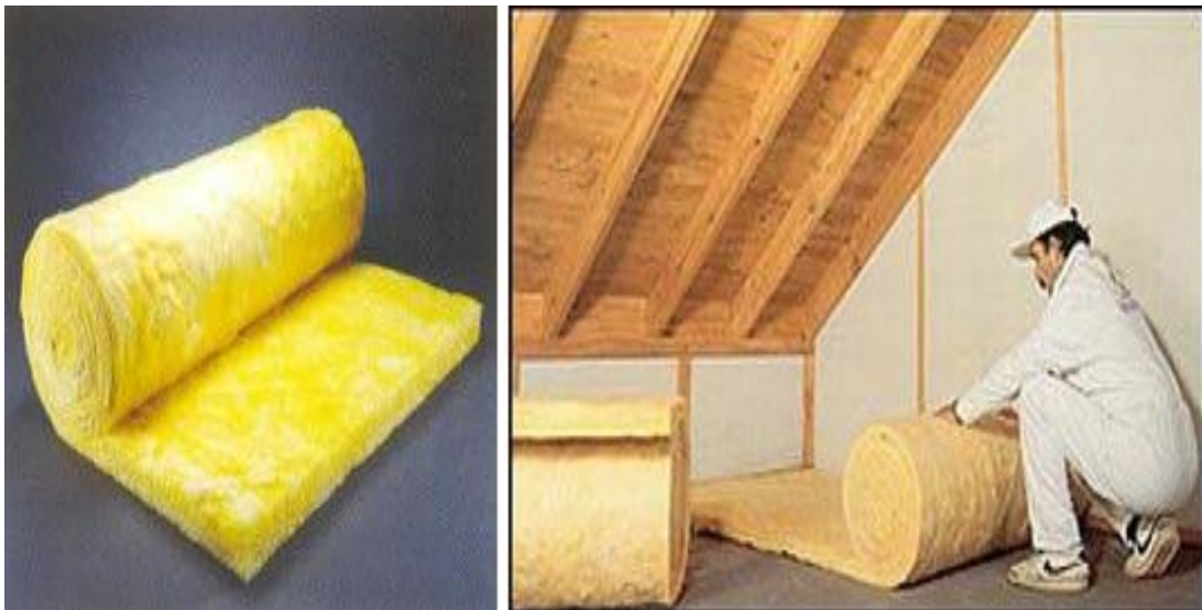
Şekil 5.7. Isıtılmayan bir çatı arasında cam yünü ısı yalıtım ürününün döşemeye serilmesi
