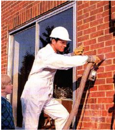
Şekil 6.31. Dış duvar yüzeyine açılan deliklere püskürtme makinesi ile yalıtım malzemesinin püskürtülmesi ile oluşan duvar kesiti [70], [77]
