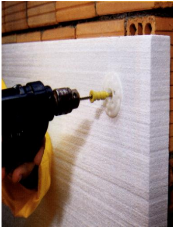
Şekil 6.10. Patlatma ve çakma dübellerin uygulanması [44]
