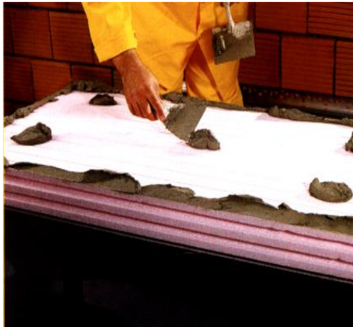
Şekil 6.8. Yapıştırma noktasal yapıştırma metodu [44]
