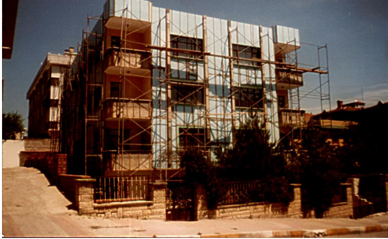
Şekil 6.3. Duvarların dış yüzeyine yapılan ısı yalıtım uygulaması
