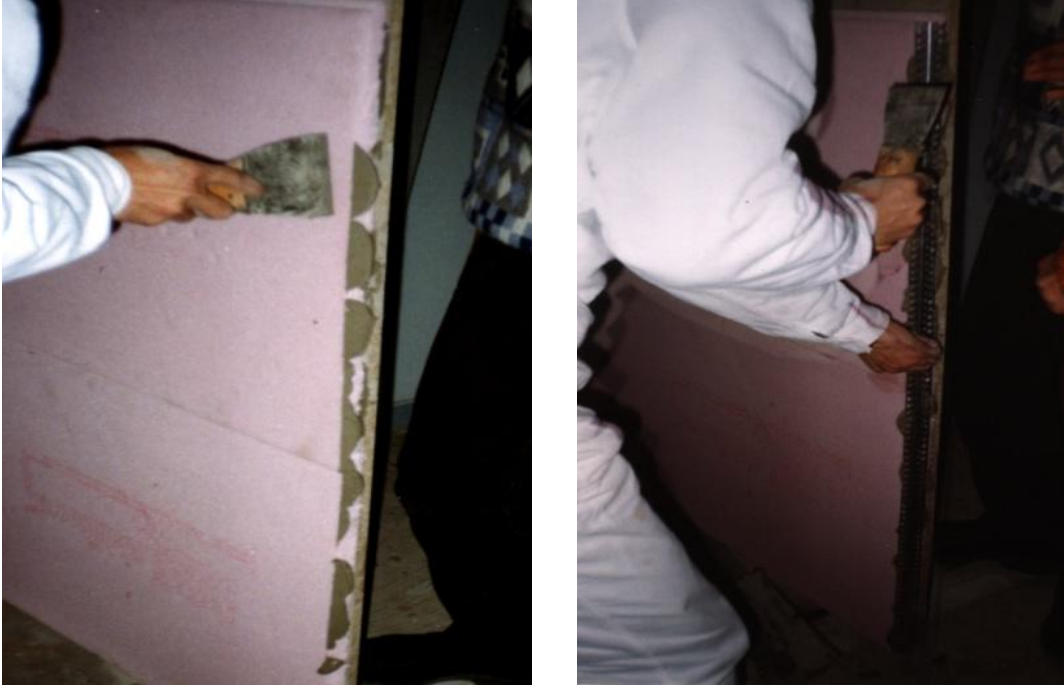
Şekil 6.11. Köşelerde düzgün bir kenar oluşturmak amacıyla özel köşe profillerinin uygulanması
