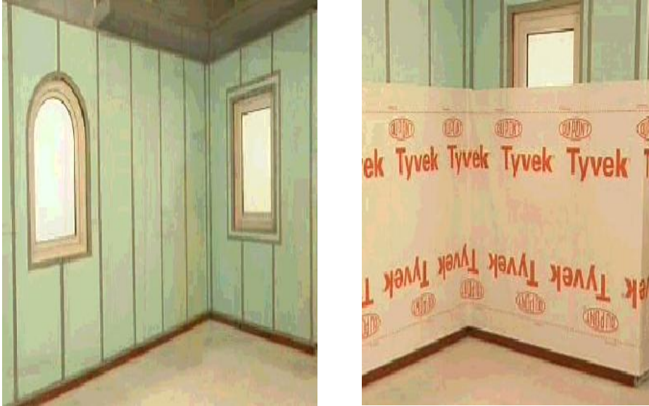
Şekil 6.42. Kadronlar arasına ısı yalıtım levhalarının ve buhar yalıtım örtüsünün yerleştirilmesi [82]
