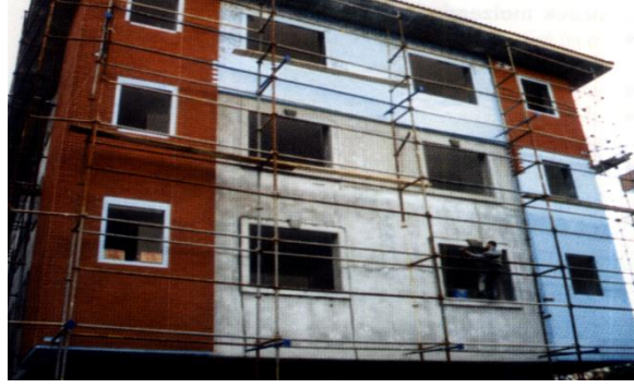
Şekil 6.36. Cephe tuğlası kaplamalı dış cephe uygulaması [66]
