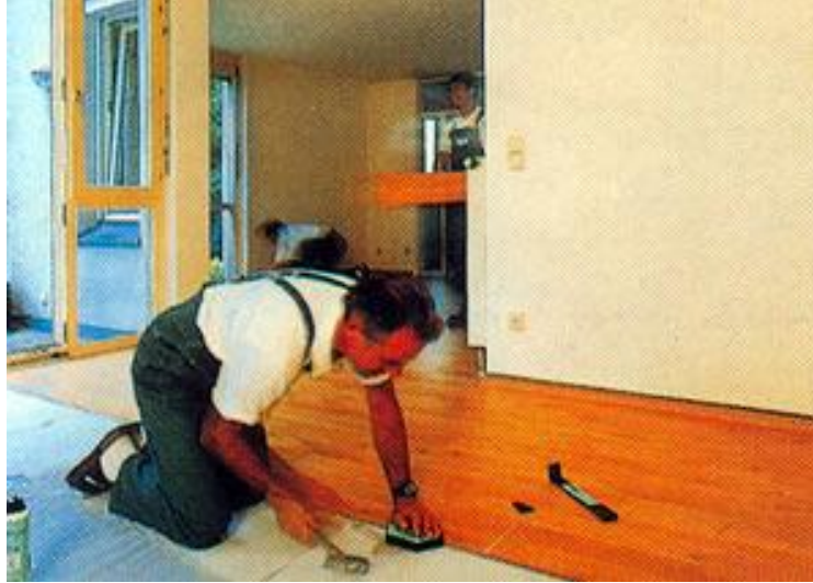
Şekil 5.35. Her iki tarafı polietilen kaplı levhaların yapı zeminine uygulanması
