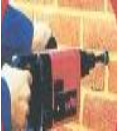
Şekil 6.30. Dış duvar yüzeyine matkapla delik açılması ve püskürtme makinesi ile yalıtım malzemesinin püskürtülmesi [70], [77]
