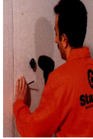
Şekil 6.20. Duvara sabitlenen levhada matkap ile dübel deliklerinin açılması ve tespit edilen dübellere çivi çakılması [67]
