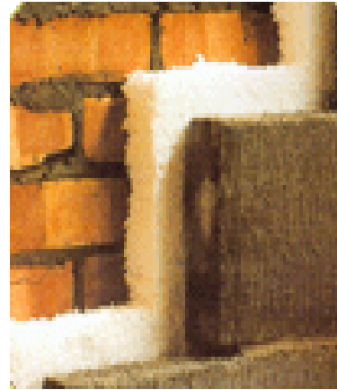
Şekil 6.31. Dış duvar yüzeyine açılan deliklere püskürtme makinesi ile yalıtım malzemesinin püskürtülmesi ile oluşan duvar kesiti [70], [77]
