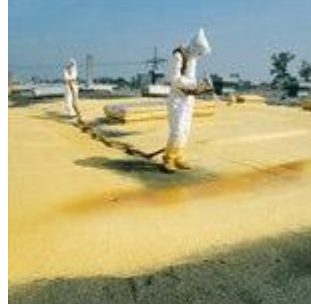
Şekil 5.29. Yapılarda poliüretan sert köpüğün püskürtülmesi yoluyla gerçekleştirilen ısı yalıtım uygulaması
