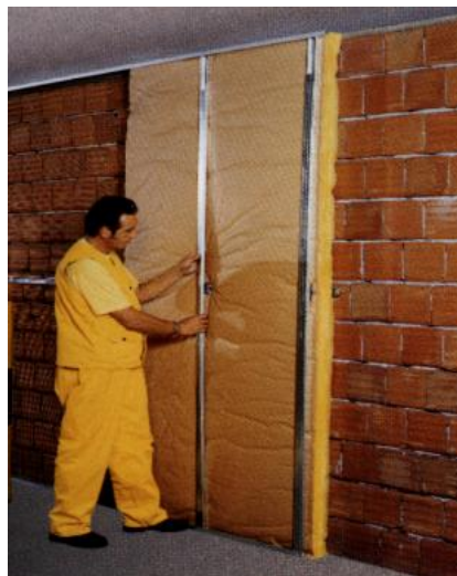
Şekil 6.23. Dikey C profillerinin yatay C profillerine tijler yardımıyla tespiti [44]
