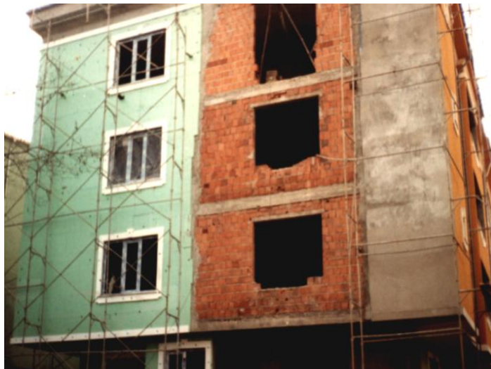
Şekil 6.4. Duvarların dış yüzeyine yapılan ısı yalıtım uygulaması
