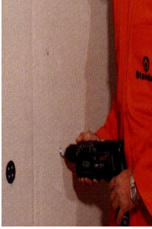
Şekil 6.20. Duvara sabitlenen levhada matkap ile dübel deliklerinin açılması ve tespit edilen dübellere çivi çakılması [67]
