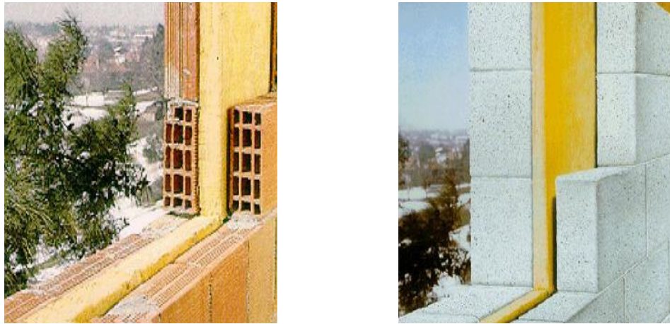
Şekil 6.27. Çift duvar arasında boşluksuz ısı yalıtım uygulaması [73]
