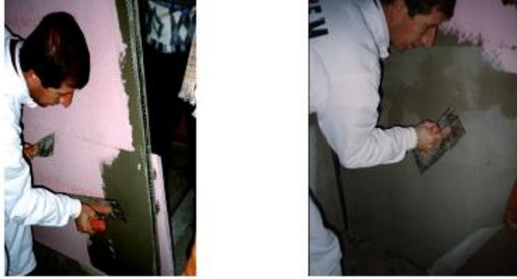
Şekil 6.12. Alt kat sıvasının yüzeye mala ile sürülmesi ve üzerine donatı filesinin uygulanması
