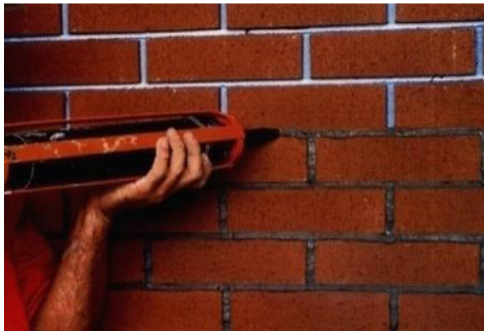
Şekil 6.35. Kaplama tuğlalar arasında derz dolgusu uygulaması [66]
