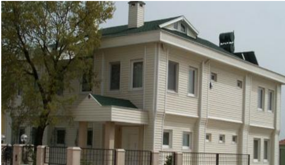
Şekil 6.46. Dış cephesine yalı baskısı uygulanmış yapı
