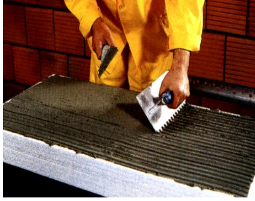
Şekil 6.9. Yapıştırımda dişi mala metodu [44]
