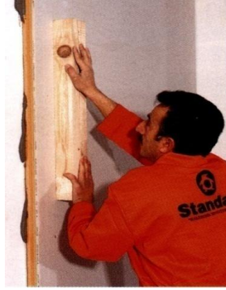
Şekil 6.19. Levhanın duvar yüzeyine yapıştırılması ve mistar ile preslenerek teraziye alınması [67]
