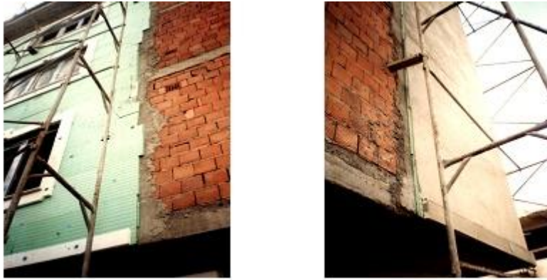
Şekil 6.13. Cephede yalıtım katmanının üzerine yapılan sıva uygulaması
