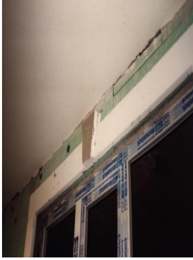
Şekil 6.15. Pencere kenar ölçülerine göre boyutlandırılmış EPS yalıtım malzemesinin cephede dekoratif amaçlı uygulanması
