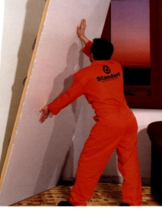
Şekil 6.19. Levhanın duvar yüzeyine yapıştırılması ve mistar ile preslenerek teraziye alınması [67]
