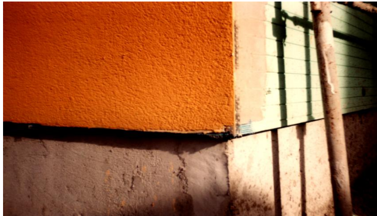
Şekil 6.14. Cephenin zemine yakın yerlerinde darbelere karşı güçlendirilmiş donatı filesi ve güçlendirilmiş son kat sıvanın uygulaması
