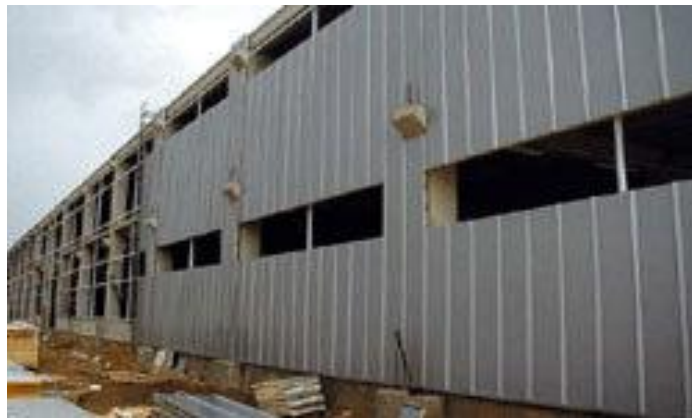
Şekil 5.28. Yapılarda poliüretan sert köpükten oluşturulmuş kompozit panelin dış cephede uygulanması
