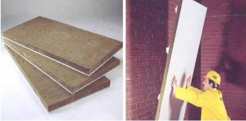
Şekil 5.12. Kalibel ısı yalıtım ürününün duvarda uygulanması
