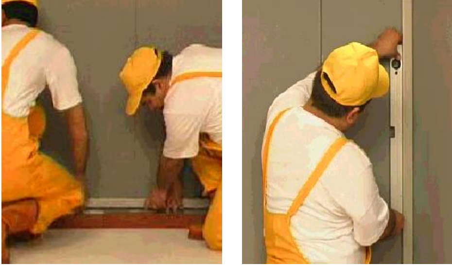
Şekil 6.41. Subasman kadronu ve taşıyıcı polimer kadrnların montajı [82]
