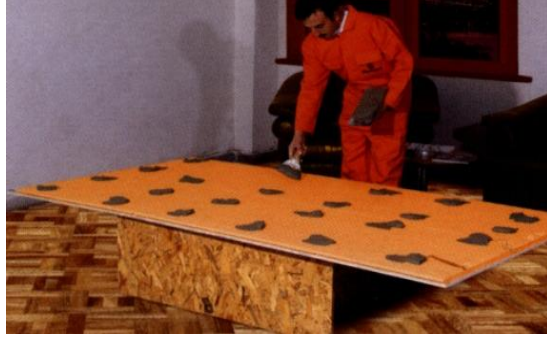
Şekil 6.18. Yapıştırıcının levhalara uygulanması [67]
