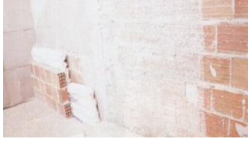
Şekil 5.18. Genleştirilmiş perlit şiltenin çift duvar arasında uygulanması
