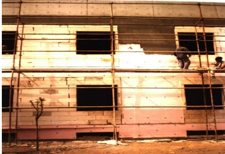
Şekil 6.62. Isı köprülerinde yalıtım uygulaması
