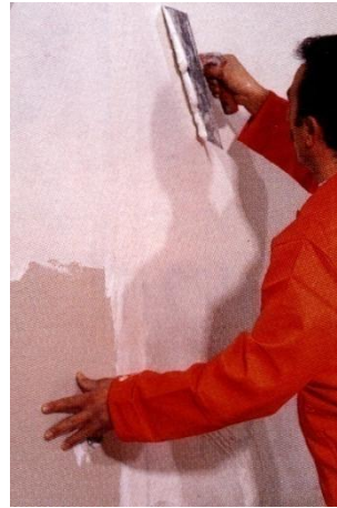
Şekil 6.21. Levha birleşim yerlerindeki derz bantı üzerine derz dolgu alçısı takviyesi ve levha yüzeyinin alçı sıva ile sıvanması [67]
