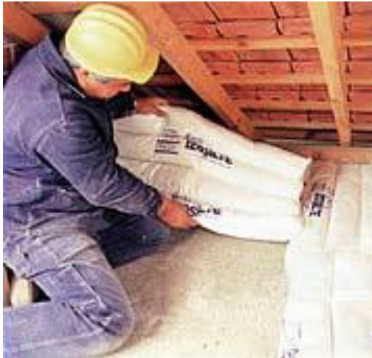
Şekil 5.17. Genleştirilmiş perlit şiltenin kapalı çatılarda uygulanması
