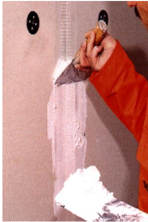
Şekil 6.21. Levha birleşim yerlerindeki derz bantı üzerine derz dolgu alçısı takviyesi ve levha yüzeyinin alçı sıva ile sıvanması [67]
