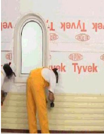
Şekil 6.43. Cephe kaplama panellerinin ve saçak profilleri ile alın profillerinin montajı [82]
