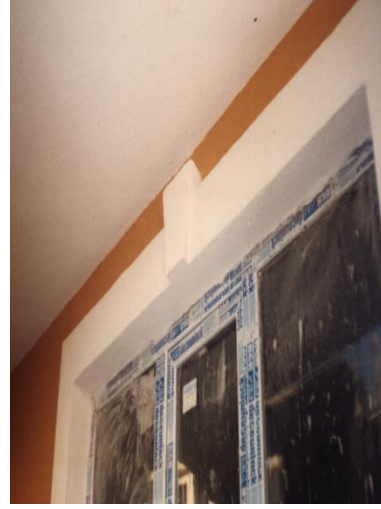
Şekil 6.15. Pencere kenar ölçülerine göre boyutlandırılmış EPS yalıtım malzemesinin cephede dekoratif amaçlı uygulanması
