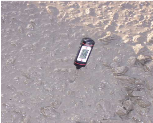
Şekil 5.21. Beton sıcaklığının tespiti
