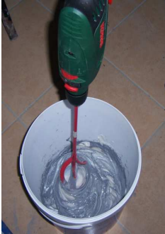
Şekil 5.27. Spiral uçlu elektrik matkapla iki bileşenin karıştırılması
