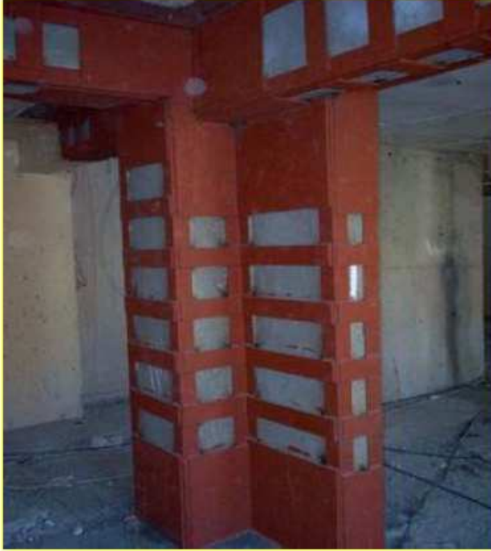
Şekil 4.4. Çelik levha ile güçlendirilmiş kolon ve kiriş
