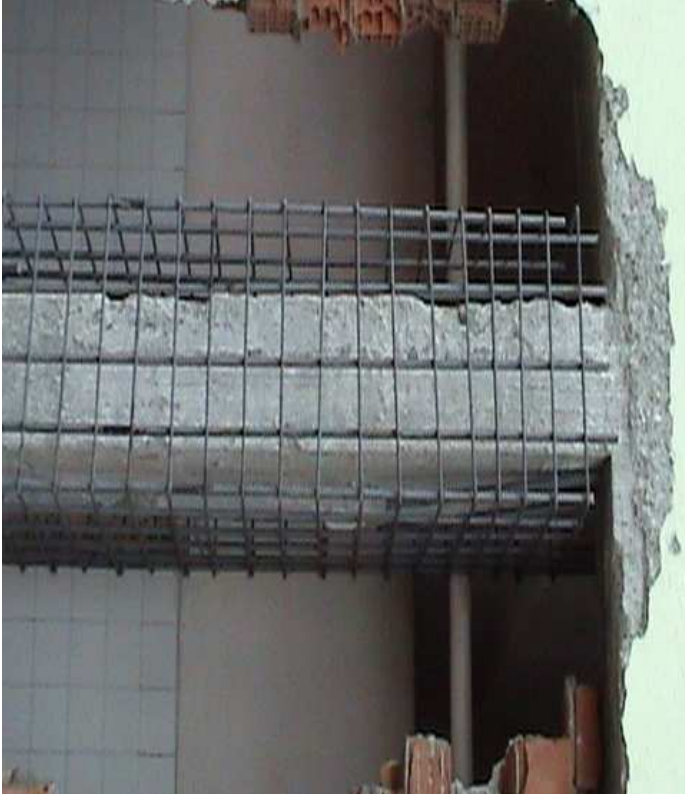
Şekil 4.2. Mantolanmış kiriş
