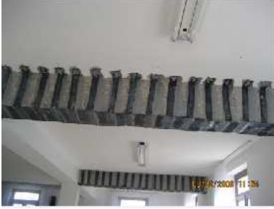
Şekil 4.5. Kirişlerin LP sargı ile güçlendirilmesi
