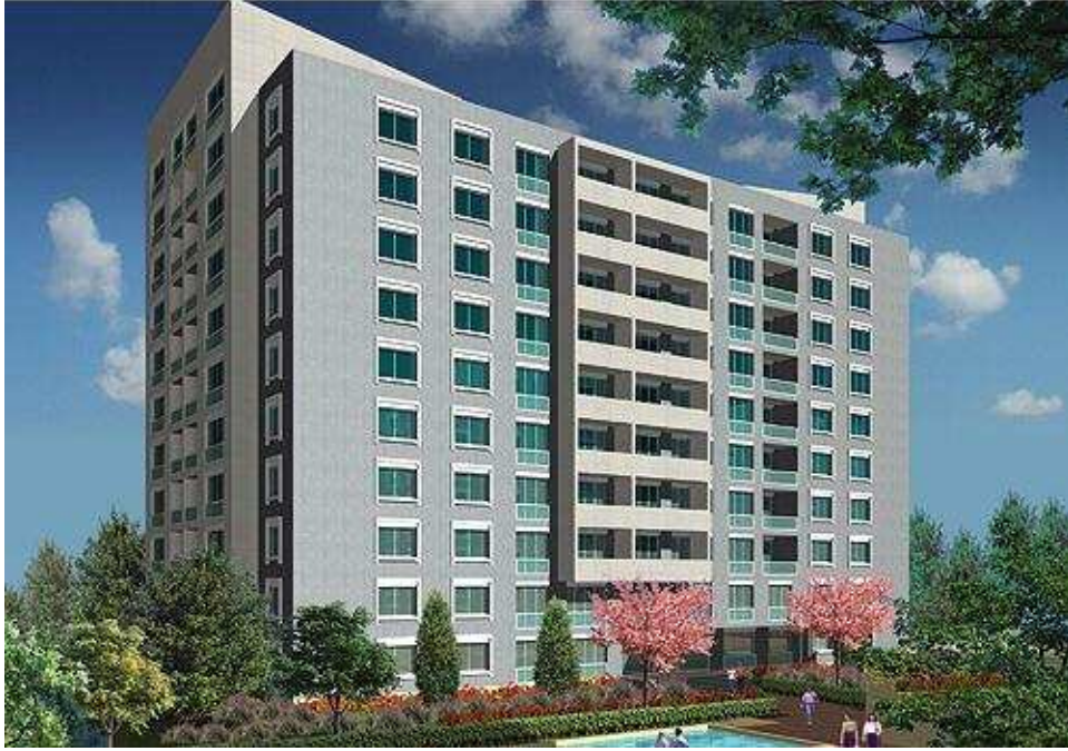
Şekil 3.6. Blok genel görünüş
