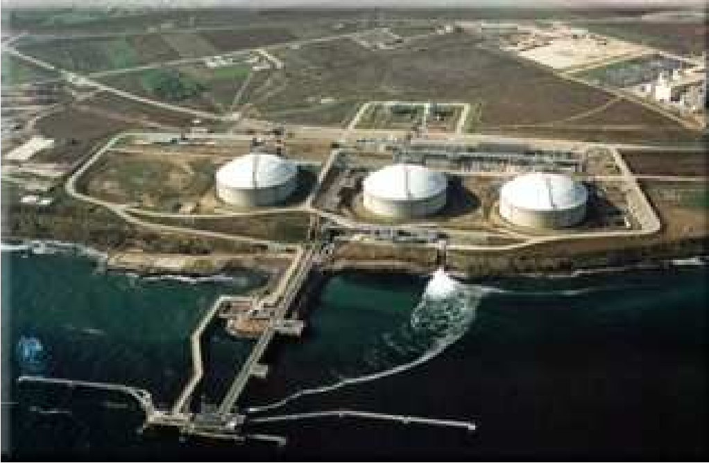
Şekil 2.6. LNG İthal Terminali [16]
