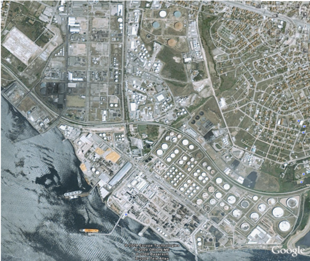
Şekil 4.2. Körfez Rafineri Bölgesi, Çevresindeki Dolum Tesisleri ve Yerleşim Alanlarına Ait Uydur Görüntüsü
