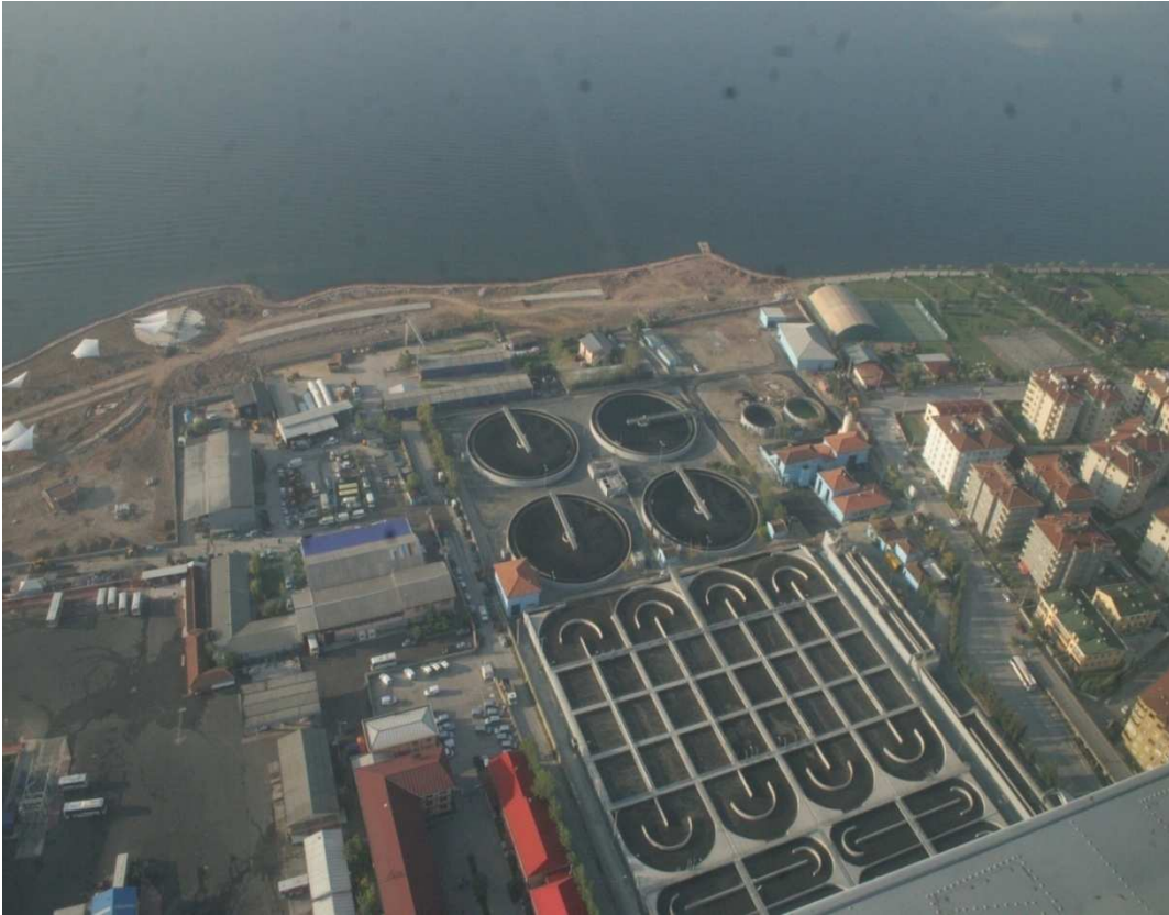
Şekil 4.3. Plajyolu Atıksu Arıtma Tesisi havadan çekilmiş fotoğrafı
