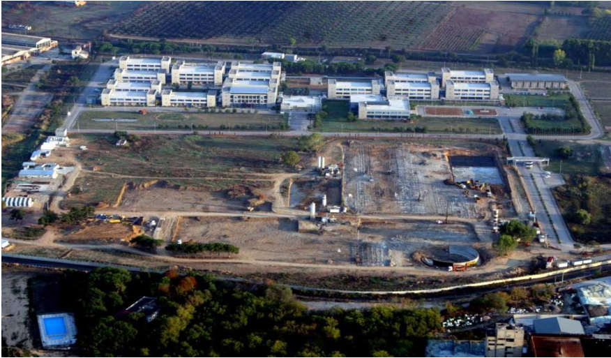
Şekil 4.4. Gebze Atıksu Arıtma Tesisi inşaatı havadan çekilmiş fotoğrafı
