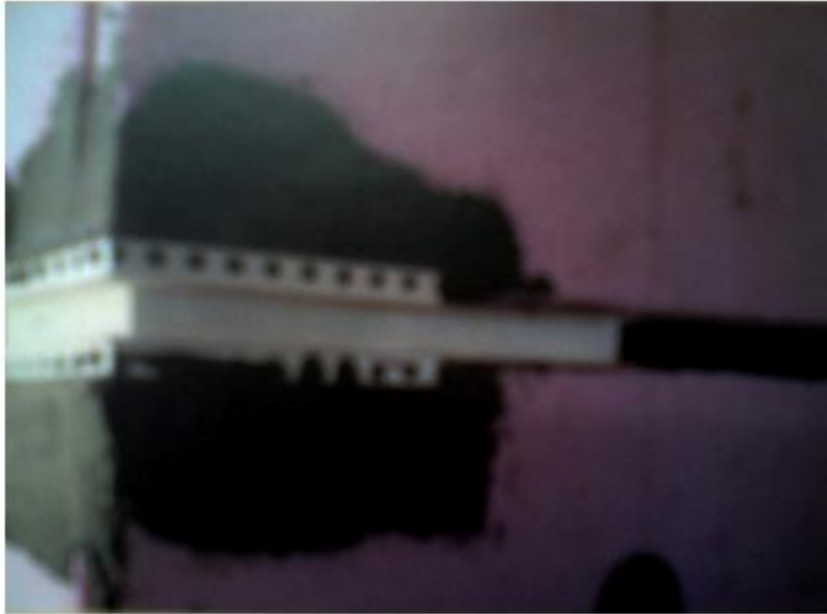
Şekil 4.23. Dilatasyon Profillerinin Uygulanması
