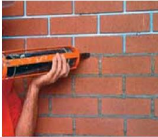
Şekil 4.32. Tuğlaların Arasına Özel Yapıştırıcıların Uygulanması
