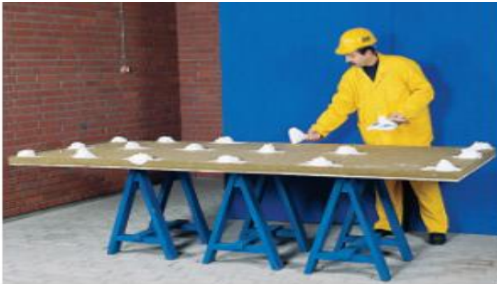
Şekil 4.11. Yapıştırıcı Harcın Yalıtım Levhasına Noktasal Olarak Uygulanması
