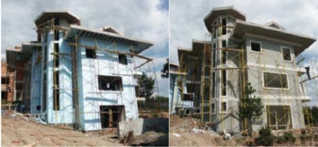
Şekil 4.7. Binalarda Mantolama İşlemi ve İşlemi Takip Eden Yüzey Kaplama İşlemi
