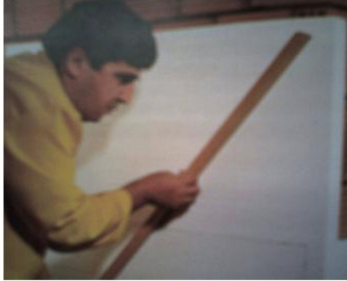
Şekil 4.15. Tam Yapışmayı Sağlamak İçin Levha Yüzeylerine Master Uygulaması
