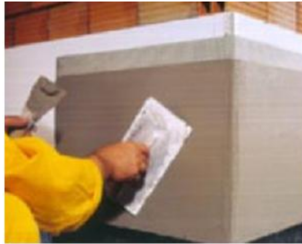
Şekil 4.28. İkinci Kat Sıva Uygulaması
