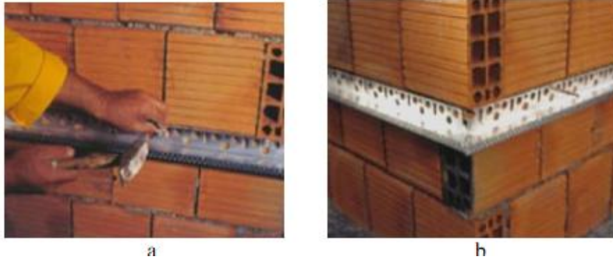
Şekil 4.9. Başlangıç Profilinin Duvara Uygulanması
