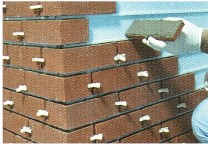
Şekil 4.31. Tuğla Bitirili Son Dekoratif Kaplama
