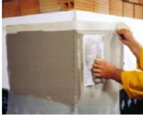
Şekil 4.27. Donatı Filesinin İlk Sıva Katmanı Üzerine Uygulanması
