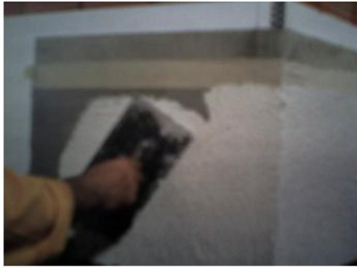
Şekil 4.29. İkinci Kat Yalıtım Sıvası Uygulanması
