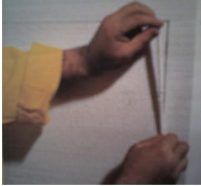
Şekil 4.14. Isı Yalıtım Levhalarının Törpülenmesi
