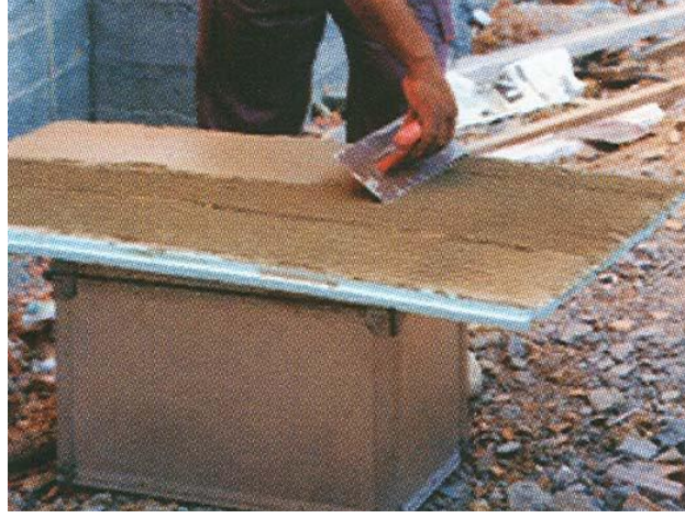
Şekil 4.12. Düzgün Yüzeyle Levha Yüzeyine Tırtıklı Mala İle Yapıştırıcı Uygulaması
