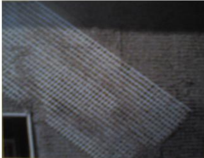
Şekil 4.22. Donatı Filesinin Pencere Köşesine Yatayla 450 Derecelik Açı Yapar Konumunda Uygulanması
