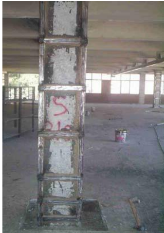
Şekil 5.2. Kolonun çelik ile sarılması
