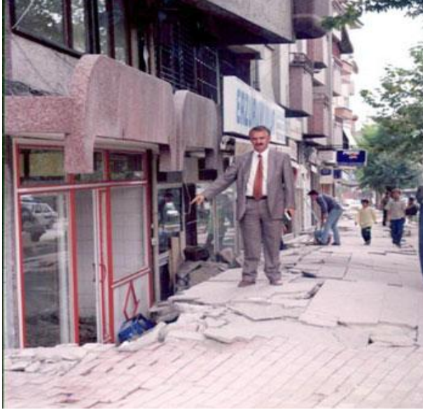
Şekil 3.23. Deprem etkisiyle zeminde meydana gelen oturma
