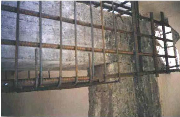
Şekil 5.7. Kiriş mantolanmasında donatılarda sürekliliğin sağlandığı bir kiriş
