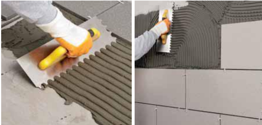
Resim 11. Seramiğin Yapıştırılışı
