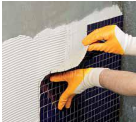
Resim 2. Fiziksel tespit ve bağlama ile seramik uygulaması
