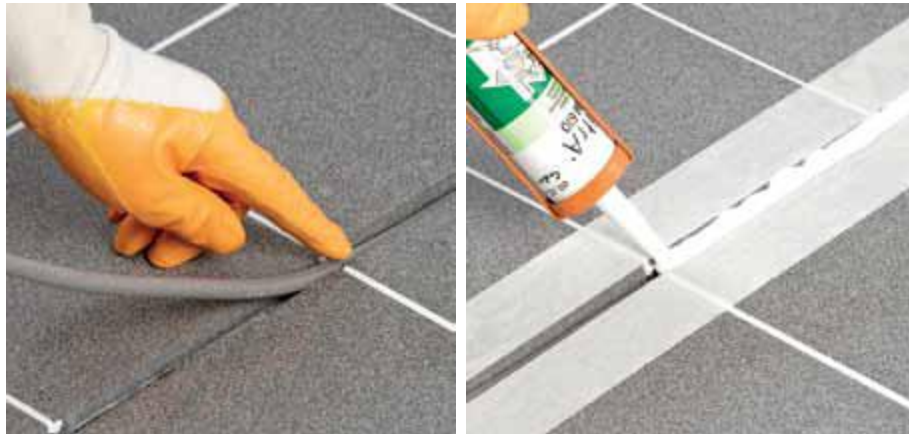
Resim 9. Dilatasyon derzlerinin kullanılması
