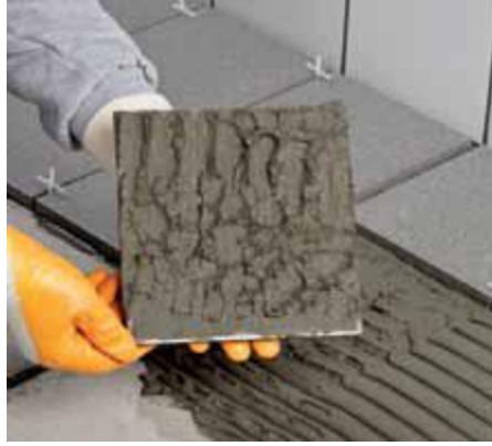
Resim 1. Mekanik tespit ve bağlama ile seramik uygulaması
