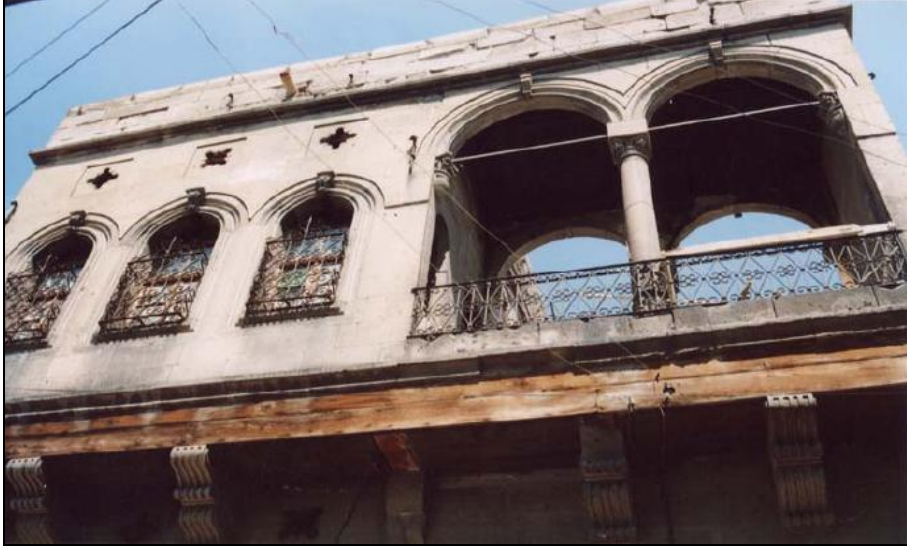
Şekil 2.37. Kayseri Evleri dış cephe örneği (Şükriye Yapılar Evi)
