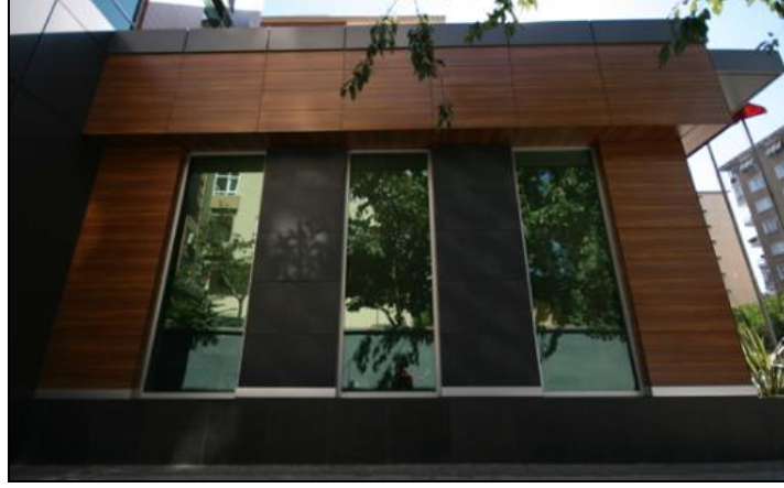
Şekil 3.21. Compact lamine kompozit kaplamalı cephe örneği
