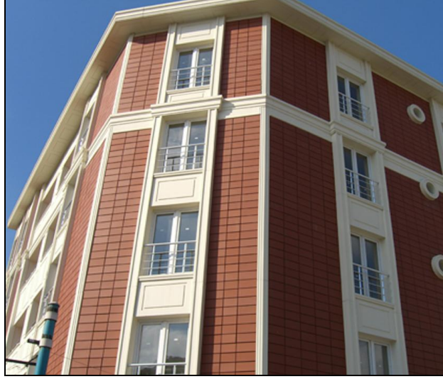
Şekil 3.14. Prese tuğla kaplamalı cephe örnekleri
