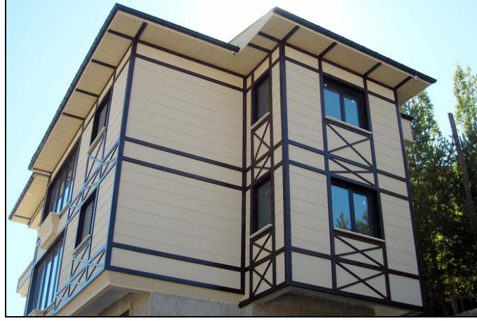
Şekil 3.21. Çimentolu kompozit kaplamalı cephe örneği
