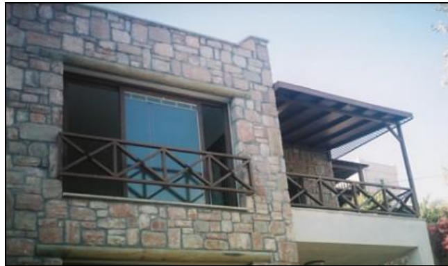
Şekil 3.26. CTP korkuluklu cephe örneği
