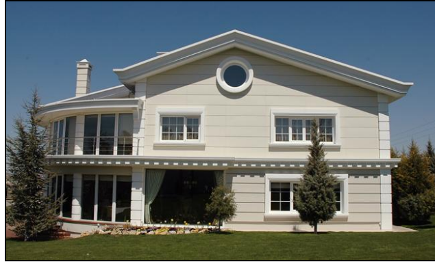
Şekil 3.27. Yüzey dokulu EPS plastik kompozit kaplamalı cephe örneği
