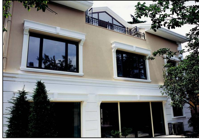
Şekil 3.22. Cam elyaf takviyeli kompozit kaplamalı cephe örneği
