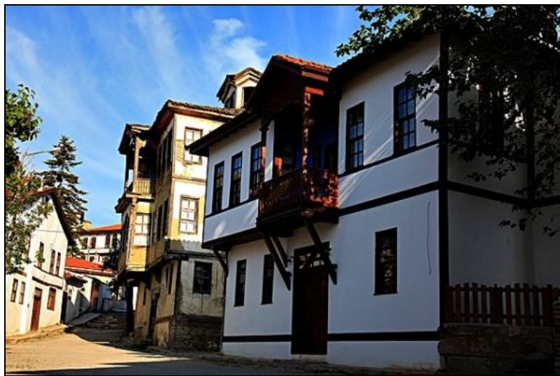
Şekil 2.49. Dış cephe pencere tasarım örneği (Taraklı Evleri)
