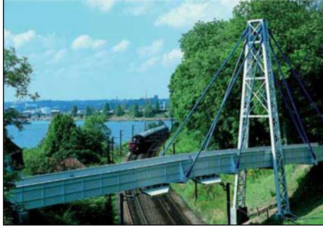
Şekil 4.13. CTP hafif araç ve yaya köprüsü
