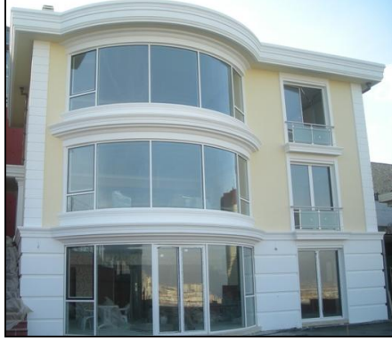
Şekil 3.23. Polimer elyaf takviyeli kompozit kaplamalı cephe örneği
