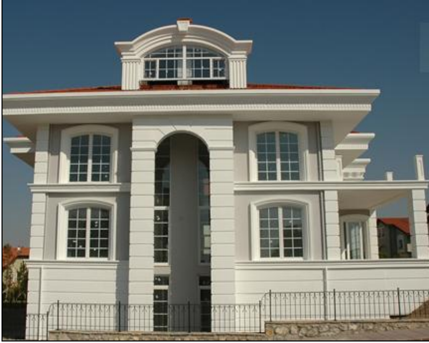
Şekil 1.4. Günümüz dış cephe tasarım örneği
