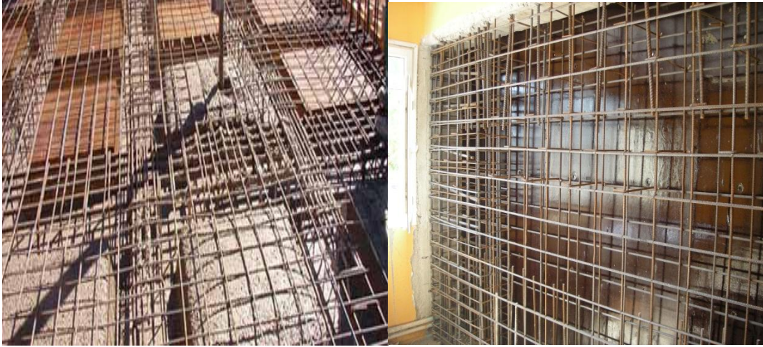
Şekil 2.2. KYB ile betonarme manto uygulamaları
