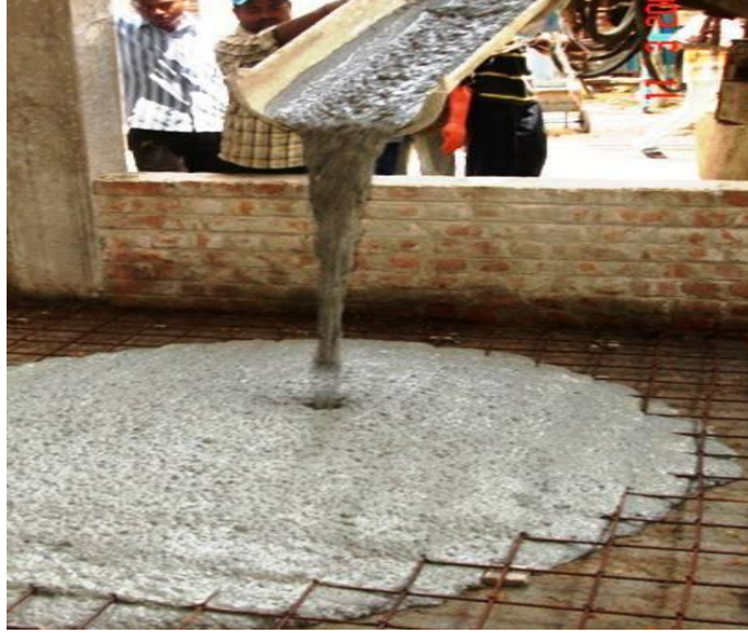
Şekil 2.3. Kendiliğinden yerleşen beton uygulamaları
