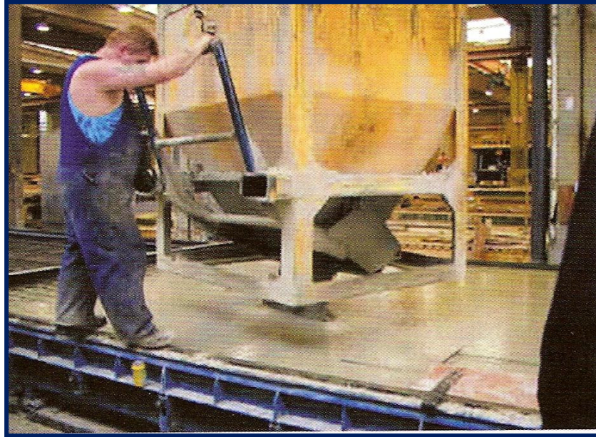
Şekil 2.1. Prefabrike beton üretiminde KYB uygulamaları
