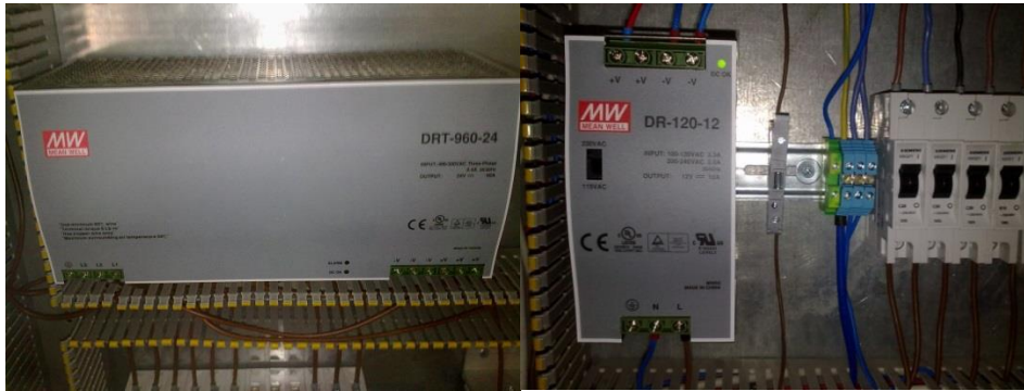
Şekil 4.8. 24V – 12V Güç Kaynakları
