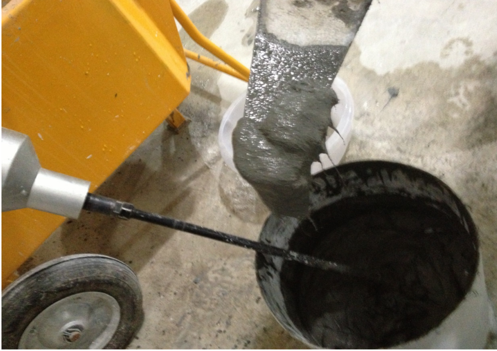
Şekil 4.7. SIFCON içresine lifin katılarak karıştırılması.
