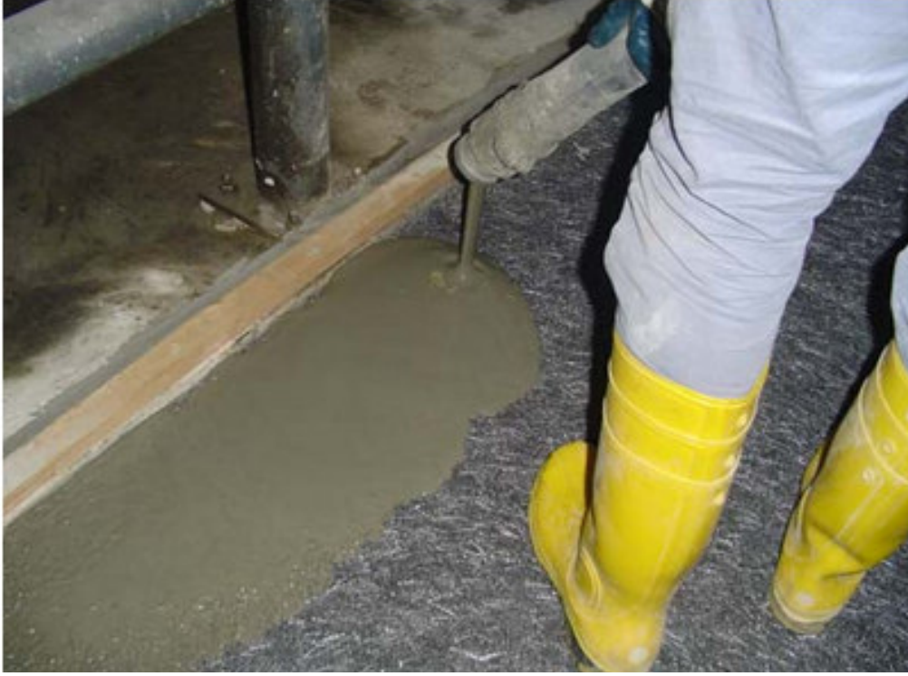
Şekil 2.4. Akıcı bulamacın pompalanması işlemi
