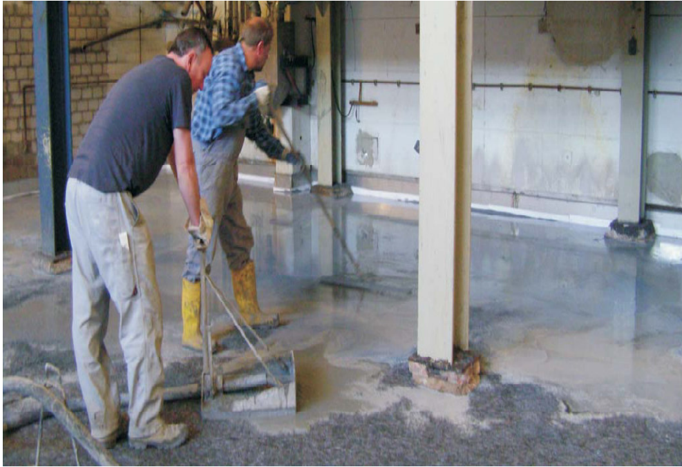
Şekil 2.3. Bulamacın enjekte edilme işlemi
