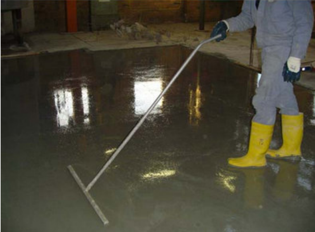
Şekil 2.5. Bulamacın liflerin tamamını örtünceye kadar doldurulması ve yüzey işlemleri
