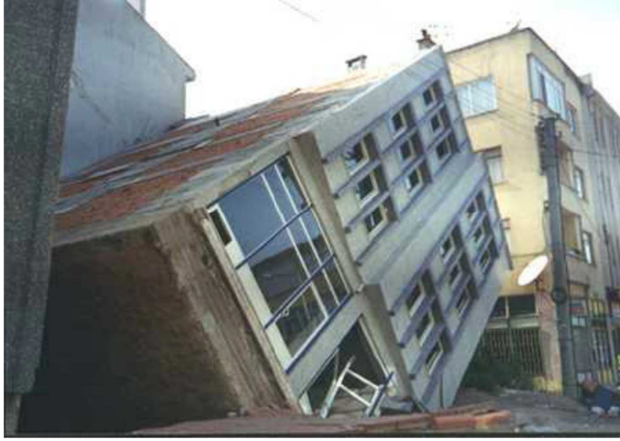
Şekil 2.11. Marmara (1999) depreminde sivilaşma sebebiyle meydana gelen yapı hasarları
