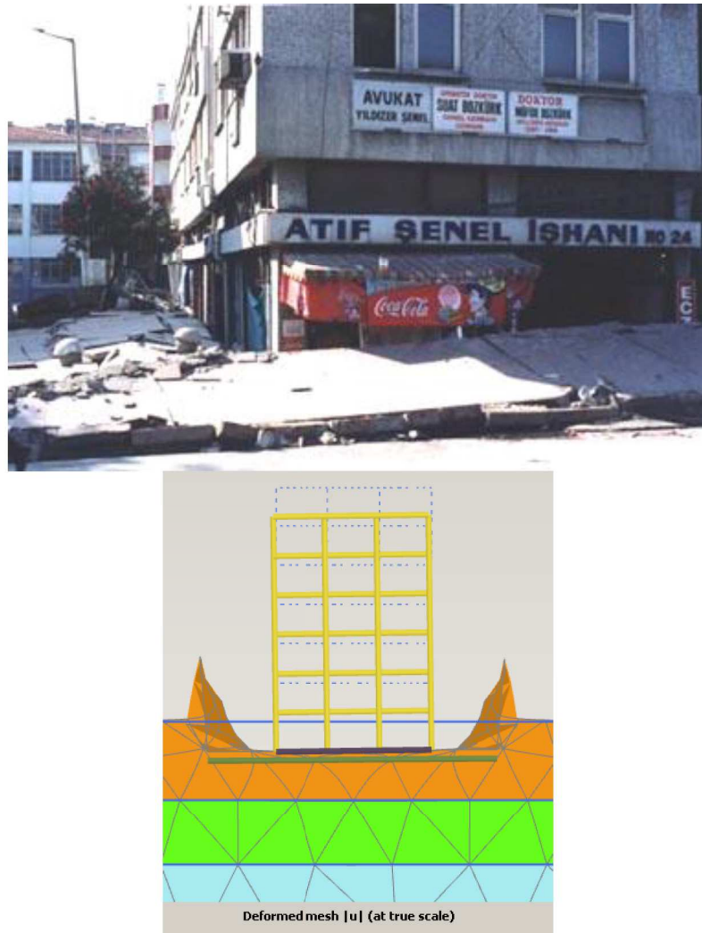
Şekil 4.4. Temel taşıma gücü aşılmasına örnek ve sonlu eleman modeli
